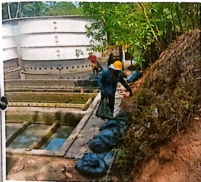
Imagen 7: Seguimiento preventivo empaque de lodos
