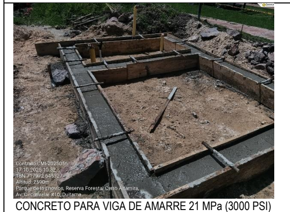
CONCRETO PARA VIGA DE AMARRE 21 MPa (3000 PSI)
