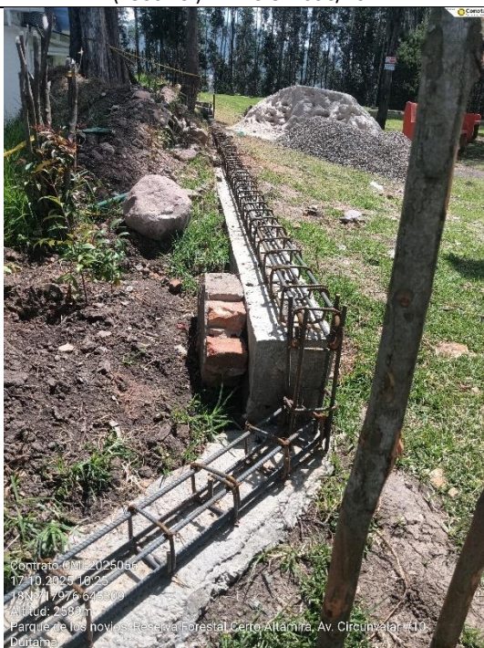
SUMINISTRO, FIGURADA Y AMARRE DE ACERO DE REFUERZO, VIGA DE CIMENTACIÓN
