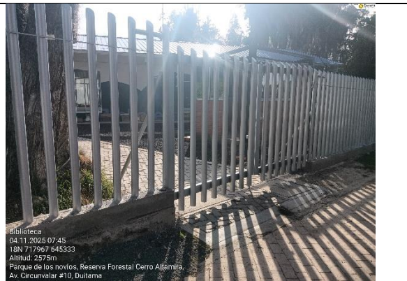
CERRAMIENTO EN TUBO GALVANIZADO DE 2 1/2 X 2mm SOBRE VIGA EN CONCRETO DE 3000 PSI
