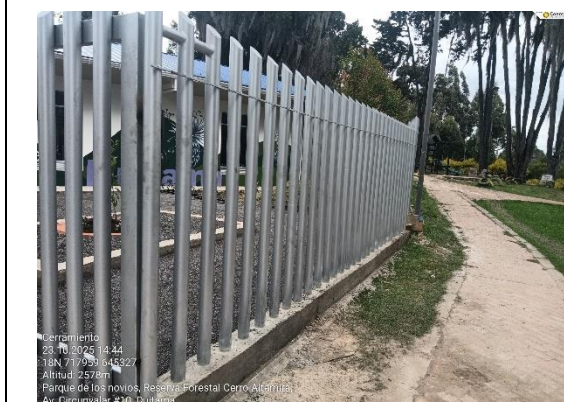
CERRAMIENTO EN TUBO GALVANIZADO DE 2 1/2 X 2mm SOBRE VIGA EN CONCRETO DE 3000 PSI
