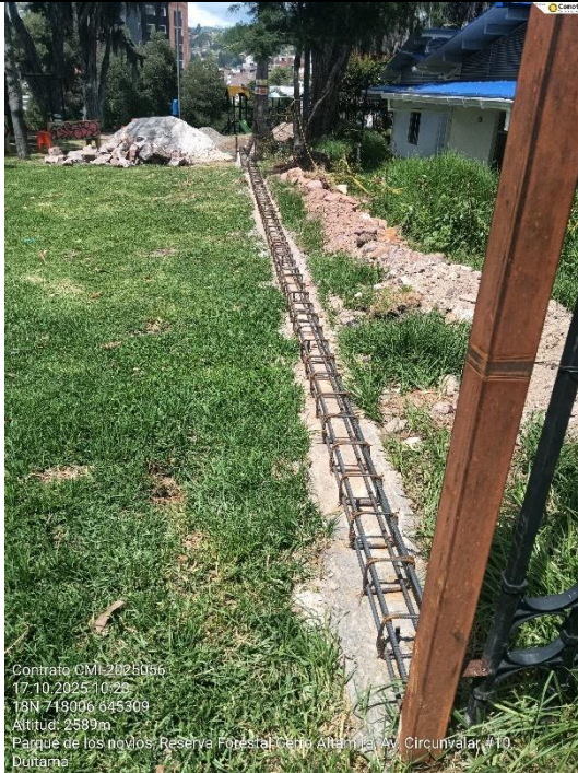
REFUERZO EN ACERO LONGITUDINAL VARILLA 1/2" Y ACERO TRASVERSAL 3/8"
