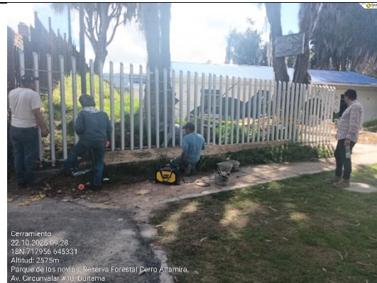
TUBO GALVANIZADO DE 2 1/2 X 2mm anclado en acero de refuerzo de viga de cimentación
