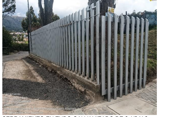
CERRAMIENTO EN TUBO GALVANIZADO DE 2 1/2 X 2mm SOBRE VIGA EN CONCRETO DE 3000 PSI
