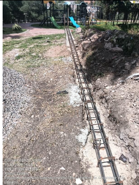
4 VARILLAS LONGITUDIANALES 1/2" REFUERZO TRASVERSAL 3/8" CADA 20 CM
