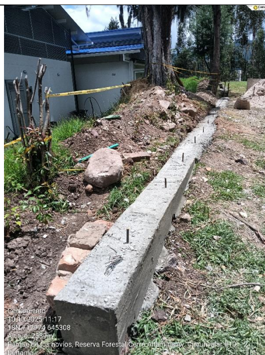
Mejoramiento en CONCRETO CICLÓPEO y pines de anclaje para viga de cimentación
