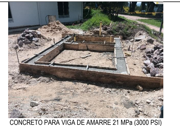
CONCRETO PARA VIGA DE AMARRE 21 MPa (3000 PSI)
