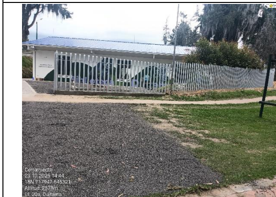
CERRAMIENTO EN TUBO GALVANIZADO DE 2 1/2 X 2mm SOBRE VIGA EN CONCRETO DE 3000 PSI
