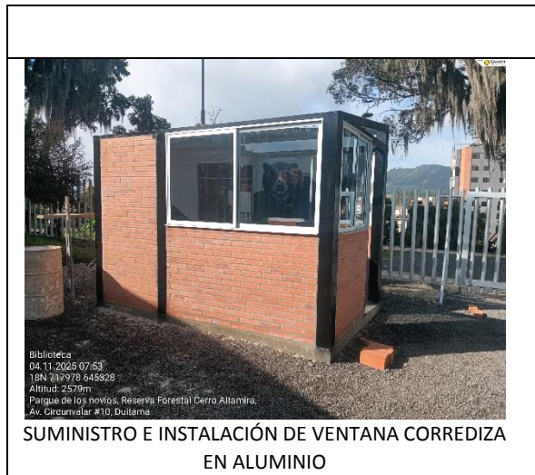
MURO EN LADRILLO PRENSADO MACIZO E = 0.12 M.
