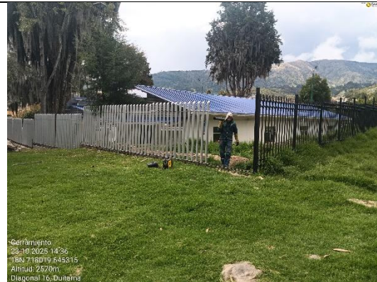
INSTALACIÓN DE CERRAMIENTO EN TUBO GALVANIZADO DE 2 1/2 X 2mm SOBRE VIGA EN CONCRETO DE 3000 PSI
