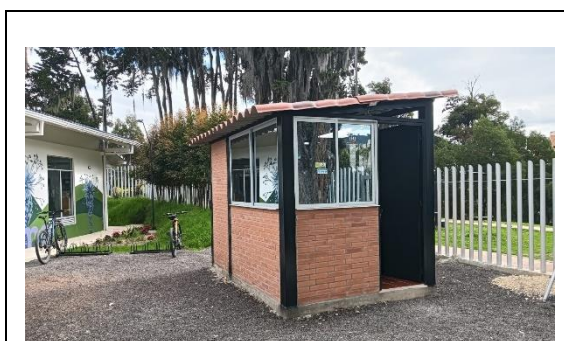
CASETA DE VIGILANCIA
