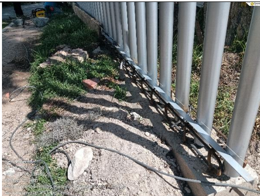
TUBO GALVANIZADO DE 2 1/2 X 2mm anclado en acero de refuerzo de viga de cimentación
