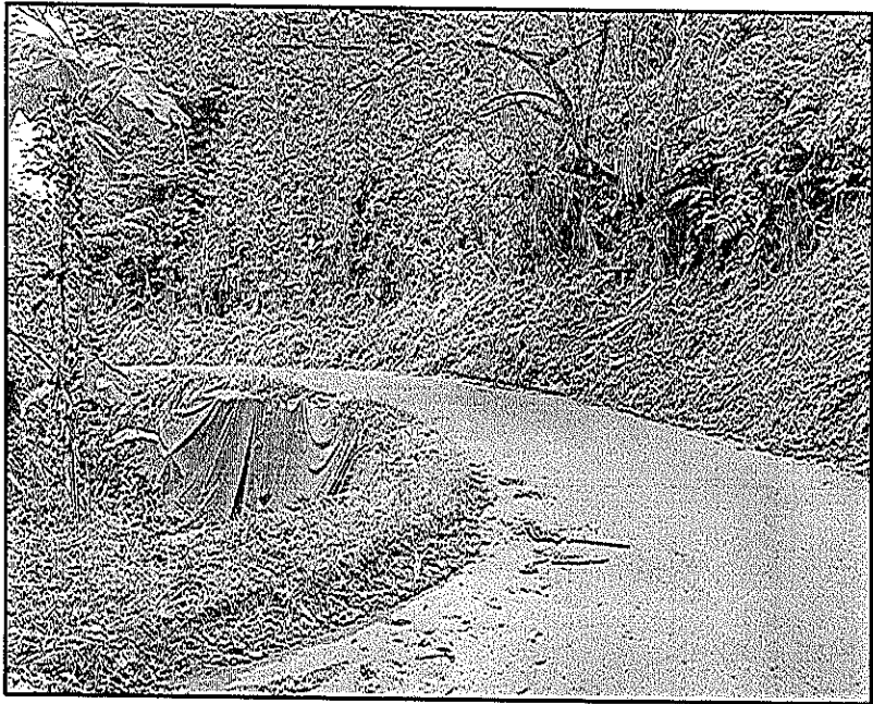
Estado de Talud Superior 2023
