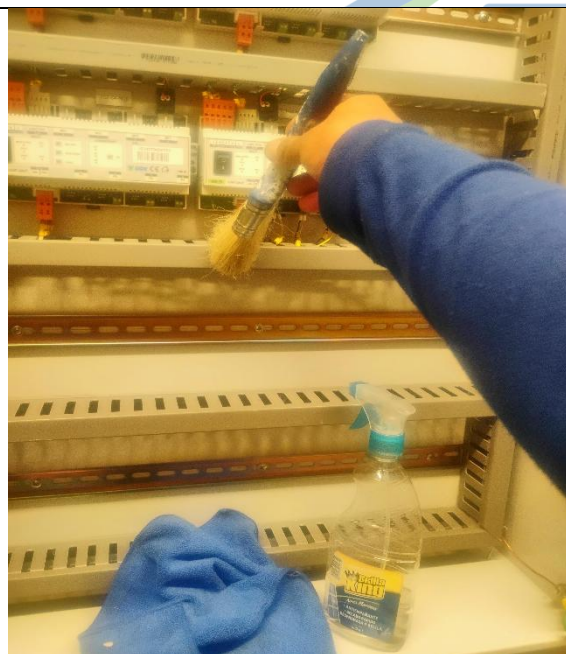
Ilustración 53. Limpieza Tableros de iluminación ST4
