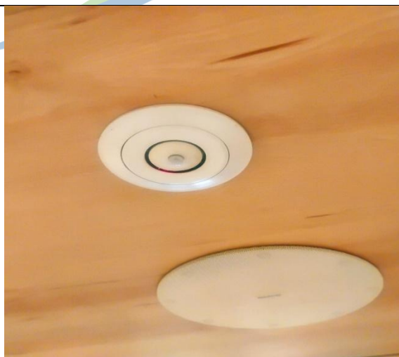
Ilustración 66. Mant. Sensores de presencia P3
