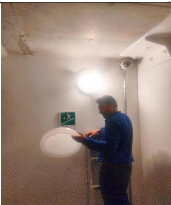
Ilustración 17. Mant. Apliques de pared Esc-Oriental
