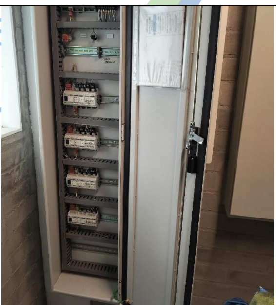
Ilustración 62. Limpieza Tableros de iluminación P8
