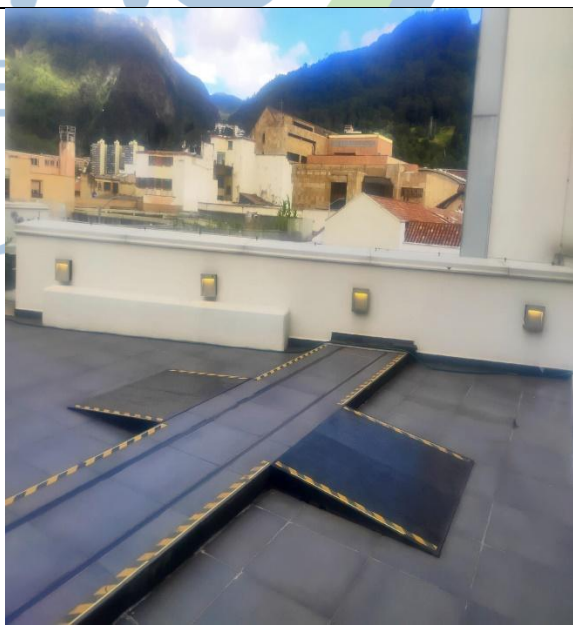
Ilustración 132. Mant. Luminaria Terraza
