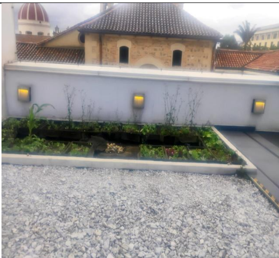
Ilustración 133. Mant. Luminaria Terraza
