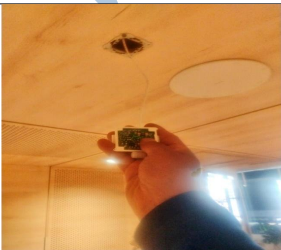
Ilustración 65. Mant. Sensores de presencia P3
