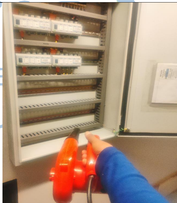
Ilustración 54. Limpieza Tableros de iluminación ST1
