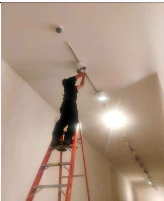
Ilustración 11. Mant. Riel piso 1
