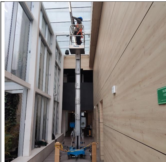
Ilustración 87. Mant. Luminaria lineal P2
