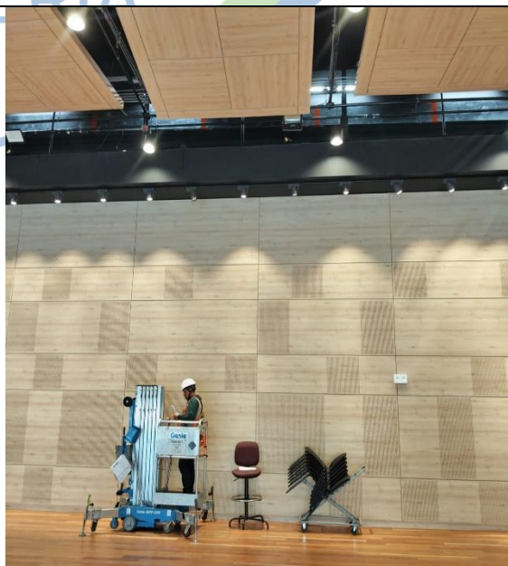
Ilustración 126. Mant. Luminaria Spot led P6
