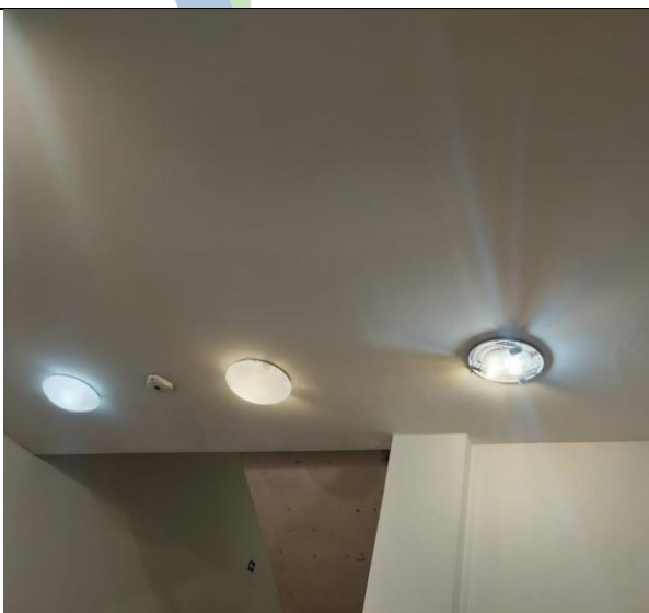
Ilustración 21. Mant. Apliques de techo Piso 2
