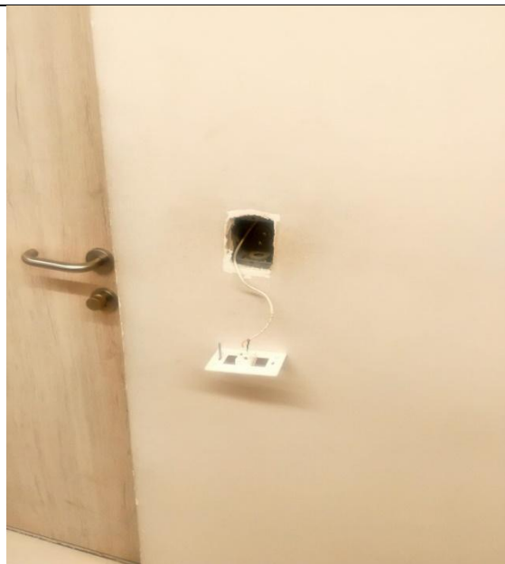
Ilustración 69. Mant. Botoneras de iluminación P1
