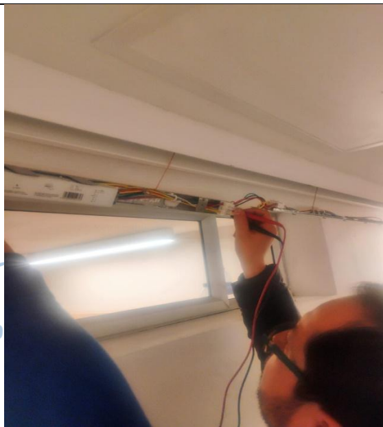
Ilustración 76. Mant. Luminaria lineal P6
