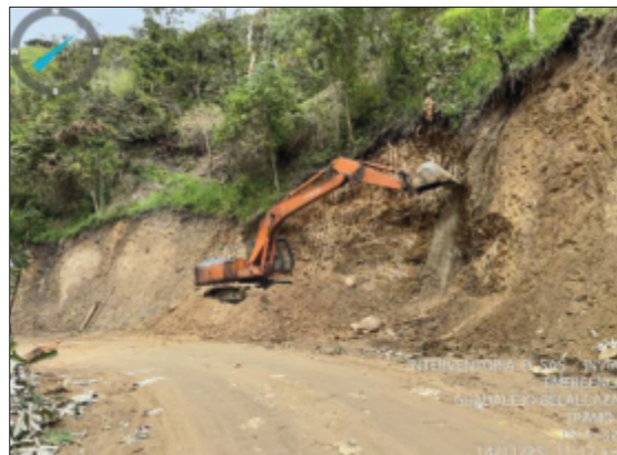
Fotografía 11. Corte y ampliación de carril
