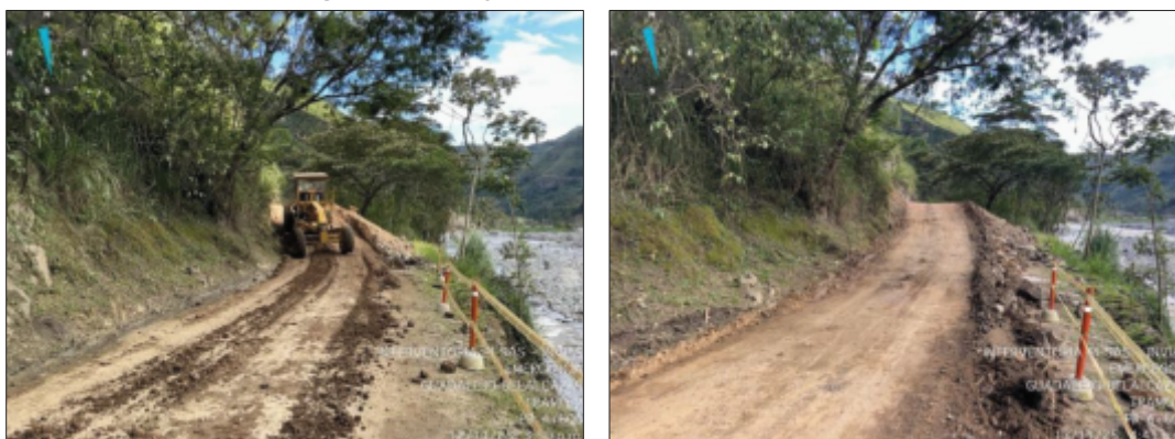
Fotografía 10. Mejoramiento curva vertical tramo 2
