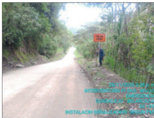
Foto Instalación de señalización preventiva de obra.
