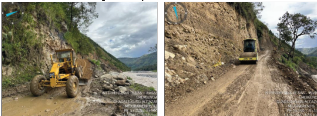
Fotografía 9. Mejoramiento en el tramo 3
