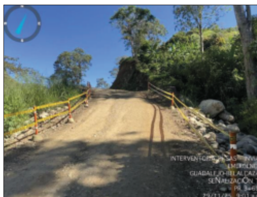
Foto delimitación de zonas de trafico con cinta restricción de peligro y delineadores tubulares
