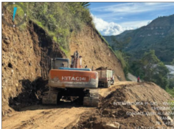
Fotografía 11. Corte y ampliación de carril
