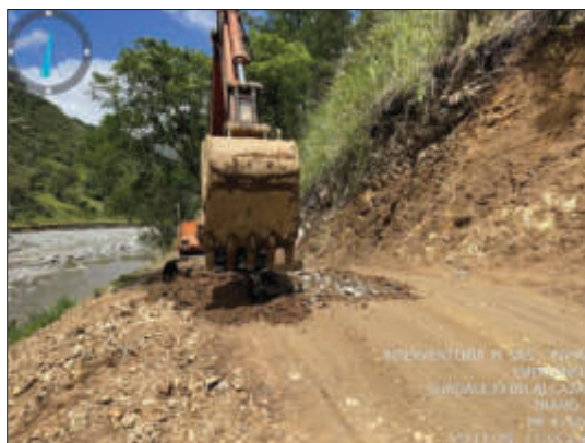
Fotografía 8. Aplicación de material de recebo
