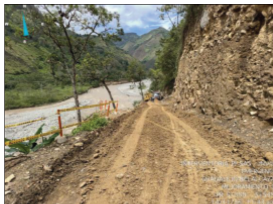
Fotografía 8. Aplicación de material de recebo
