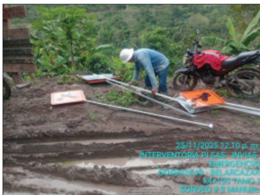
Foto Instalación de señalización preventiva de obra.
