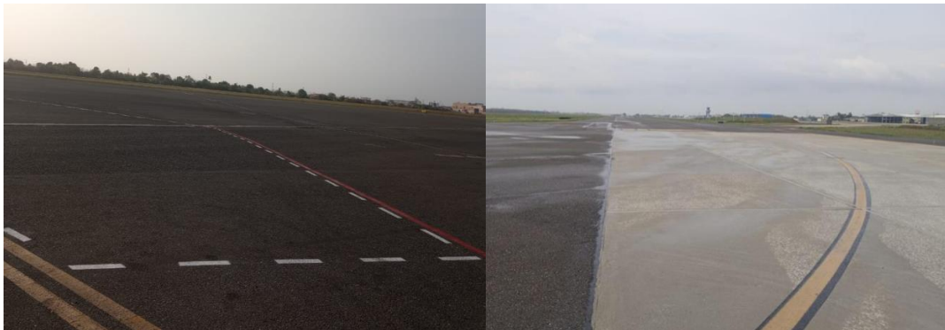
Ilustración 7 Estado actual de la Plataforma del Aeropuerto
