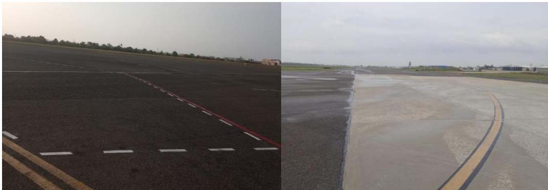
Ilustración 7 Estado actual de la Plataforma del Aeropuerto
