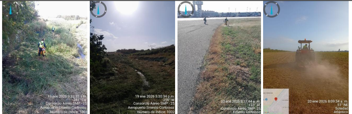
Rocería con equipo manual y mecánico y poda de arbolado en canales perimetrales
