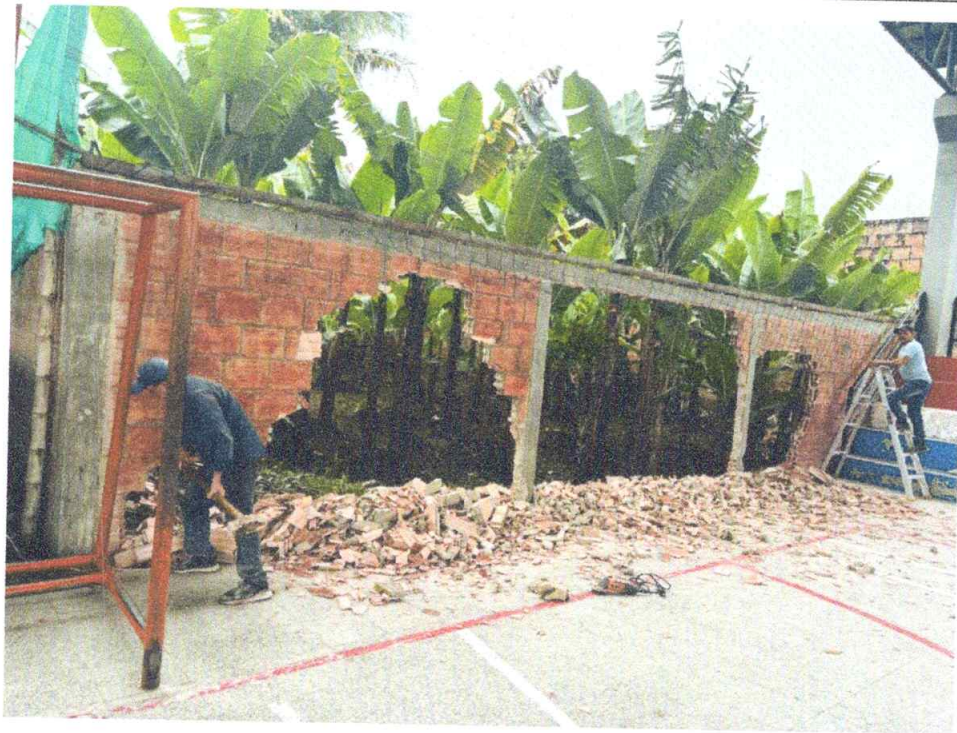
DEMOLICION MURO EN MANPOSTERIA
