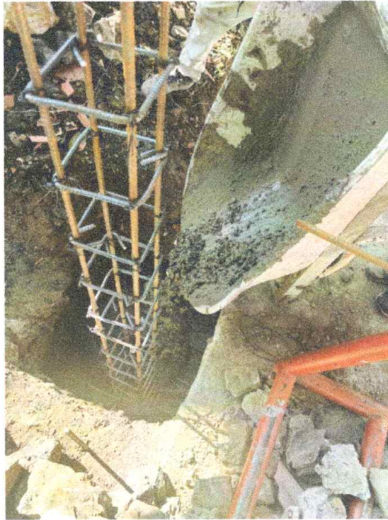
CONSTRUCCION CONCRETOS ALZADOS Y CIEMNETACION
