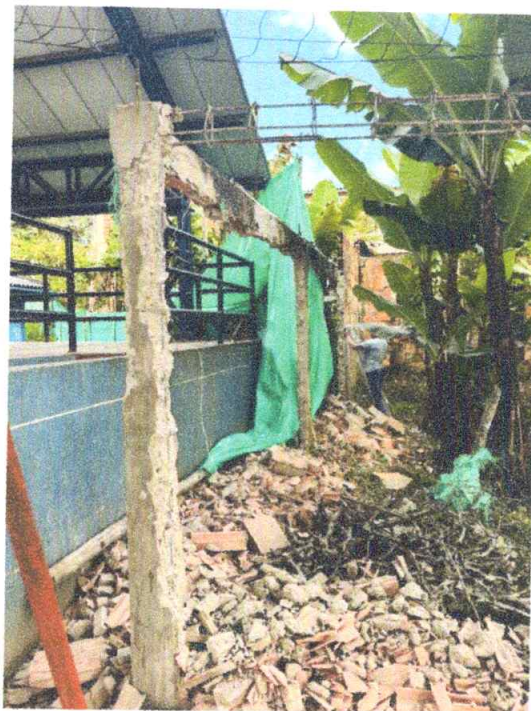
DEMOLICION MURO Y ESTRUCTURAS EN CONCRETO
