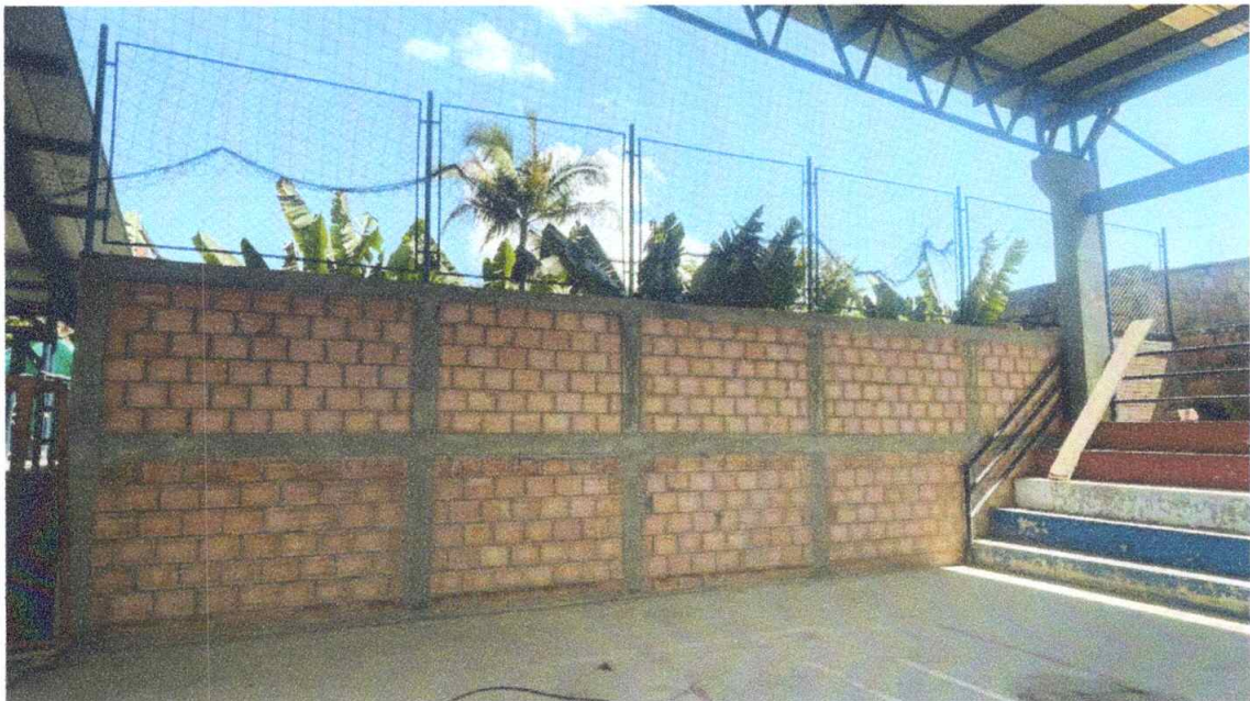
INSTALACION CERRAMIENTO SUPERIOR
