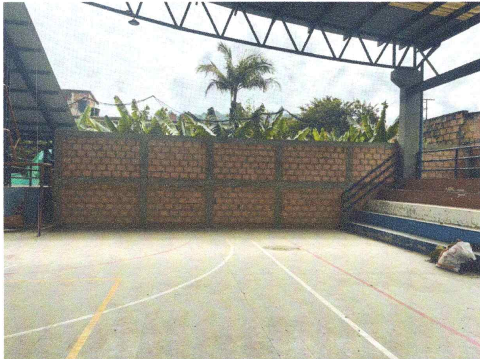
MURO EN MANPOSTERIA ALTURA 3,25 ,M
