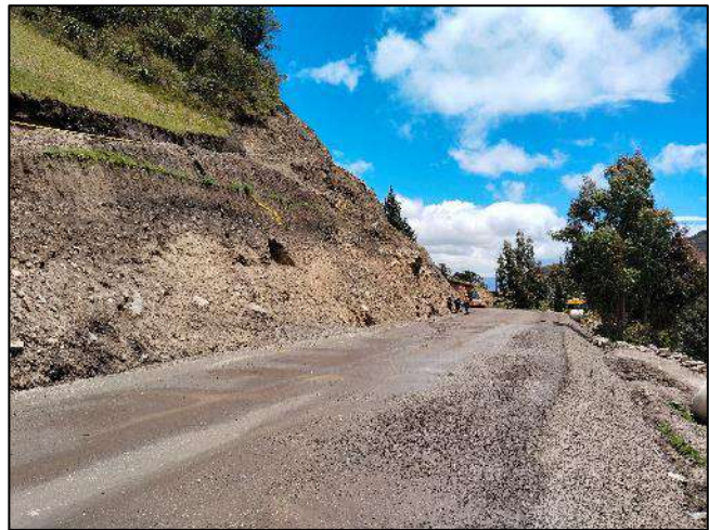
Vista general del sector del PR51+600 de la Ruta 6404.
