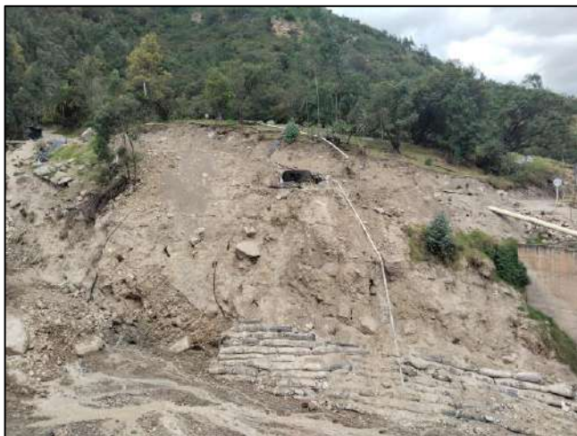
Los bolsacretos dispuestos aguas arriba de la localización del puente vehicular existente sobre la quebrada "El Boche" margen Paz del Río.
