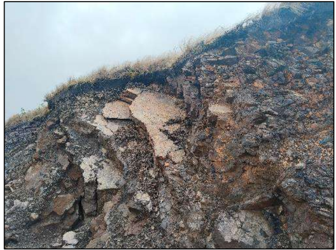
Talud de corte fuertemente fracturado y diaclasado.
