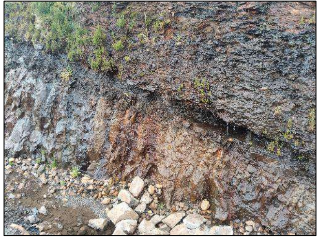
Presencia de nivel freático en la base de los taludes de corte.
