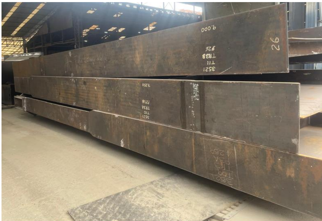
Figura 1. Avance Puente San Pascual Etapa I
