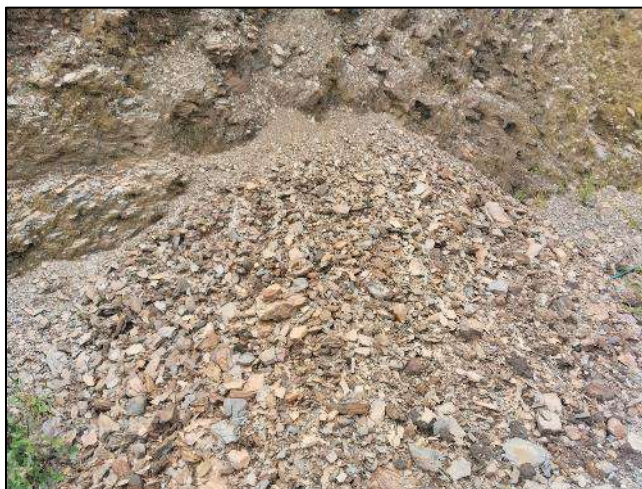
Fotografía 6 Sitio crítico del PR58+650 de la Ruta 6404.
