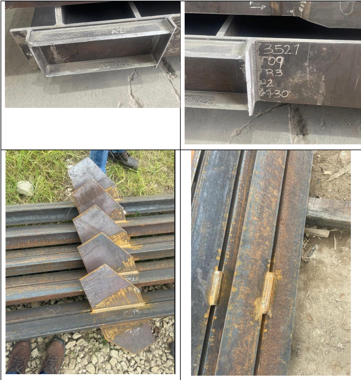
Figura 4. Soldaduras en conexiones
