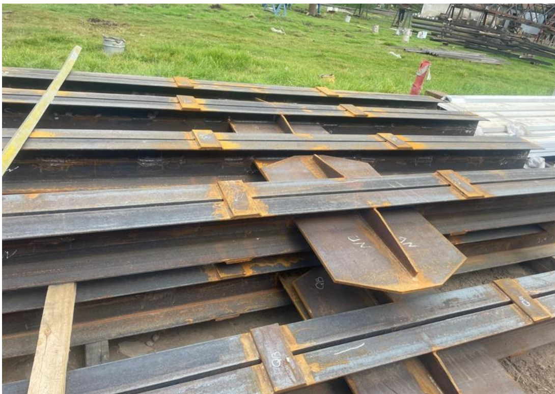
Figura 5. Soldaduras en conexiones
