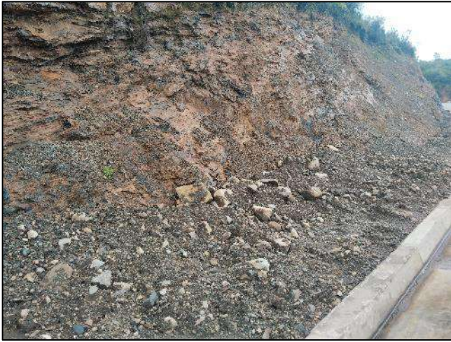
Producción de suelo residual de lutita de la Formación Chipaque y depositación en la base de los taludes de corte.
