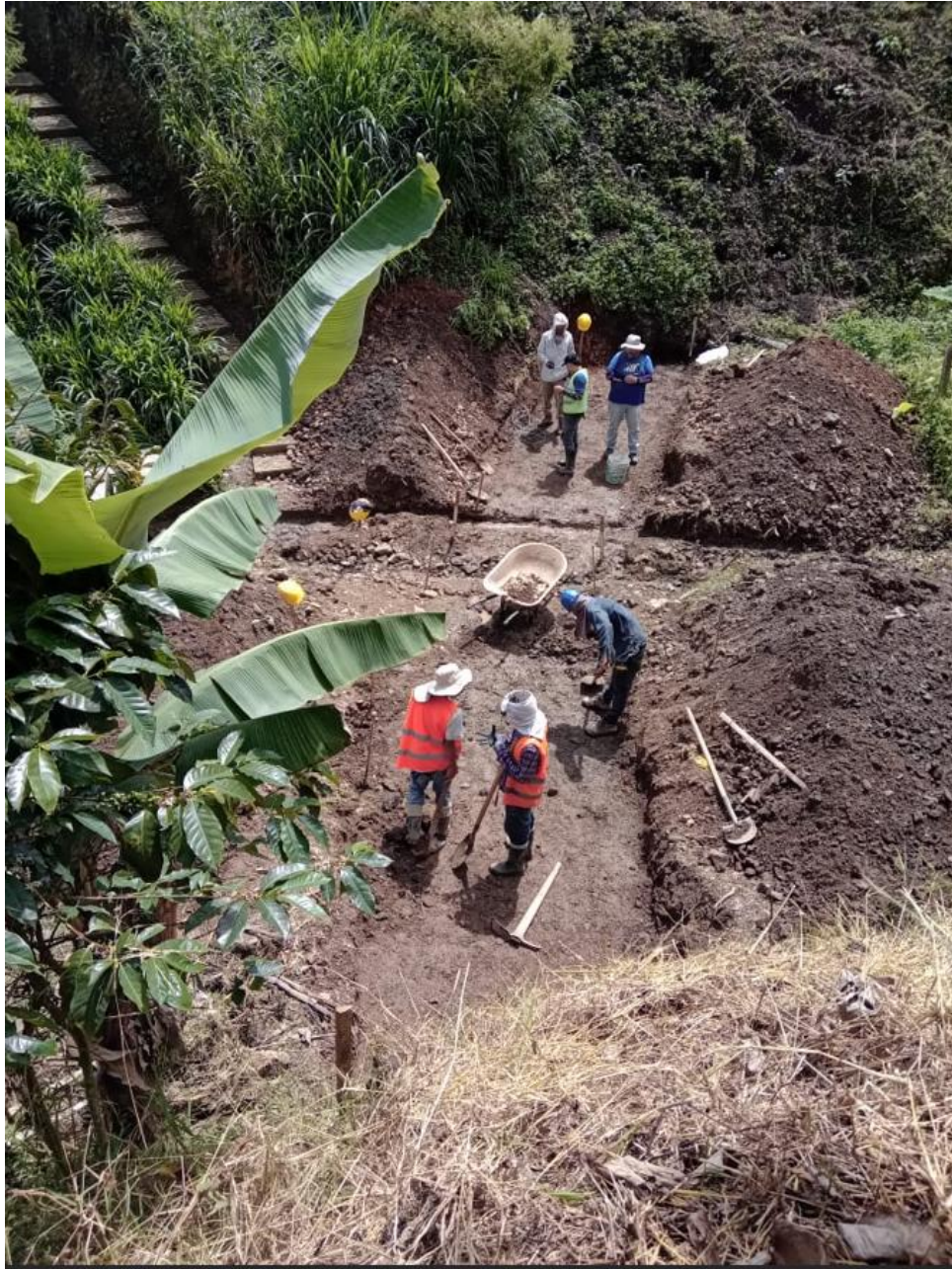
Localización dique No 4 sector Semilleros
