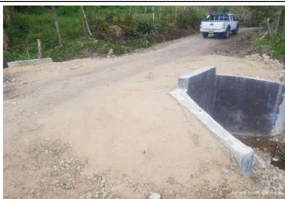
Alcantarilla construida
