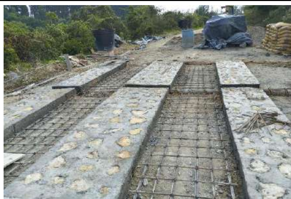
Construcción de placas huellas
