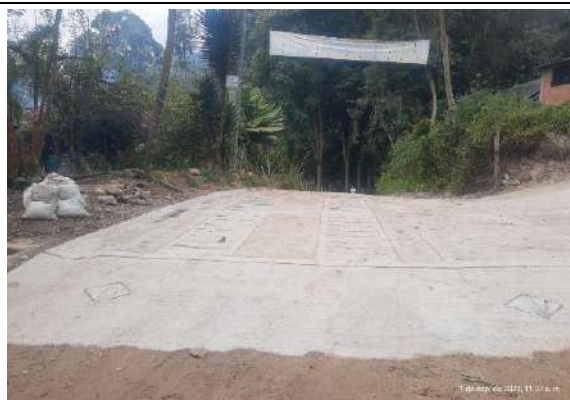
Placa de acceso a Placas huellas construidas.
