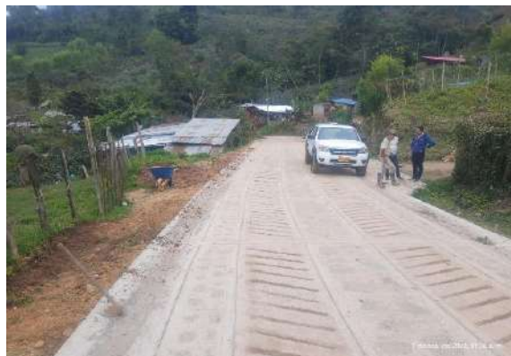
Placa huella construida en el Tramo # 1
