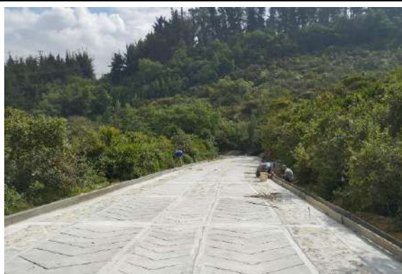
Construcción placa huella PR1+282 hacia mayores
