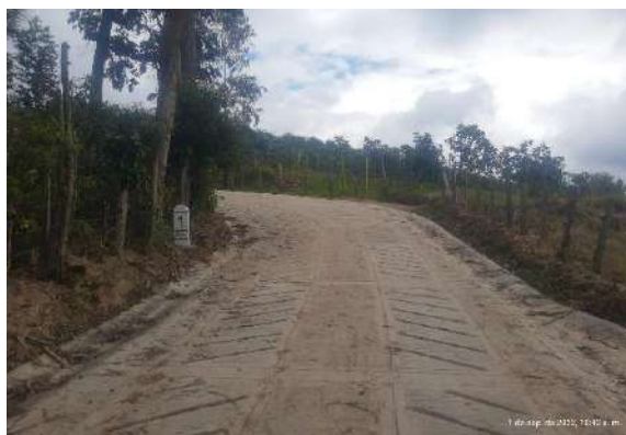
Placa huella construida en el Tramo # 2
