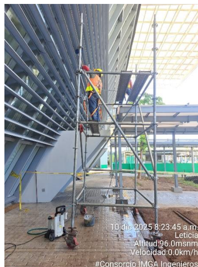
Limpieza de fachadas Modulo 03 LA
