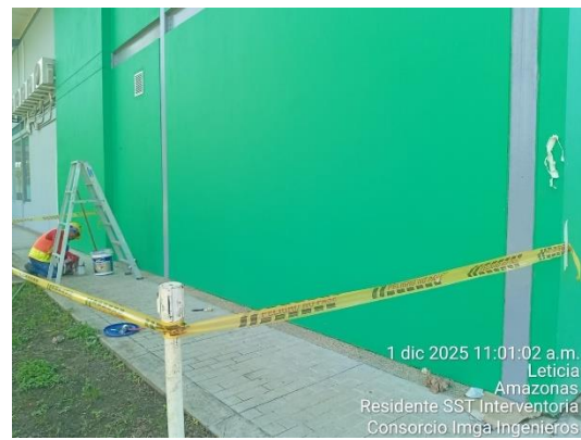
Detallado y repinte muros bloque soporte tecnico
