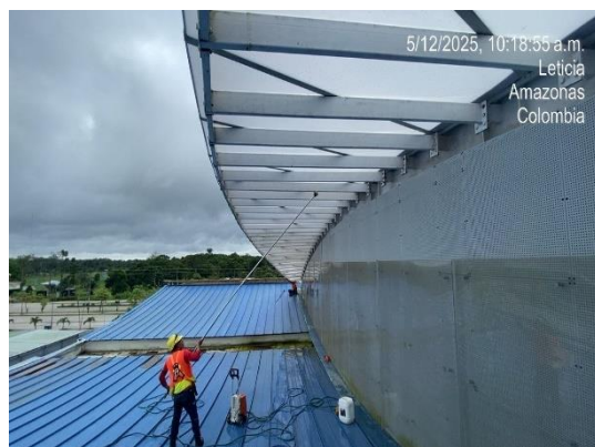
Limpieza estructura de aleros de cubiertas M1, M2 y M3
