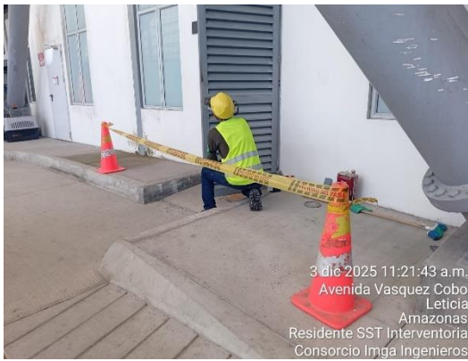
Resane/repinte de puertas metalicas salida Sanidad
