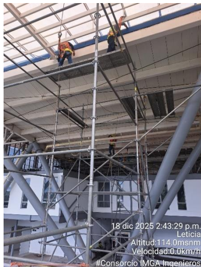
Trabajos limpieza de cubierta de aleros M2, LA, incluyendo estructura de cubiertas
