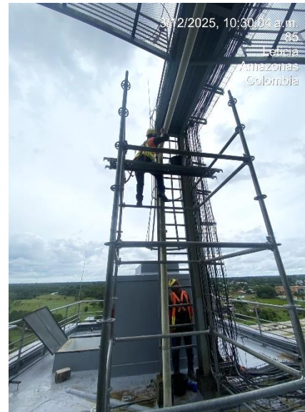
Limpieza bajantes losa técnica y sobre cabina TWR
