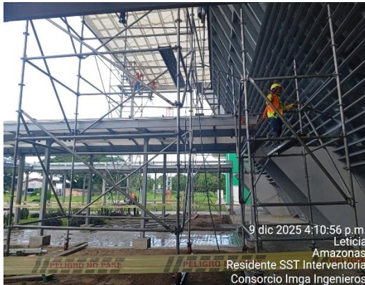
Limpieza general fachadas y aleros
