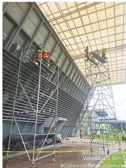
Mantenimiento, limpieza M3 Lado Aire
