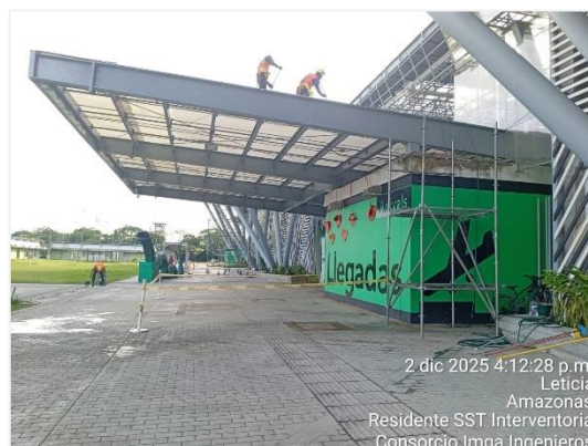
Limpieza de cubiertas y estructura de soporte, sobre tramo acceso 01 Terminal de pasajeros
