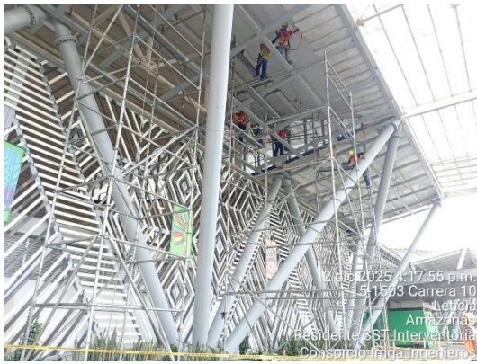
Instalacion de andamios, limpieza de cubiertas y estructura
