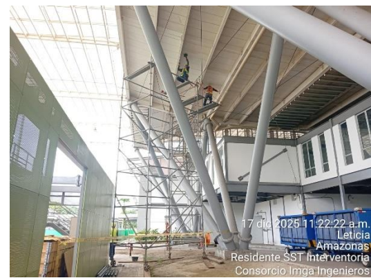
Limpieza cubiertas y estructura soporte, instalacion de andamios y señalizacion zonas de trabajo
