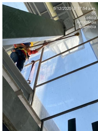
Limpieza fachada M2. Lado Aire M2
