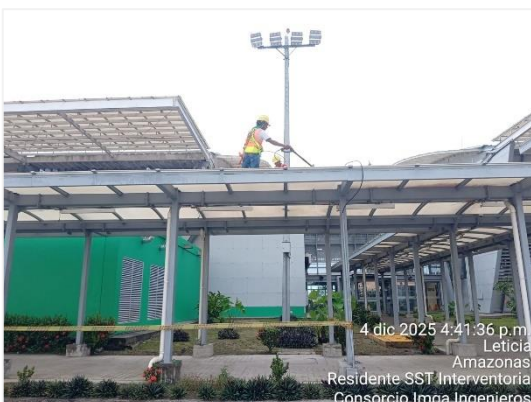
Limpieza de pasarelas Lado Aire, incluyendo estructura de soporte y bajantes existentes
