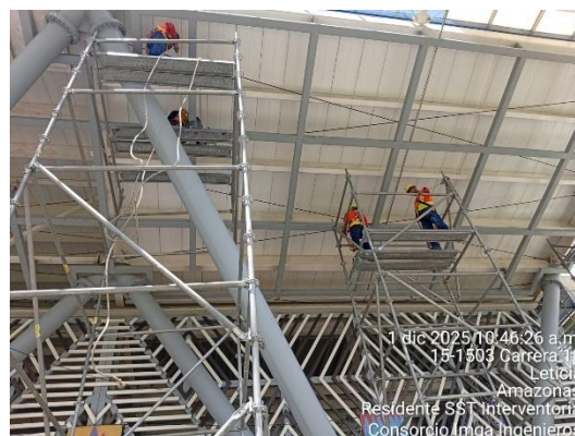
Trabajos limpieza estructura cubiertas
