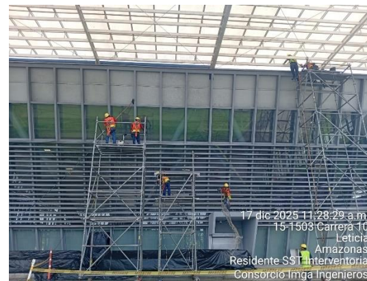
Trabajos de limpieza Modulo 03
