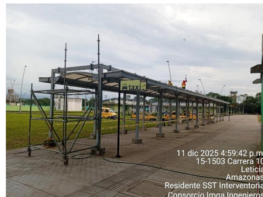
Trabajos de limpieza de pasarelas Lado Tierra, incluyendo estructura de soporte y bajantes existentes
