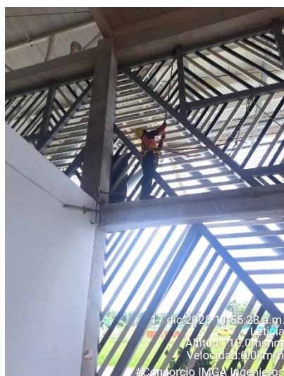
Limpiezas fachadas M1 LT, cara interna
