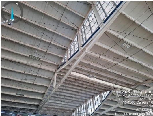
Limpieza de cubiertas internas, sala de abordaje, estado actual
