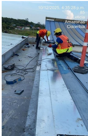
S.I flanches metálicos, tramos cubierta M1, se reparan zonas laterales, sobre canales
