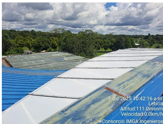
S.I de aleros en Policarbonato Modulo 02
