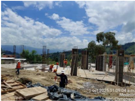
Nivel 0.00 Armado de columnas
