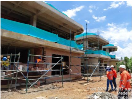
Instalación de mampostería en fachada nivel-7.60
