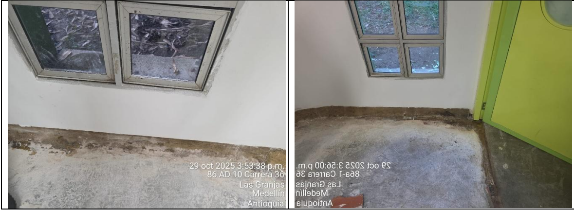
Imágenes tomadas el 29 de octubre de 2025 – Recorrido de obra.
