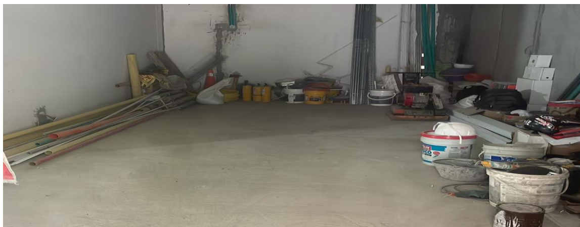
Adecuación de área bodega de Materiales
