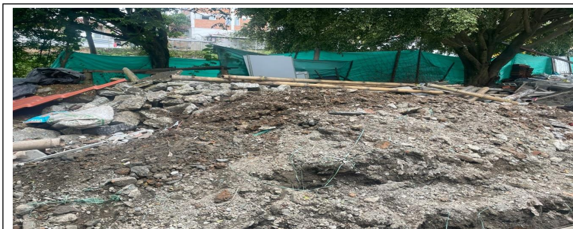
Acopio de RCD
