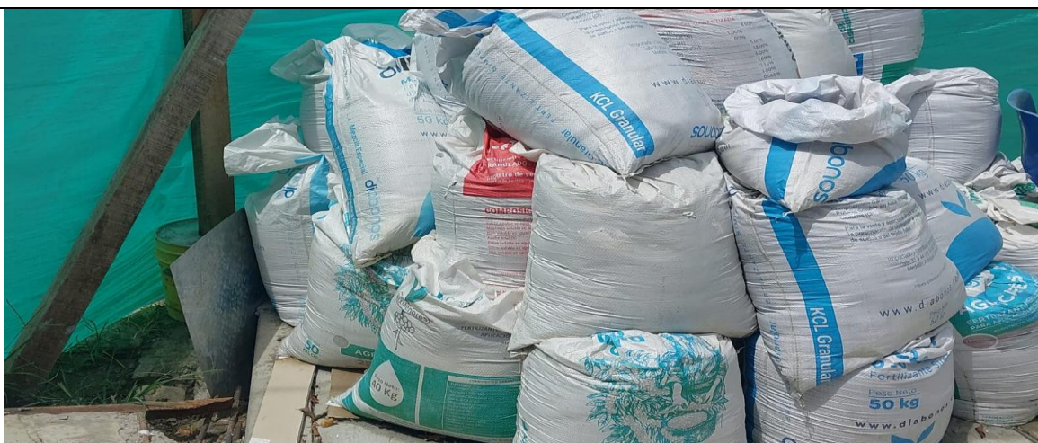
Acopio de RCD
