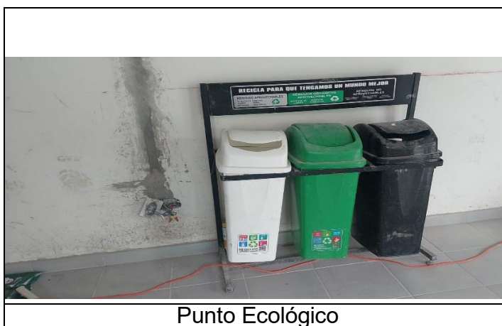
Figura 2. Ubicación punto ecológico en obra
