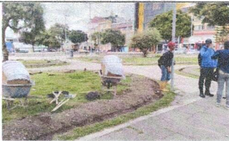
Ilustración 7 Preparación del terreno y materiales para la adecuación
