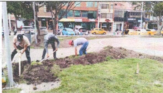
Ilustración 8 Trabajo de excavación y movimiento de tierra
