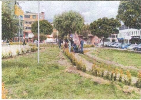
Ilustración 5 Suministro y plantación en adecuación de zonas verdes
