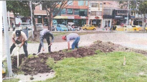
Ilustración 8 Trabajo de excavación y movimiento de tierra
