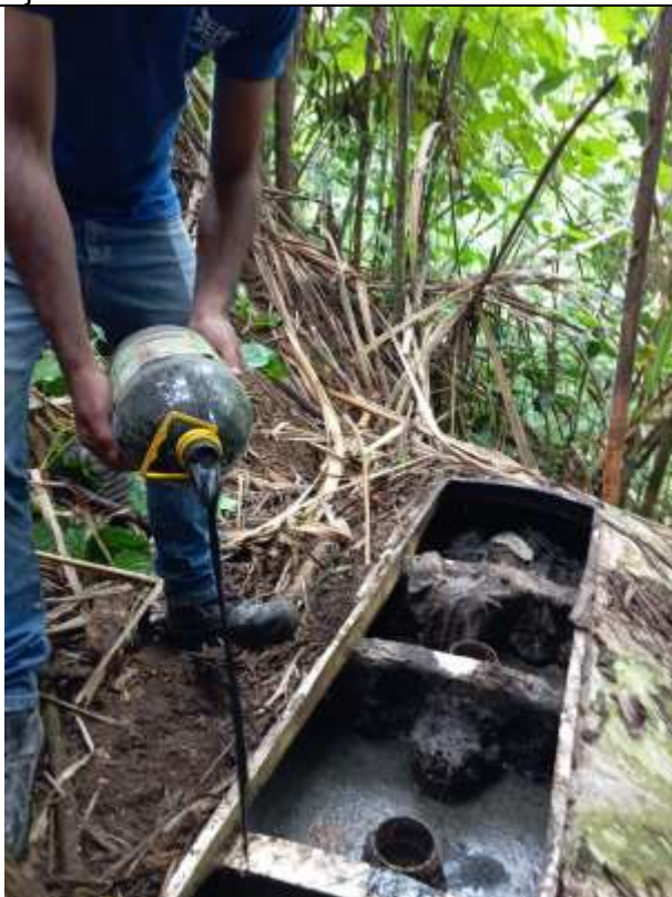
Foto 28: Seguimiento ejecución de actividades en obra
