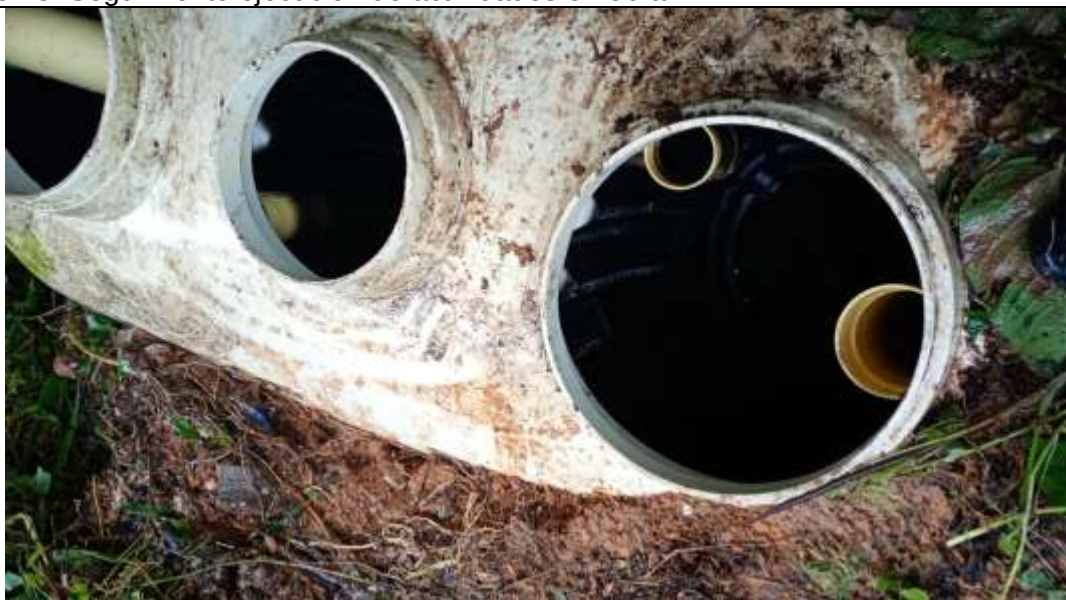
Foto 14: Seguimiento ejecución de actividades en obra
