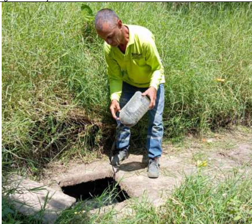
Foto 20: Seguimiento ejecución de actividades en obra
