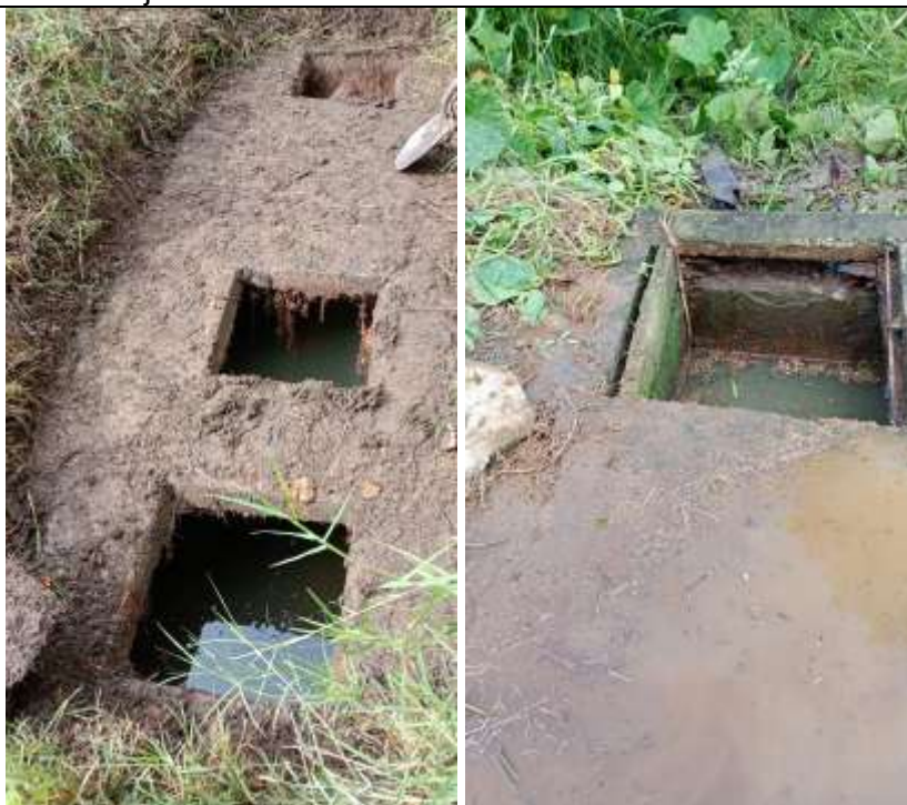
Foto 18: Seguimiento ejecución de actividades en obra
