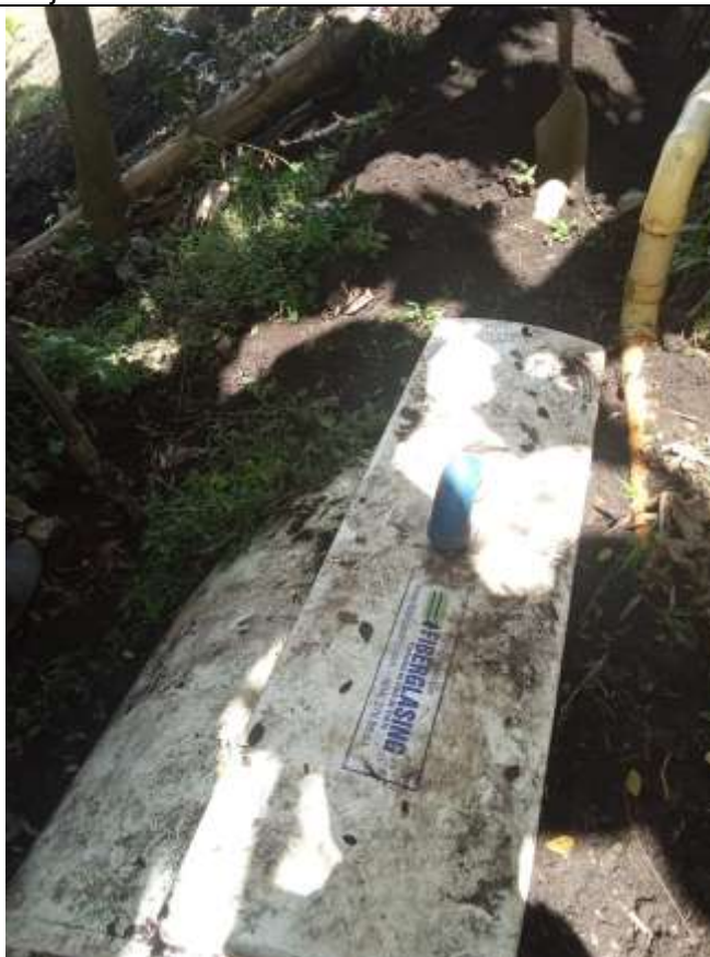
Foto 24: Seguimiento ejecución de actividades en obra
