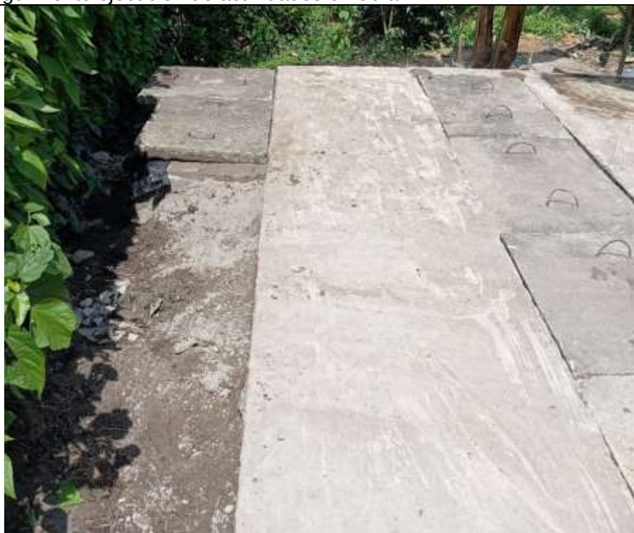
Foto 10: Seguimiento ejecución de actividades en obra
