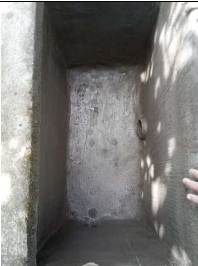
Foto 32: Seguimiento ejecución de actividades en obra
