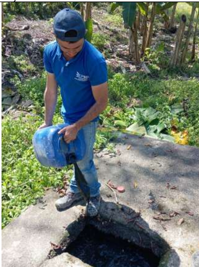
Foto 22: Seguimiento ejecución de actividades en obra
