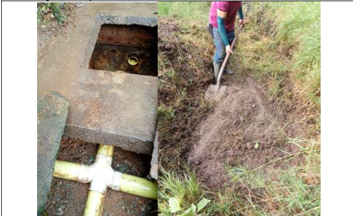
Foto 6: Seguimiento ejecución de actividades en obra
