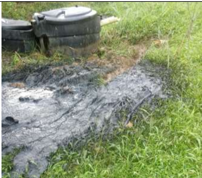
Foto 25: Seguimiento ejecución de actividades en obra
