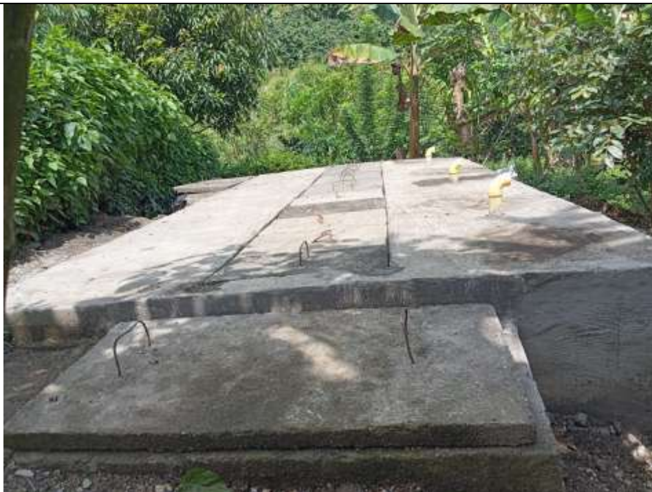
Foto 7: Seguimiento ejecución de actividades en obra
