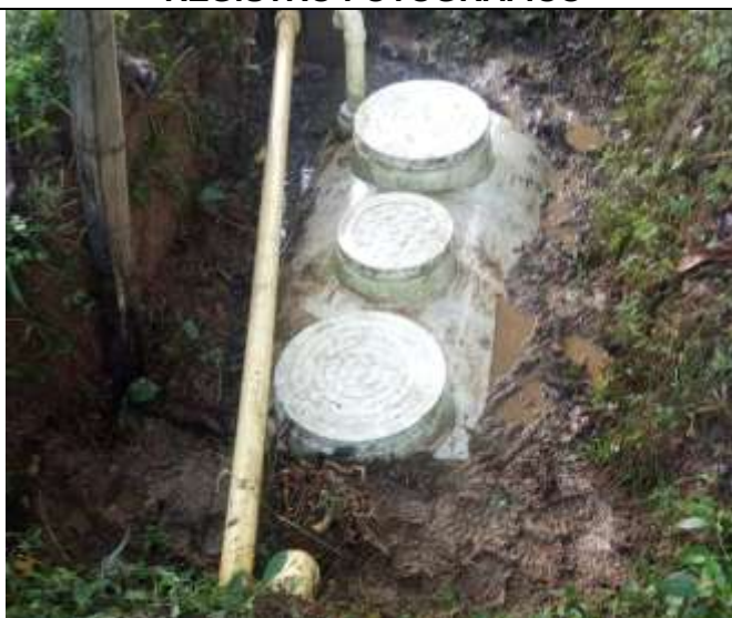
Foto 1: Seguimiento ejecución de actividades en obra
