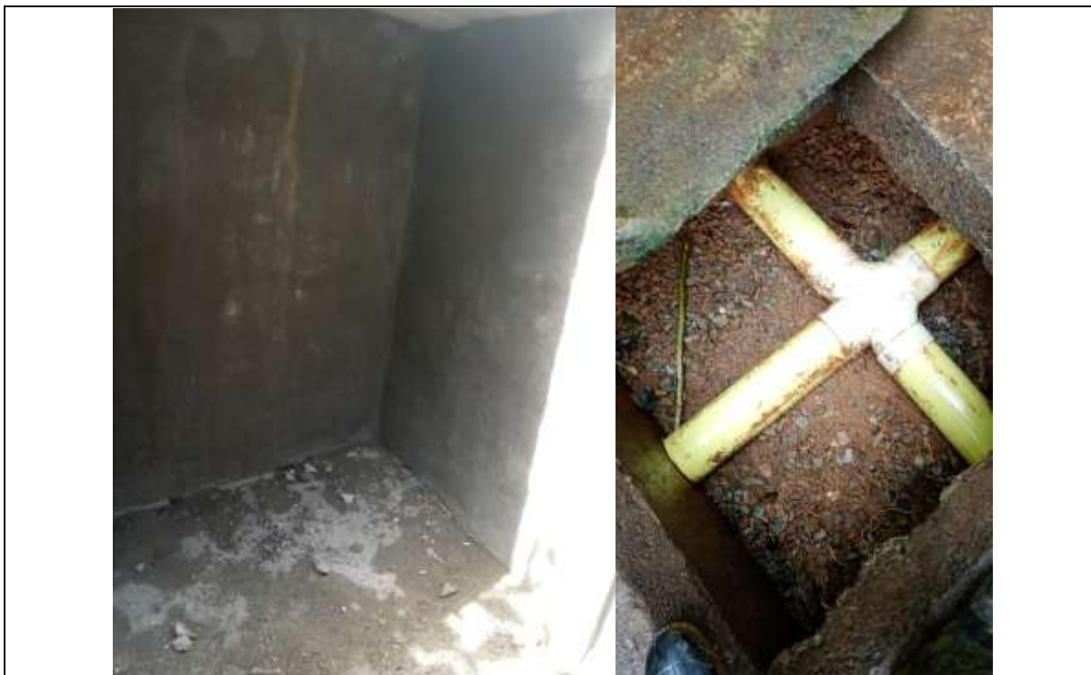
Foto 32: Seguimiento ejecución de actividades en obra
