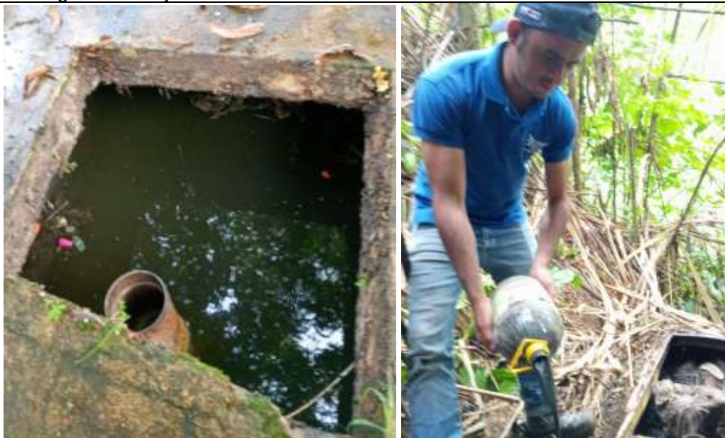
Foto 32: Seguimiento ejecución de actividades en obra
