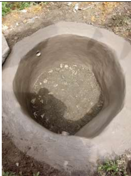
Foto 30: Seguimiento ejecución de actividades en obra
