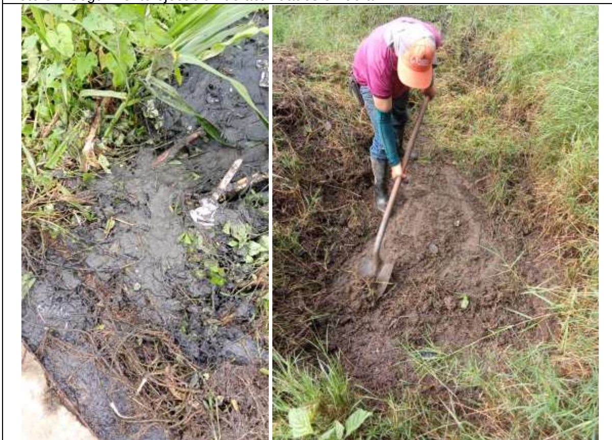
Foto 32: Seguimiento ejecución de actividades en obra
