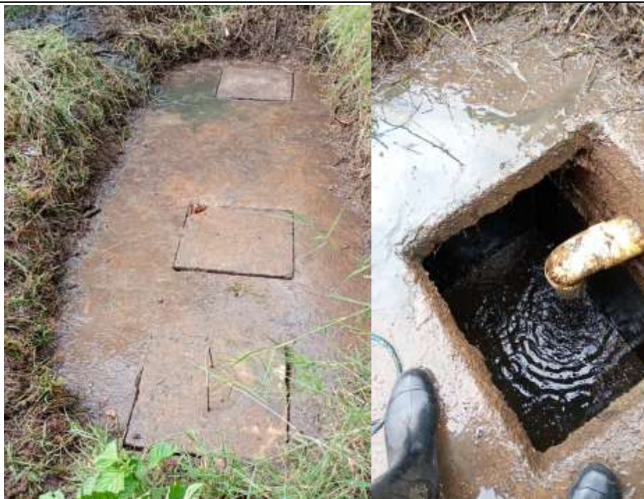
Foto 9: Seguimiento ejecución de actividades en obra
