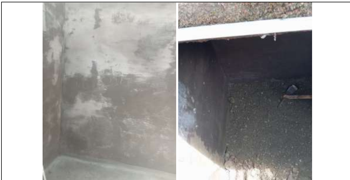
Foto 32: Seguimiento ejecución de actividades en obra
