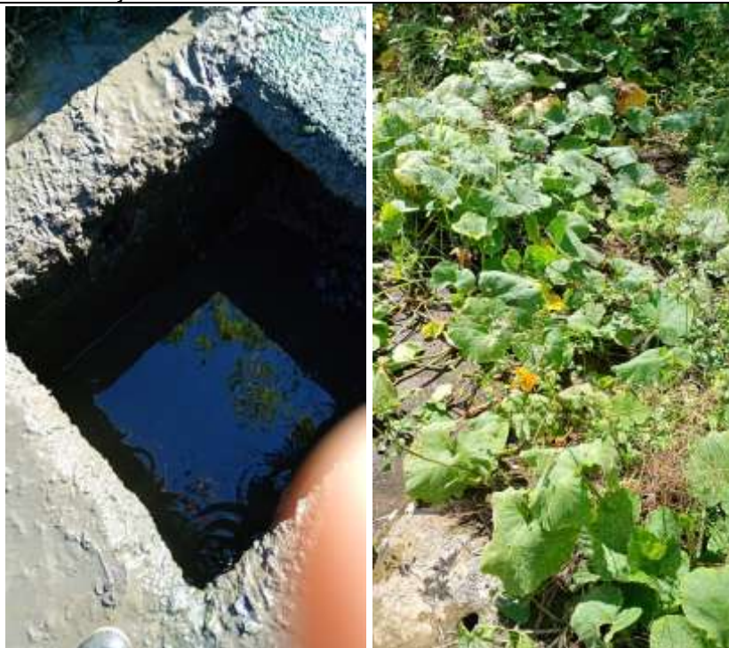
Foto 32: Seguimiento ejecución de actividades en obra
