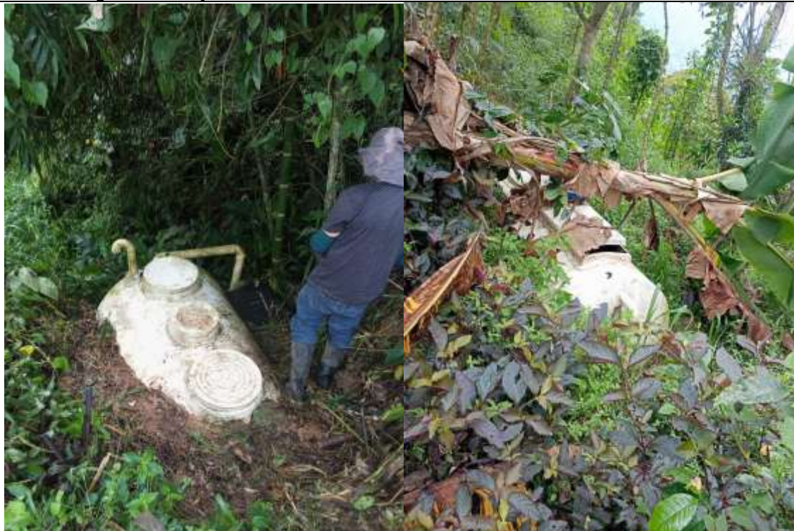
Foto 32: Seguimiento ejecución de actividades en obra
