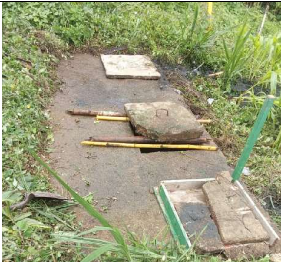
Foto 31: Seguimiento ejecución de actividades en obra
