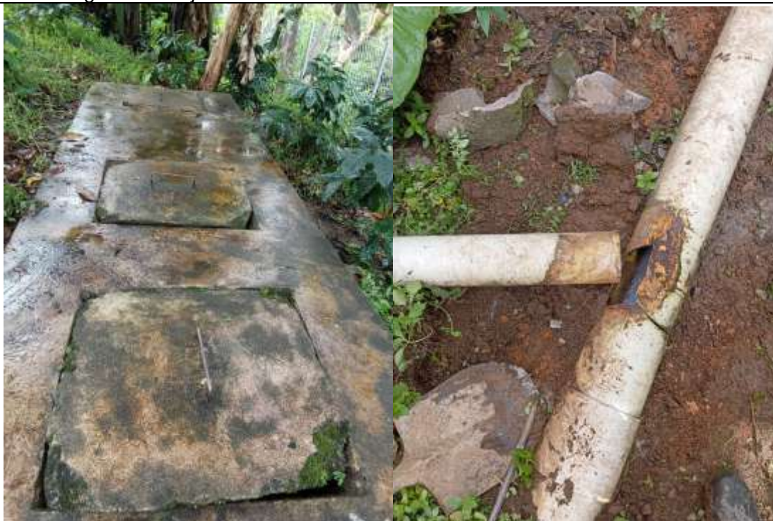
Foto 32: Seguimiento ejecución de actividades en obra
