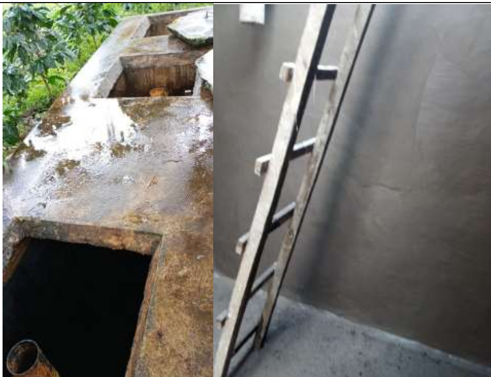
Foto 32: Seguimiento ejecución de actividades en obra
