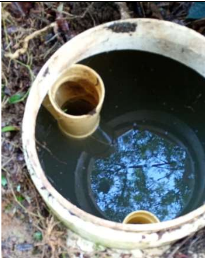
Foto 13: Seguimiento ejecución de actividades en obra
