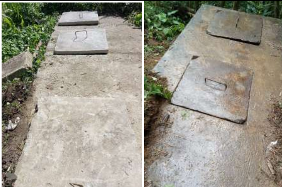
Foto 23: Seguimiento ejecución de actividades en obra
