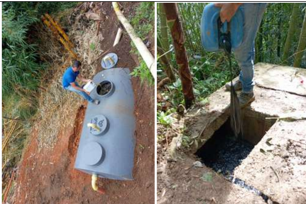
Foto 27: Seguimiento ejecución de actividades en obra
