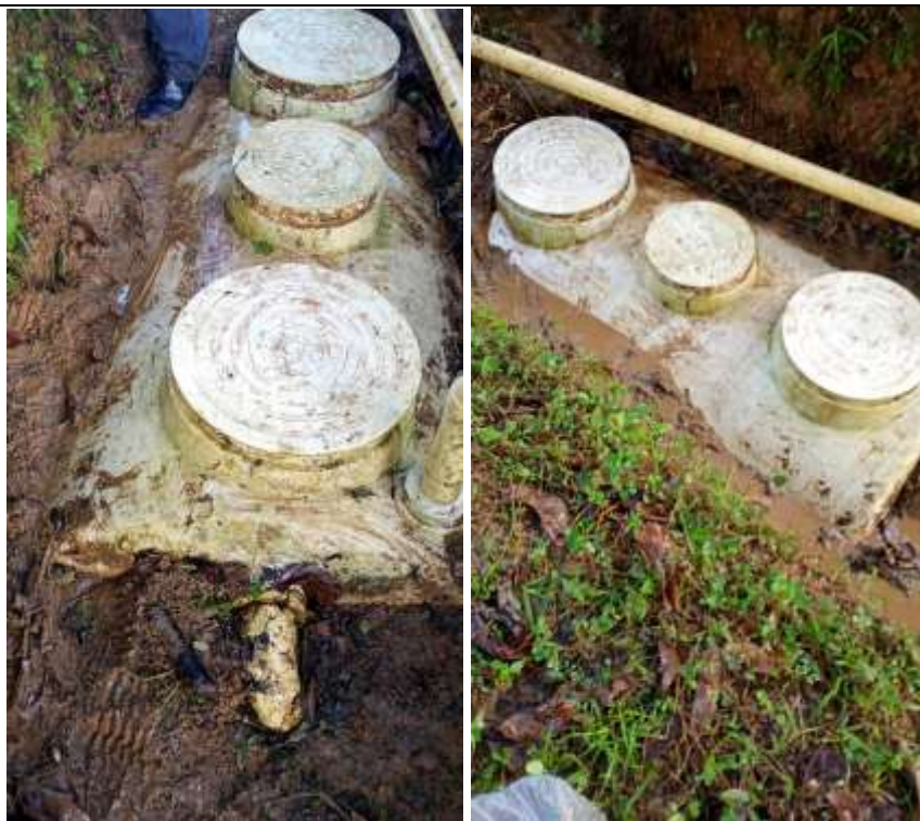
Foto 32: Seguimiento ejecución de actividades en obra
