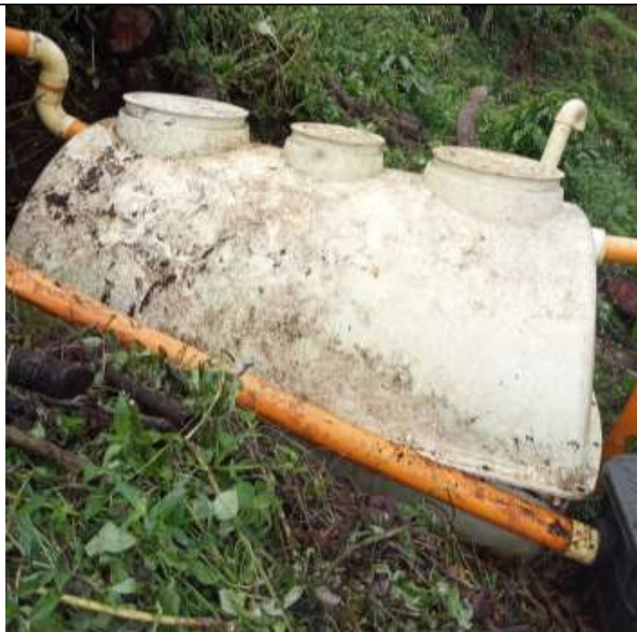
Foto 32: Seguimiento ejecución de actividades en obra
