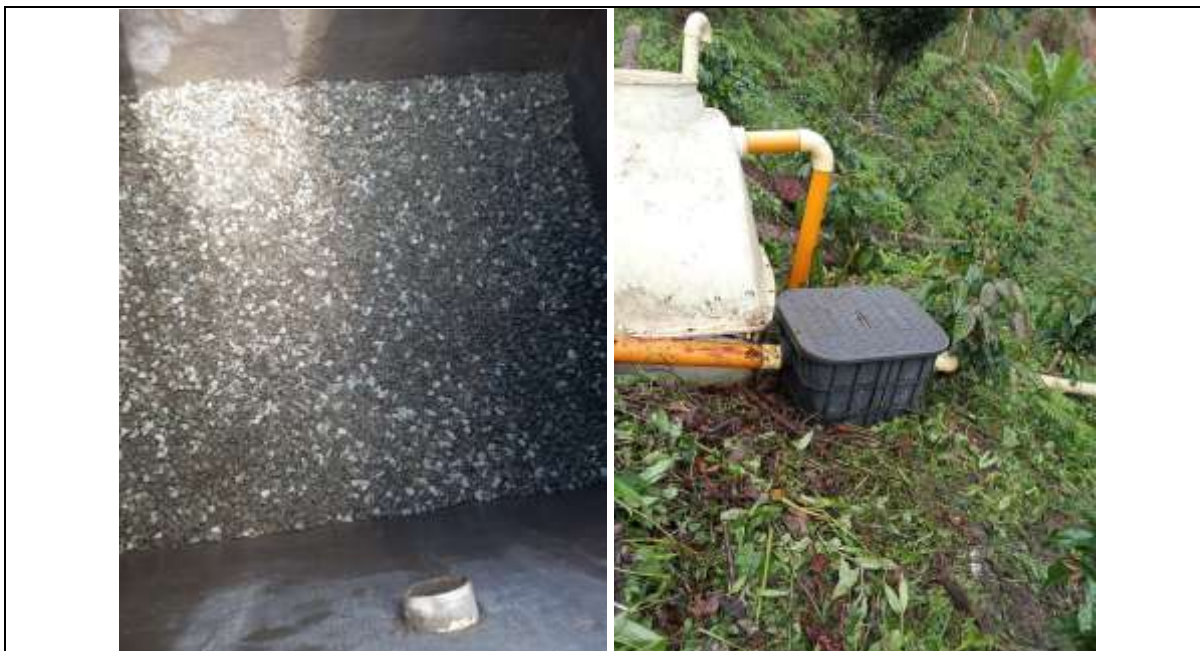
Foto 32: Seguimiento ejecución de actividades en obra
