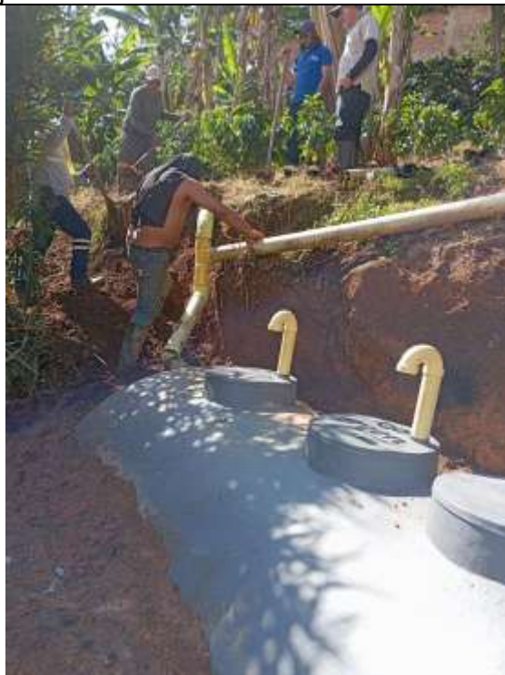
Foto 12: Seguimiento ejecución de actividades en obra
