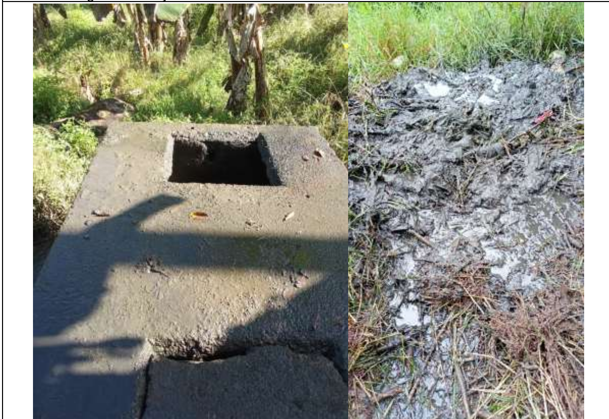
Foto 32: Seguimiento ejecución de actividades en obra
