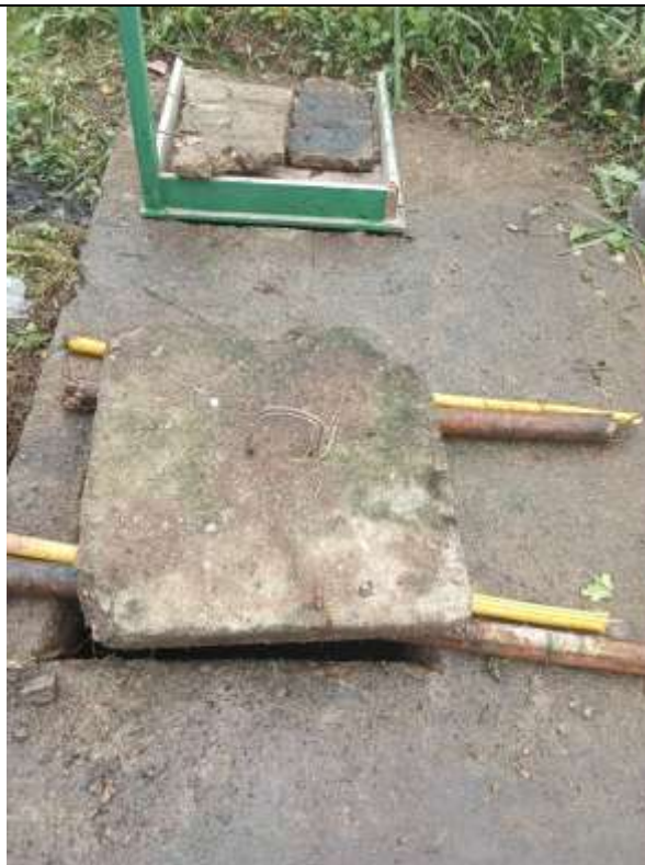
Foto 29: Seguimiento ejecución de actividades en obra
