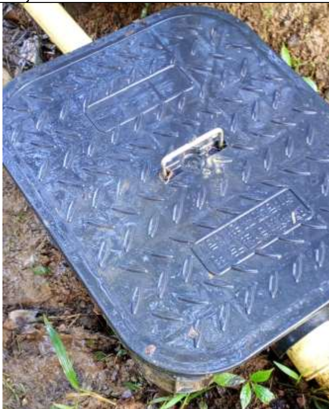
Foto 16: Seguimiento ejecución de actividades en obra
