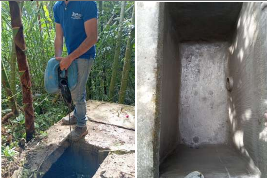
Foto 32: Seguimiento ejecución de actividades en obra
