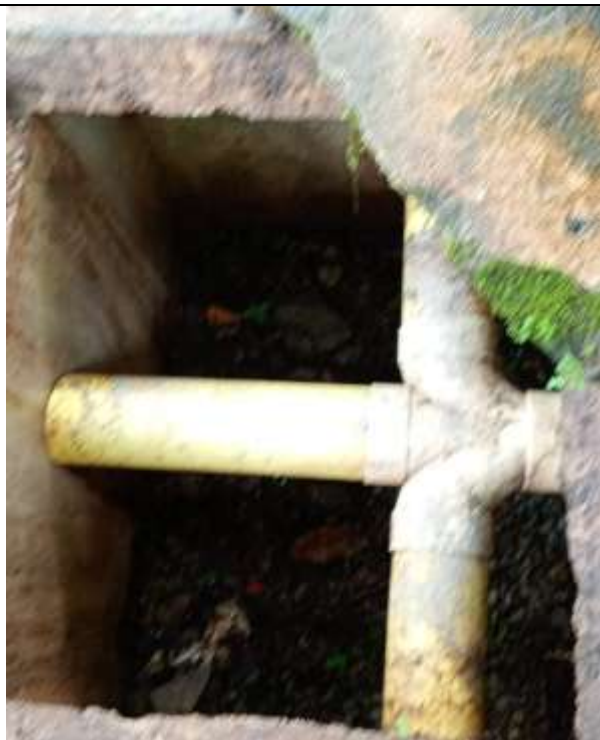
Foto 11: Seguimiento ejecución de actividades en obra
