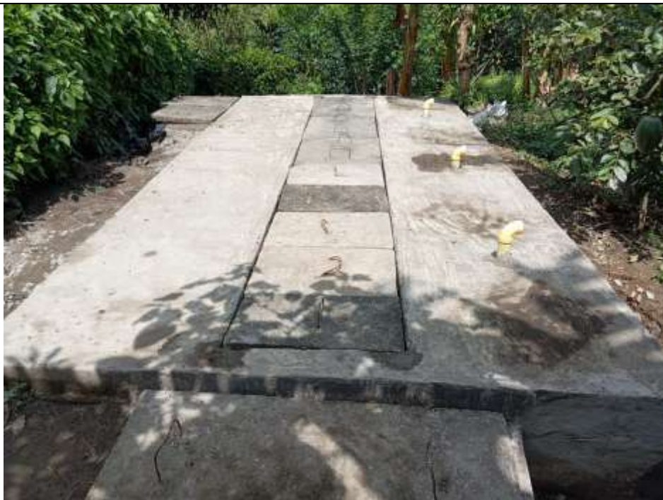
Foto 19: Seguimiento ejecución de actividades en obra
