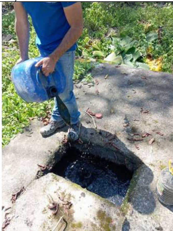
Foto 26: Seguimiento ejecución de actividades en obra
