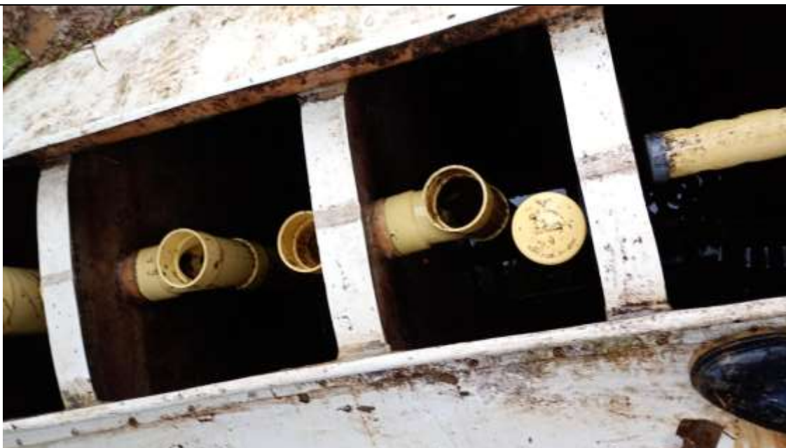
Foto 3: Seguimiento ejecución de actividades en obra
