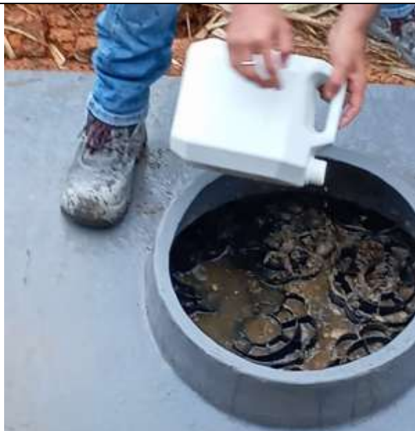
Foto 21: Seguimiento ejecución de actividades en obra
