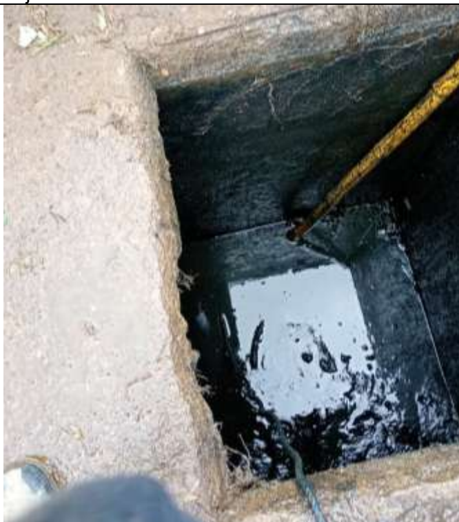
Foto 8: Seguimiento ejecución de actividades en obra
