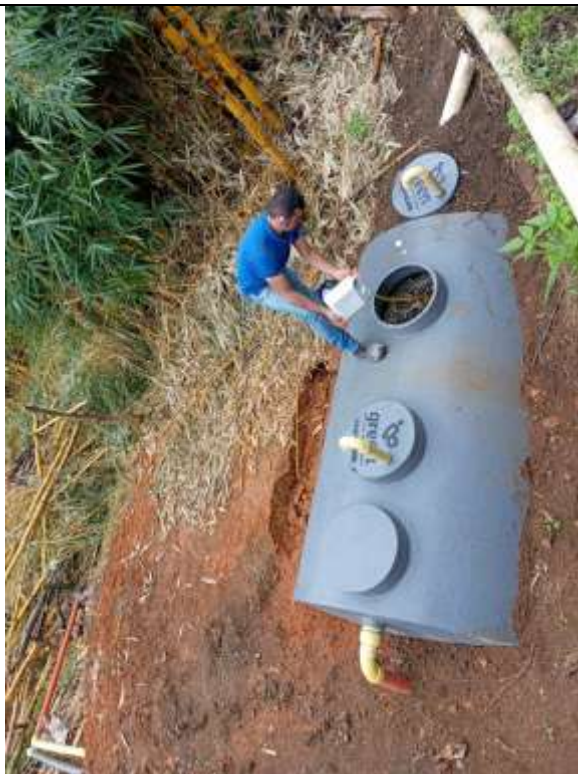
Foto 17: Seguimiento ejecución de actividades en obra
