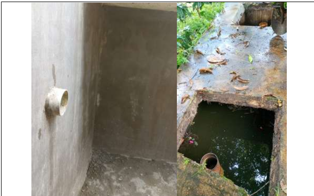
Foto 5: Seguimiento ejecución de actividades en obra
