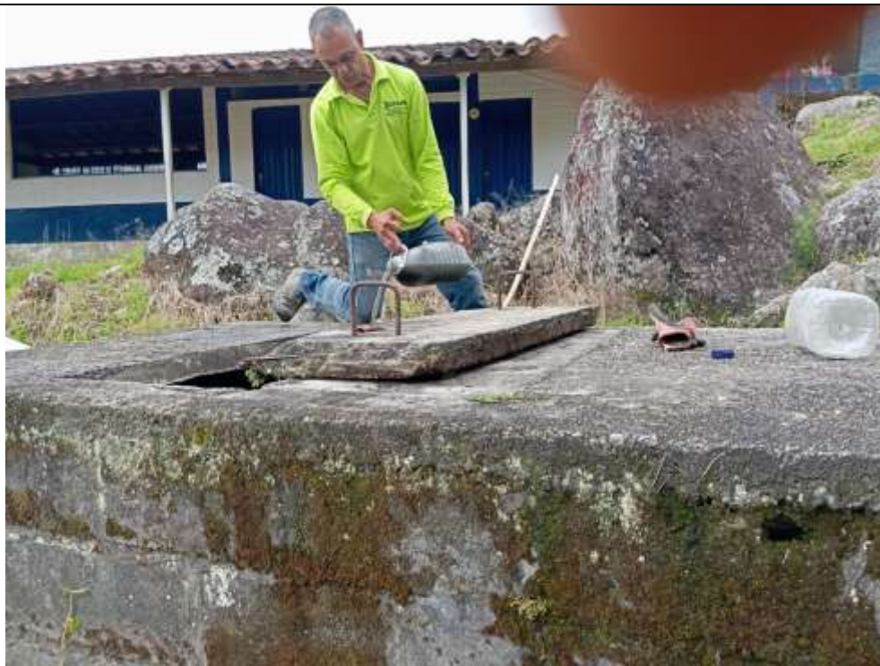
Foto 32: Seguimiento ejecución de actividades en obra
