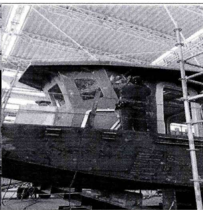
Foto 2.3. Corte y pulida a ventanas y puertas para instalación de marcos de ventanas del bote 01 "YAPEL".
