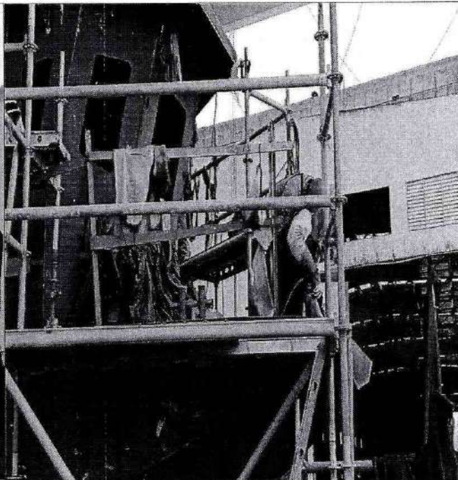
Foto 1.3. Soldadura general bote 02.
