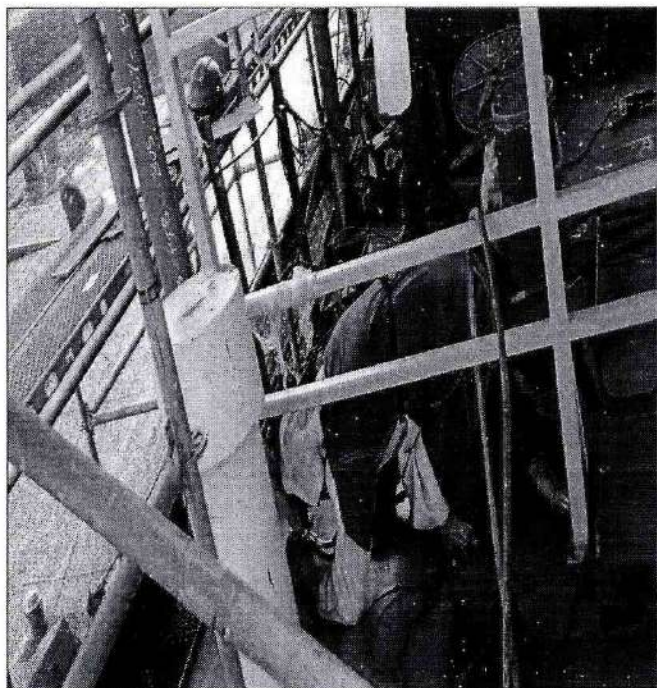
Foto 2.2. Instalación y soldadura de estructura de soporte bicicletas.
