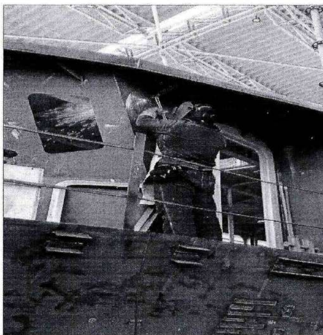
Foto 2.2. Corte y pulida a ventanas y puertas para instalación de marcos de ventanas del bote 01 "YAPEL".
