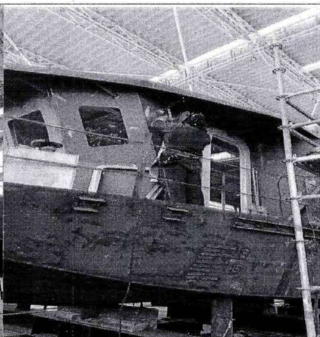
Foto 2.1. Corte y pulida a ventanas y puertas para instalación de marcos de ventanas del bote 01 "YAPEL".
