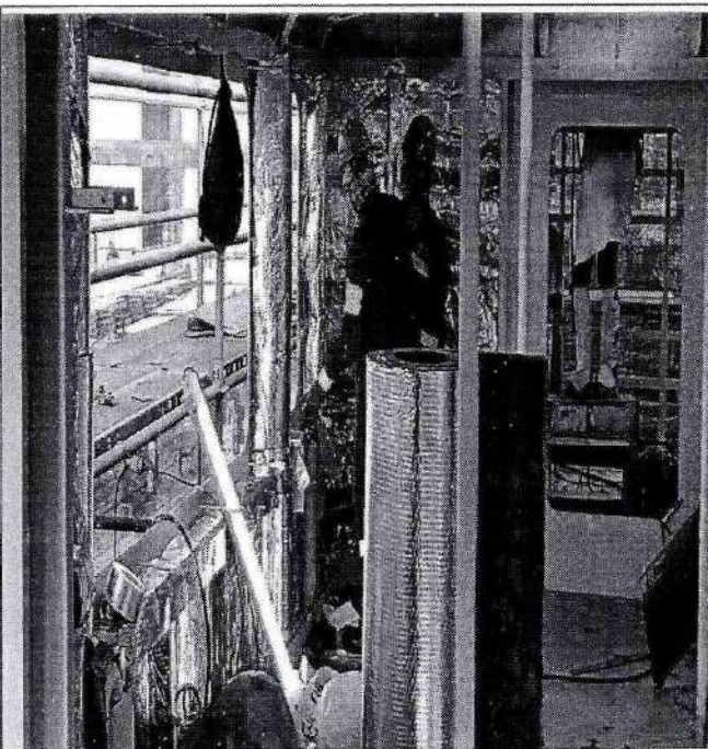
Foto 2.5. Recubrimiento de la cabina bote 01 "YAPEL".
