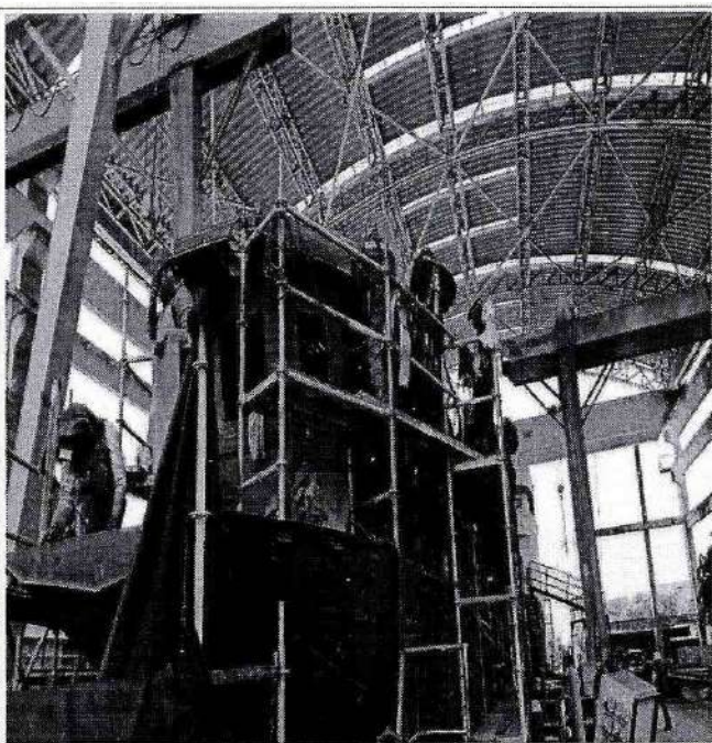
Foto 1.1. Soldadura general bote 02.
