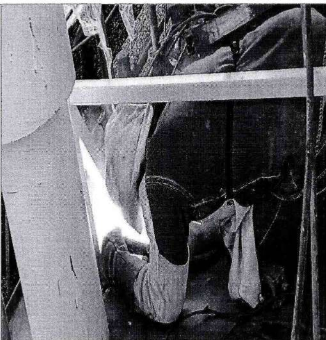
Foto 1.5. Instalación y soldadura de estructura de soporte bicicletas.
