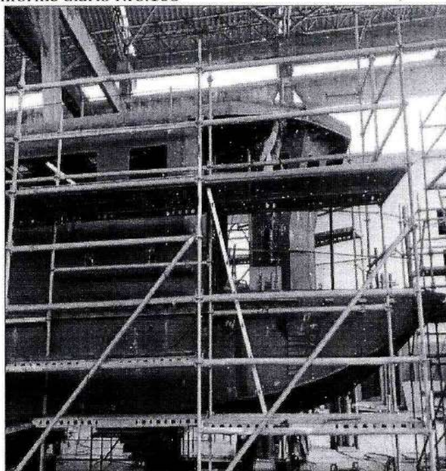
Foto 1.6. Soldadura general bote 02.
