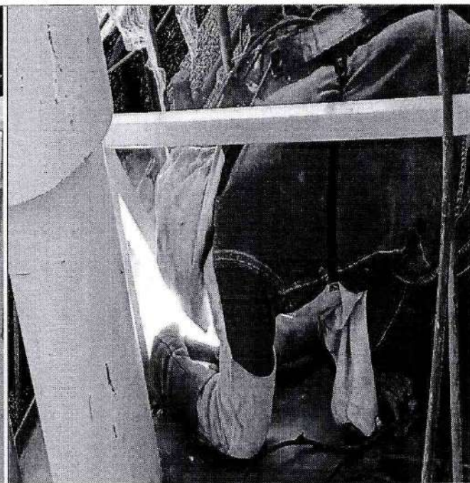
Foto 2.1. Instalación y soldadura de estructura de soporte bicicletas.
