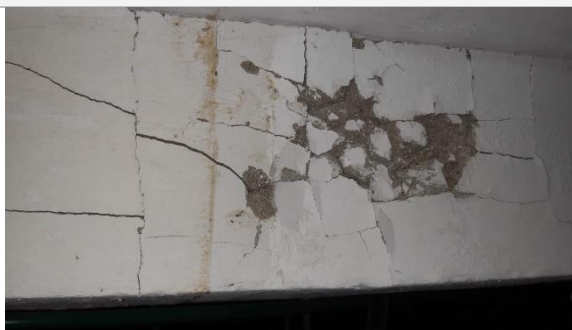
Foto 4. Falla por corrosión con fisura ubicada casi a la mitad del peralte de la viga, lo que implica un alto recubrimiento o la posible falta de flejes. Nótese que la fisura se transmite hasta la viga de apoyo
