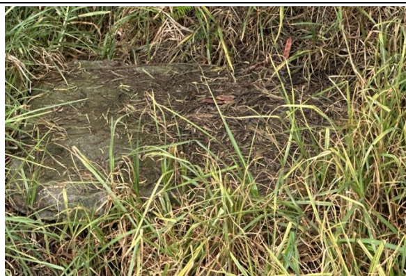
Ca-16 Caja de Piso
