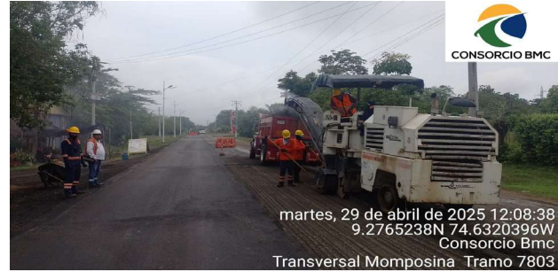
Imagen 2: Fresado de pavimento ruta 7803 margen Derecha PR06+123.2 - PR06+175.5
