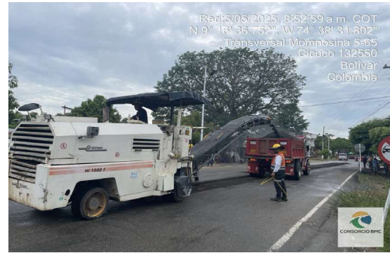
Imagen 4: Fresado de pavimento ruta 7803 margen Derecha PR05+037.5 - PR05+090.8
