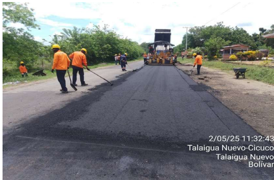
Imagen 3: Parqueo de pavimento ruta 7803 Margen Derecha PRO6+295.5 - PRO6+393.5
