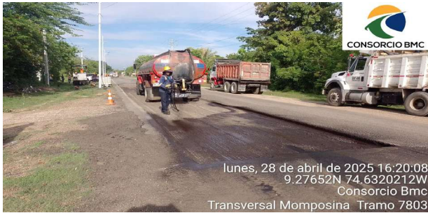
Imagen 1: Parqueo de pavimento ruta 7803 Margen Izquierda PR05+319.5 - PR05+438.5
