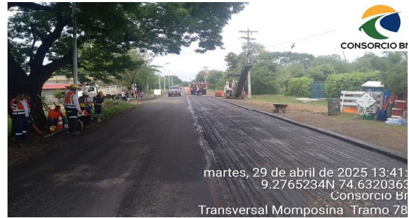
Imagen 2: Parqueo de pavimento ruta 7803 Margen Derecha PR06+123.2 - PR06+175.5
