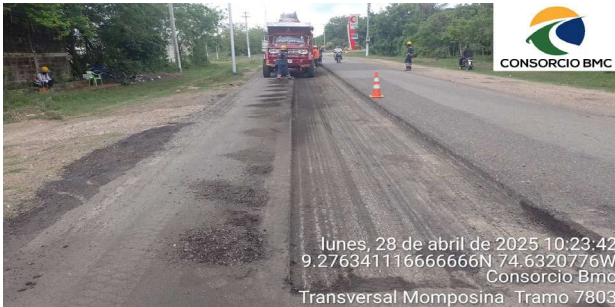
Imagen 1: Fresado de pavimento ruta 7803 margen Izquierda PR6+190 - PR06+224.7
