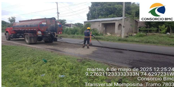
Imagen 5: Parqueo de pavimento Ruta 7803 margen Izquierda PR06+427.7 - PR06+478
