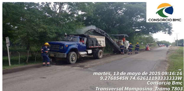
Imagen 6: Fresado de pavimento ruta 7803 margen Izquierda PR06+857 - PR06+942.8
