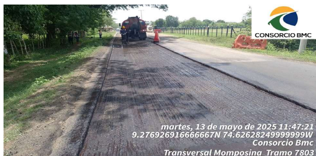
Imagen 6: Parqueo de pavimento Ruta 7803 margen Izquierda PR06+857 - PR06+942.8
