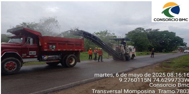
Imagen 5: Fresado de pavimento ruta 7803 margen Izquierda PR06+427.5 - PR06+478
