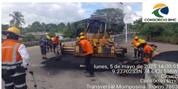
Imagen 4: Parqueo de pavimento Ruta 7803 margen Derecha PRO5+090.8 - PRO5+131
