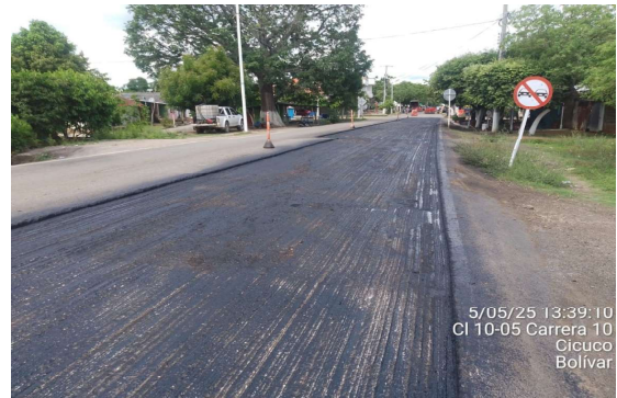
Imagen 4: Parqueo de pavimento Ruta 7803 margen Derecha PR05+090.8 - PR05+131
