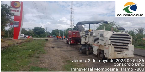
Imagen 3: Fresado de pavimento ruta 7803 margen Derecha PR06+295.5 - PR06+393.5
