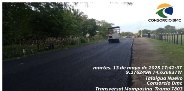
Imagen 6: Parqueo de pavimento Ruta 7803 margen Derecha PRO6+863 - PRO6+942.8
