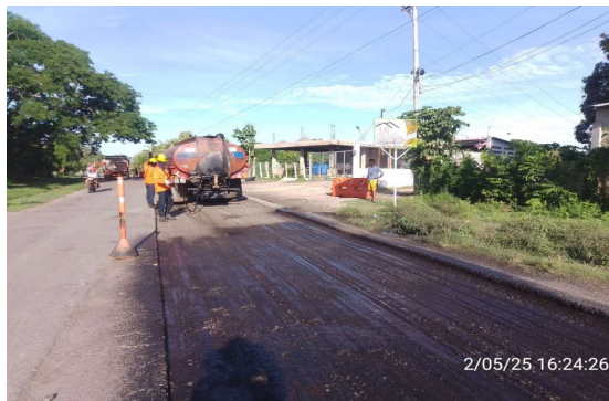
Imagen 3: Parqueo de pavimento ruta 7803 Margen Derecha PR06+295.5 - PR06+393.5
