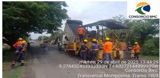
Imagen 2: Parqueo de pavimento ruta 7803 Margen Derecha PRO6+123.2 - PRO6+175.5
