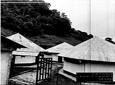
Imagen No1: Evidencia fotográfica Fachada de la institución Siuyaskuba sede escuela rural Kamara
