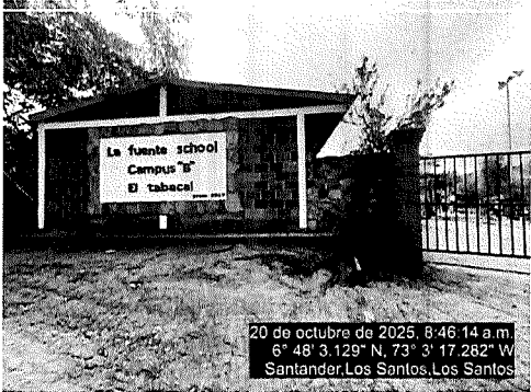
Imagen No1: EVIDENCIA FOTOGRAFICA: FACHADA - ESCUELA RURAL EL TABACAL.
