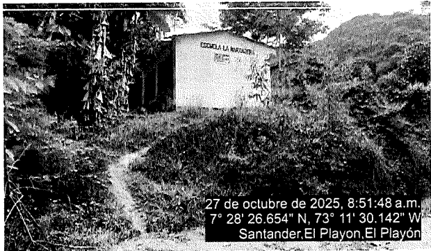
Imagen No2: EVIDENCIA FOTOGRAFICA: FACHADA - ESCUELA RURAL LA NARANJERA.
