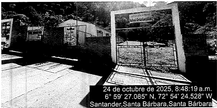
Imagen No3: EVIDENCIA FOTOGRAFICA: FACHADA - INSTITUTO TECNICO AGRICOLA RAFAEL ORTIZ GONZALEZ.
