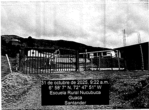
Imagen No1: Fachada Sede Educativa
