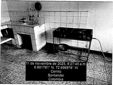
Imagen No3: Evidencia fotográfica área de preparación, Escuela Normal Superior Sady Tobón Calle - Escuela Rural Corral Falso - Cerrito
