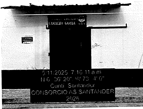
Imagen No1: Evidencia fotográfica Fachada Colegio Integrado Eduardo Camacho Gamba – Escuela Urbana Ismael Enrique Arciniegas.
