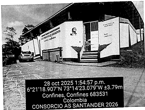
Imagen No1: Evidencia Fotográfica Fachada, Colegio Técnico Luis Carlos Gálán Sarmiento, municipio Confines
