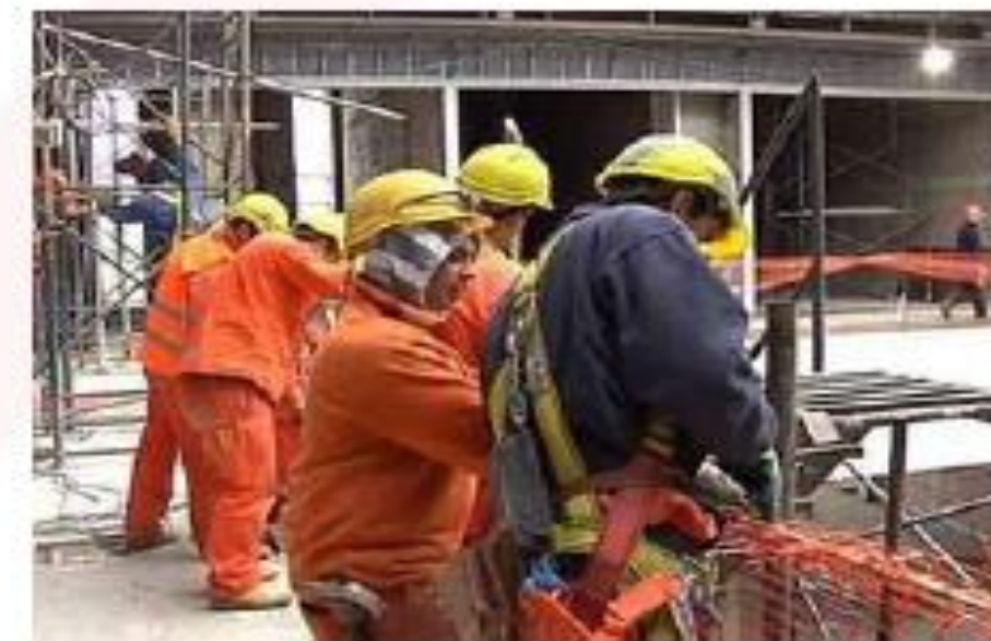
Transformadores – artesanos - obreros - etc
