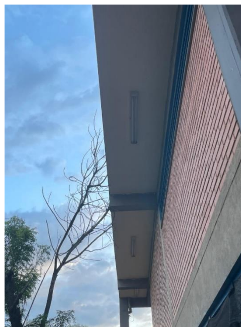
Estado inicial pasillo lateral izquierdo.
