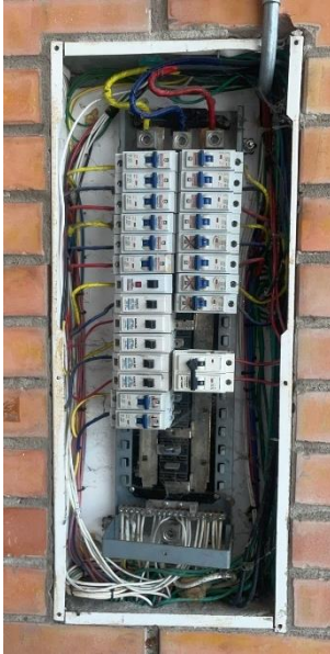
Estado inicial cubierta tablero #6
