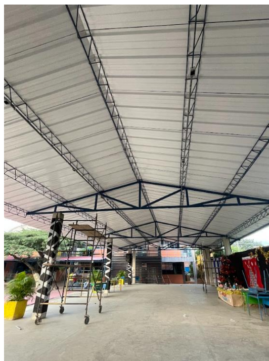
Iluminación instalada en auditorio.
