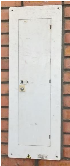
Estado inicial cubierta tablero #10
