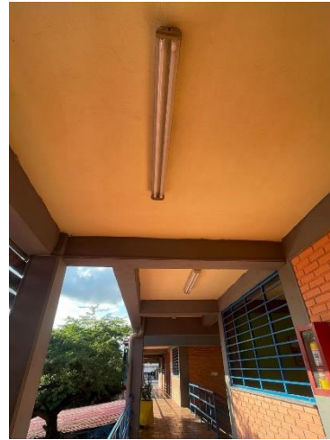
Estado inicial pasillo segundo piso.
