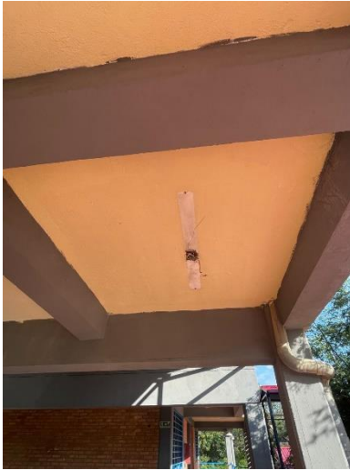
Estado inicial pasillo segundo piso.
