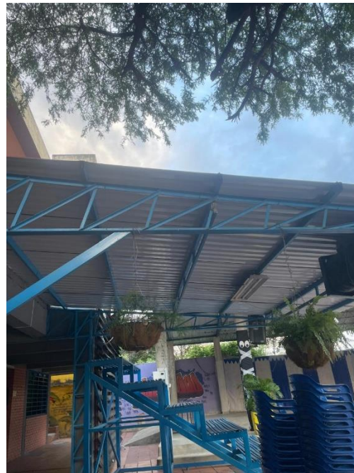
Estado inicial zona cubierta patio central.
