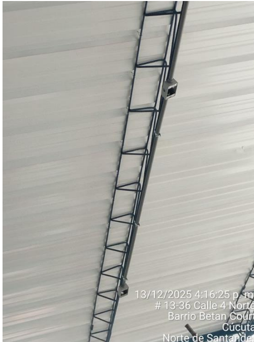
Detalle de la tubería instalada.
