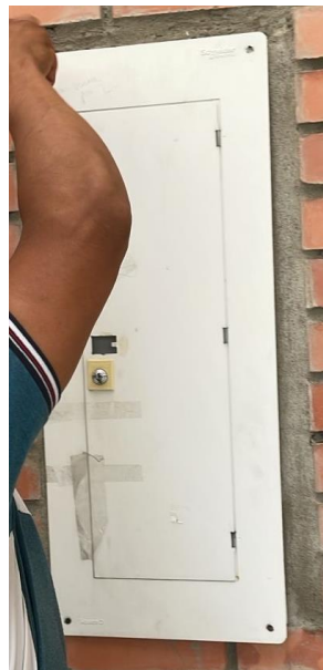
Estado inicial cubierta tablero #7
