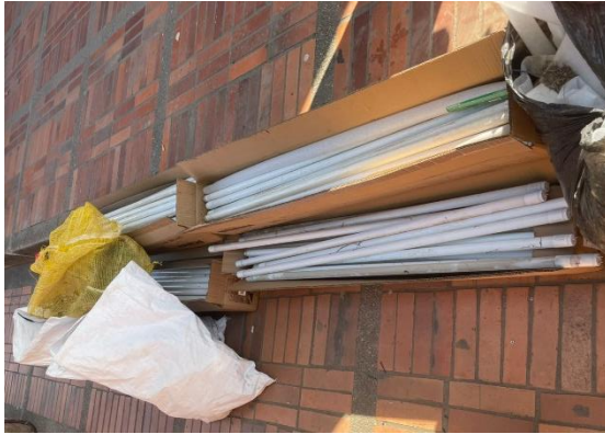
Evidencia de materiales desmontados.
