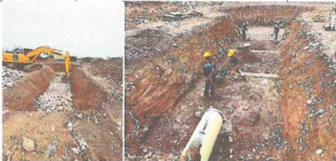
Rellenos en material granular estercolero
