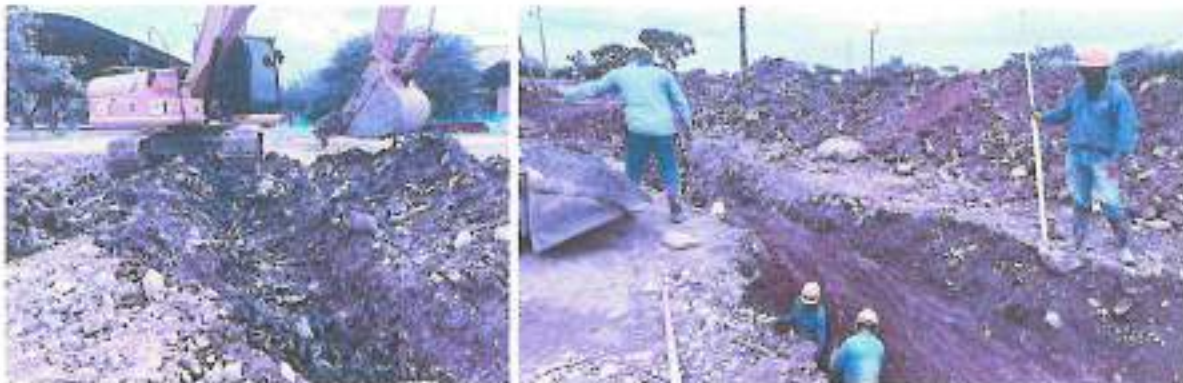
Estratos de basura en excavación de alcantarillado sanitario
