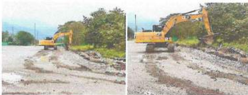
Demolición cimientos enterrados
