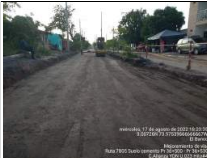
HITO 4 – RUTA 7805 PAVIMENTO RÍGIDO EL BANCO, Relleno y compactación con Suelo cemento
