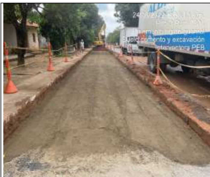
HITO 3 – RUTA 7804 PAVIMENTO RÍGIDO DE GUAMAL – Relleno y compactación con Suelo cemento
