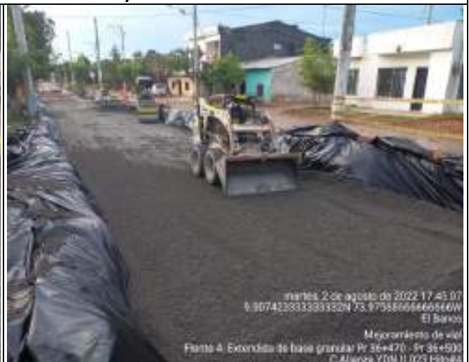
HITO 4 – RUTA 7805 PAVIMENTO RÍGIDO EL BANCO Estabilización con material Granular (Afirmado)
