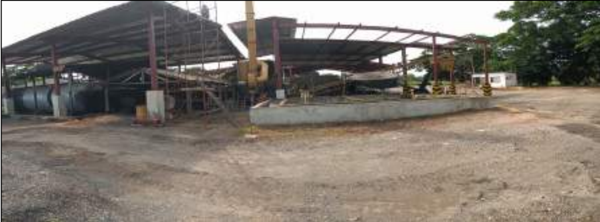
Imagen No 5: Planta de asfalto Mayorías. Consorcio Dumar Sofan
