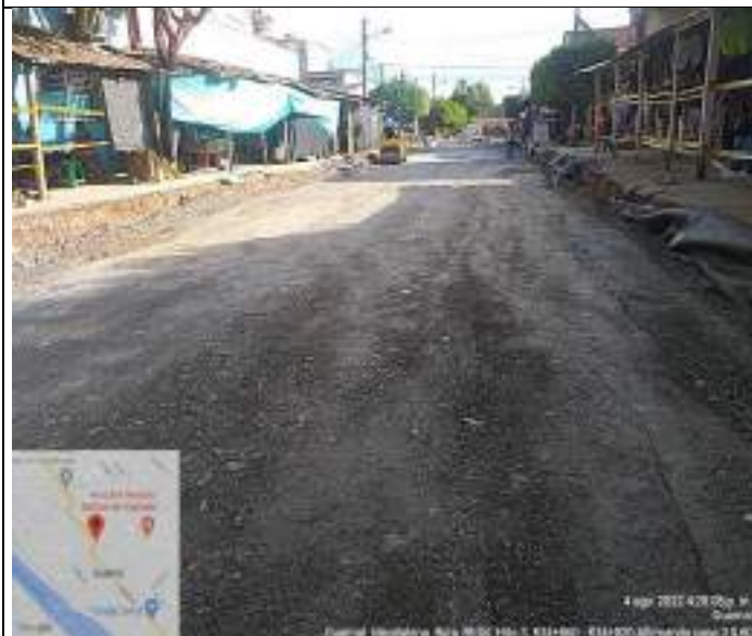
HITO 3 - RUTA 7804, PAVIMENTO RÍGIDO GUAMAL – ESTABILIZACION CON MATERIAL GRANULAR (AFIRMADO)
