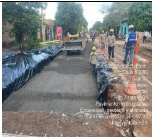
HITO 3 - RUTA 7804, PAVIMENTO RÍGIDO GUAMAL – ESTABILIZACION CON MATERIAL GRANULAR (AFIRMADO)
