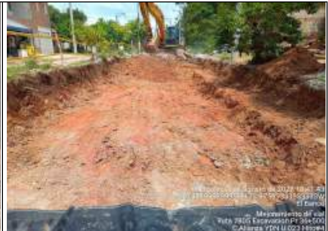
HITO 4 – RUTA 7805 PAVIMENTO RÍGIDO EL BANCO – Demolición, retiro y explanación
