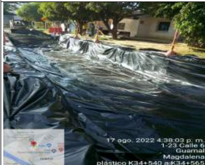
HITO 3 – RUTA 7804 PAVIMENTO RÍGIDO GUAMAL – COLOCACIÓN DE POLIETILENO Y GEOTEXTIL
