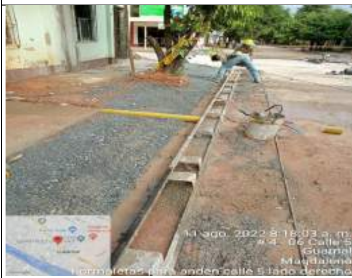
HITO 3 – RUTA 7804 PAVIMENTO RÍGIDO DE GUAMAL– FUNDIDA DE BORDILLOS Y ANDENES
