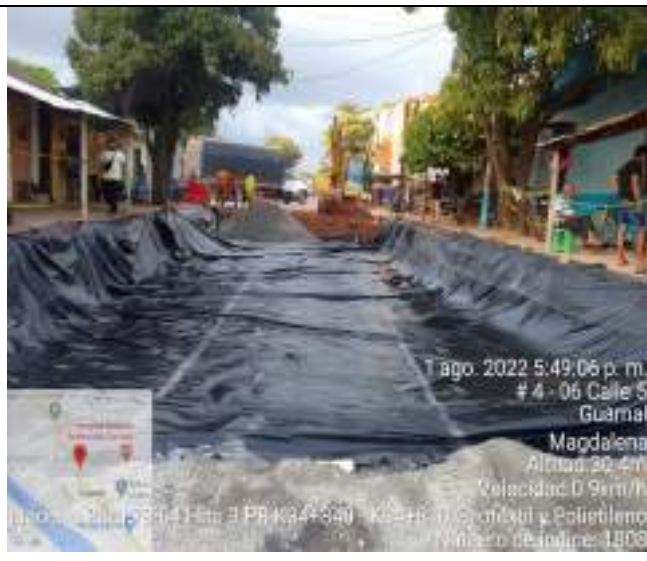
HITO 3 – RUTA 7804 PAVIMENTO RÍGIDO GUAMAL – COLOCACIÓN DE POLIETILENO Y GEOTEXTIL
