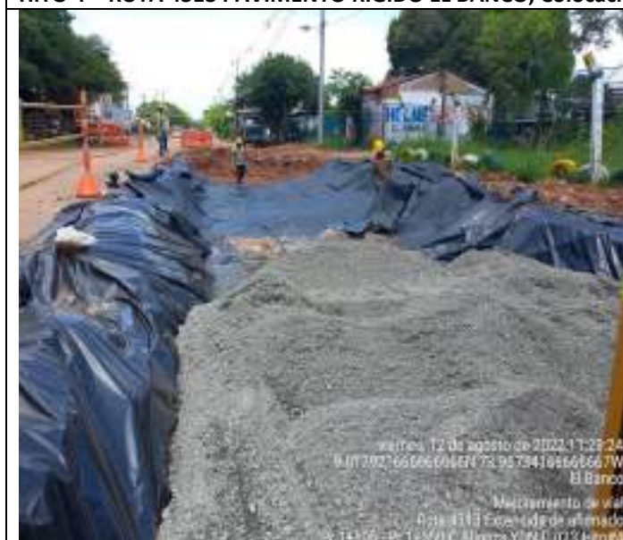
HITO 4 – RUTA 4313 PAVIMENTO RÍGIDO EL BANCO Estabilización con material granular (Afirmado)
