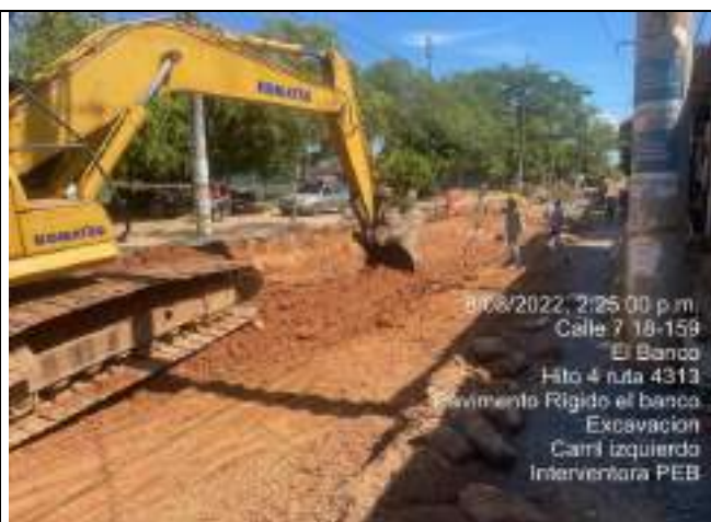
HITO 4 – RUTA 4313 PAVIMENTO RÍGIDO EL BANCO – Demolición, retiro y explanación
