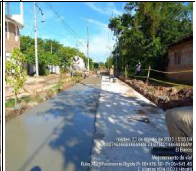
HITO 4 – RUTA 7805 PAVIMENTO RÍGIDO EL BANCO, Fundida de placa en concreto
