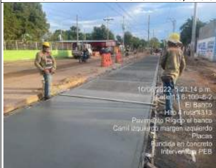
HITO 4 – RUTA 4313 PAVIMENTO RÍGIDO EL BANCO, Fundida de placas en concreto
