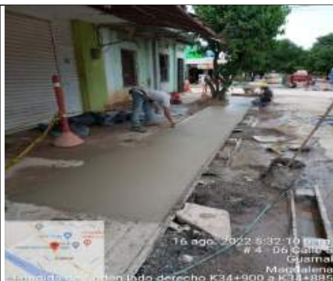
HITO 3 – RUTA 7804 PAVIMENTO RÍGIDO DE GUAMAL– FUNDIDA DE BORDILLOS Y ANDENES
