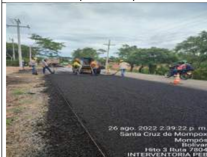
HITO 3 – RUTA 7804, EXTENDIDO Y COMPACTACION DE MEZCLA DENSA EN CALIENTE MDC -19
