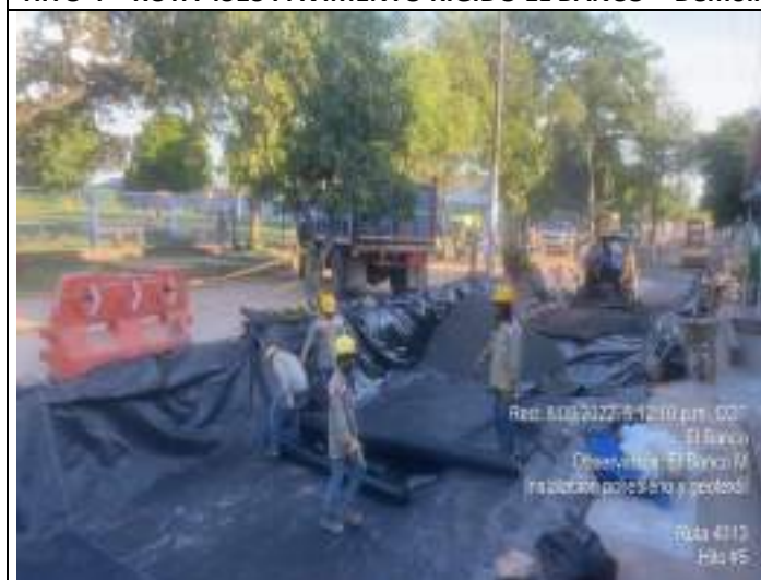
HITO 4 – RUTA 4313 PAVIMENTO RÍGIDO EL BANCO, Colocación de Geotextil Y Polietileno
