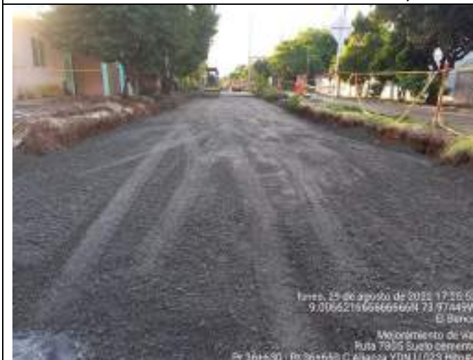
HITO 4 – RUTA 7805 PAVIMENTO RÍGIDO EL BANCO Estabilización con material Granular (Afirmado)
