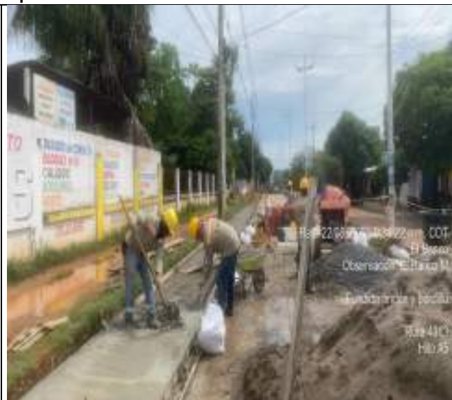
HITO 4 – RUTA 4313 PAVIMENTO RÍGIDO EL BANCO, Fundida de bordillo y andenes
