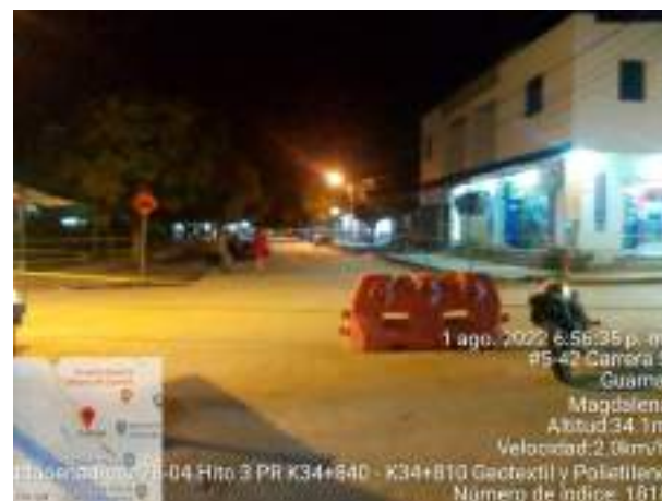
Fotografía Señalización en obra
