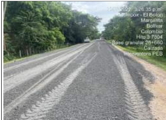
HITO 3 – RUTA 7804 Estabilización con Base granular
