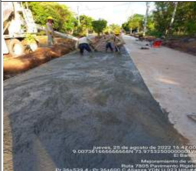
HITO 4 – RUTA 7805 PAVIMENTO RÍGIDO EL BANCO, Fundida de placa en concreto
