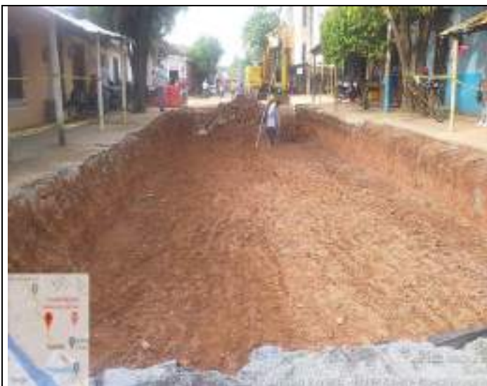
HITO 3 – RUTA 7804, PAVIMENTO RÍGIDO GUAMAL – DEMOLICION, RETIRO Y EXCAVACIÓN DE MATERIAL EXISTENTE
