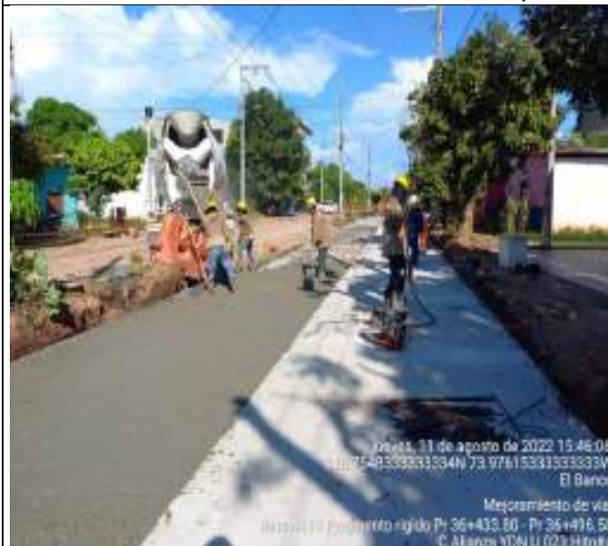
HITO 4 – RUTA 7805 PAVIMENTO RÍGIDO EL BANCO, Fundida en concreto Rígido
