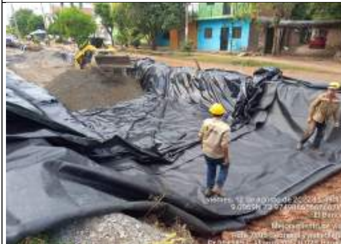
HITO 4 – RUTA 7805 PAVIMENTO RÍGIDO EL BANCO, Colocación de Geotextil y Polietileno
