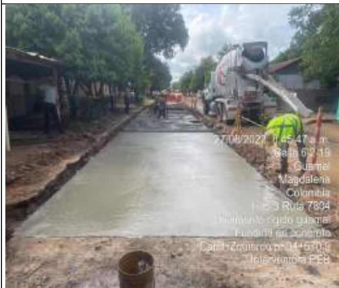
HITO 3 – RUTA 7804 PAVIMENTO RÍGIDO DE GUAMAL– FUNDIDA EN CONCRETO PLACAS
