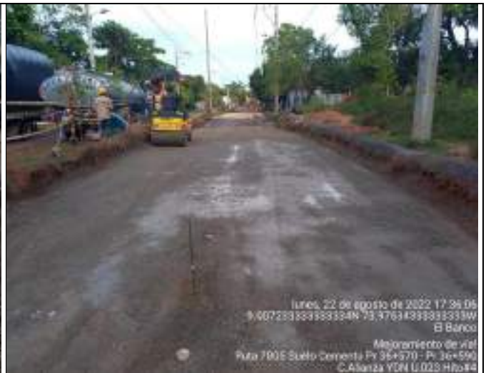
HITO 4 – RUTA 7805 PAVIMENTO RÍGIDO EL BANCO, Relleno y compactación con Suelo cemento
