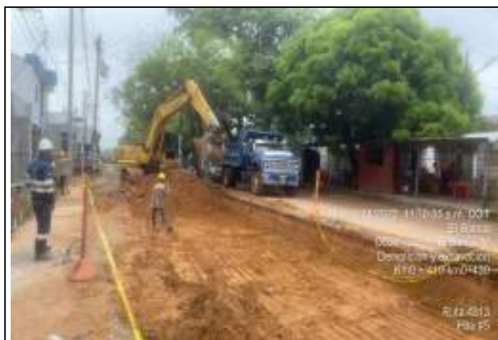
HITO 4 – RUTA 4313 PAVIMENTO RÍGIDO EL BANCO – Demolición, retiro y explanación
