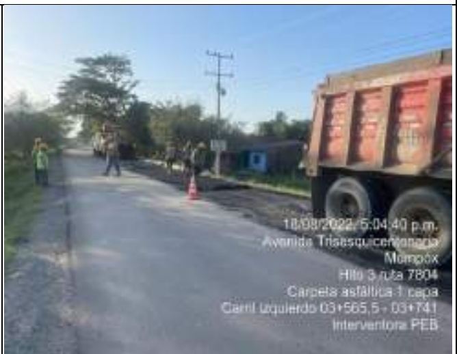
HITO 3 – RUTA 7804, EXTENDIDO Y COMPACTACION DE MEZCLA DENSA EN CALIENTE MDC -19
