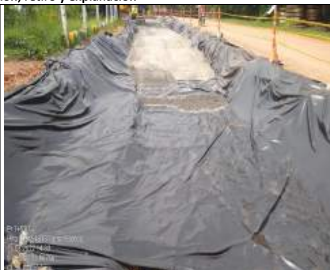
HITO 4 – RUTA 4313 PAVIMENTO RÍGIDO EL BANCO, Colocación de Geotextil Y Polietileno
