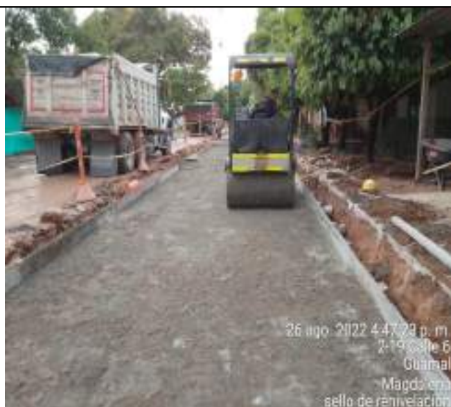
HITO 3 – RUTA 7804 PAVIMENTO RÍGIDO DE GUAMAL – Relleno y compactación con Suelo cemento
