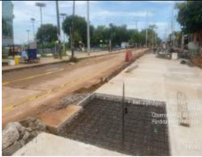
HITO 4 – RUTA 4313 PAVIMENTO RÍGIDO EL BANCO, Losas irregulares con parrillas en acero dobles
