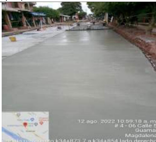
HITO 3 – RUTA 7804 PAVIMENTO RÍGIDO DE GUAMAL– FUNDIDA EN CONCRETO PLACAS
