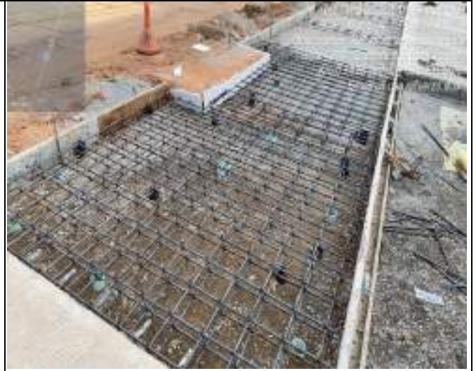
HITO 4 – RUTA 4313 PAVIMENTO RÍGIDO EL BANCO, Losas irregulares con parrillas en acero dobles
