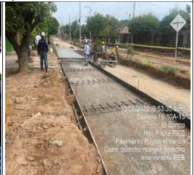
HITO 4 – RUTA 7805 PAVIMENTO RÍGIDO EL BANCO, Fundida en concreto Rígido
