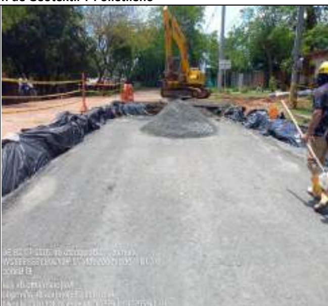
HITO 4 – RUTA 4313 PAVIMENTO RÍGIDO EL BANCO Estabilización con material granular (Afirmado)
