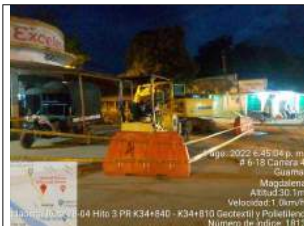
Fotografía Señalización Frente de obra
