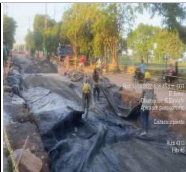
HITO 4 – RUTA 4313 PAVIMENTO RÍGIDO EL BANCO, Relleno y Compactación con Suelo cemento
