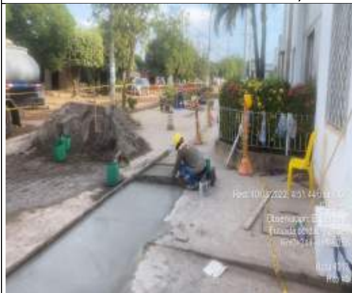
HITO 4 – RUTA 4313 PAVIMENTO RÍGIDO EL BANCO, Fundida de bordillo y andenes
