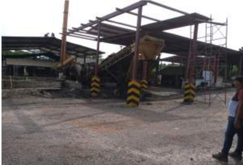
Imagen No 3: Planta de Asfalto
