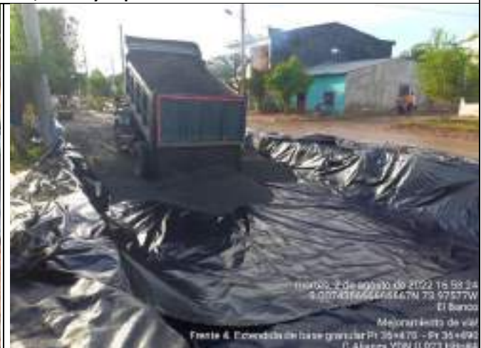
HITO 4 – RUTA 7805 PAVIMENTO RÍGIDO EL BANCO, Colocación de Geotextil y Polietileno
