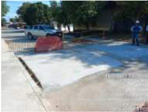
HITO 3 – RUTA 7804 INSTALACIÓN DE RESALTO EN CONCRETO TIPO INVIAS SECTOR GUAMAL
