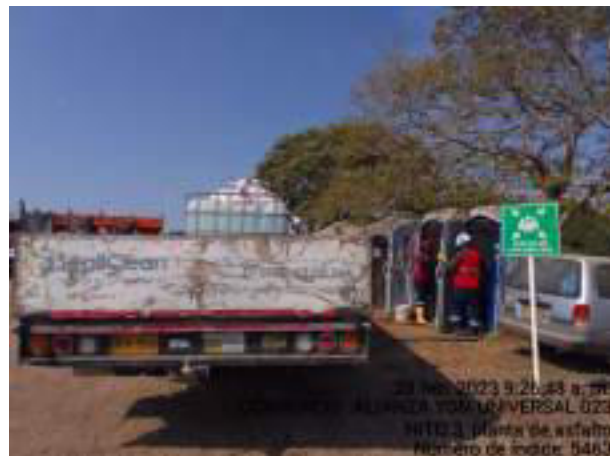
Fotografía Limpieza de baños portátiles
