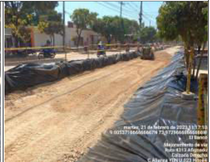
HITO 4 – RUTA 4313 PAVIMENTO RÍGIDO EL BANCO Estabilización con material granular (Afianzado)
