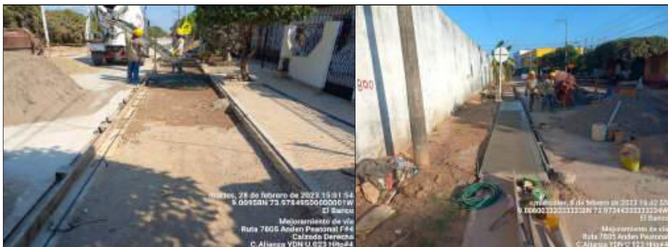
HITO 4 – RUTA 7805 PAVIMENTO RÍGIDO EL BANCO, Fundida de andenes peatonales
