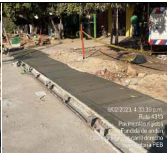
HITO 4 – RUTA 4313 PAVIMENTO RÍGIDO EL BANCO, Fundida de Andenes peatonales.
