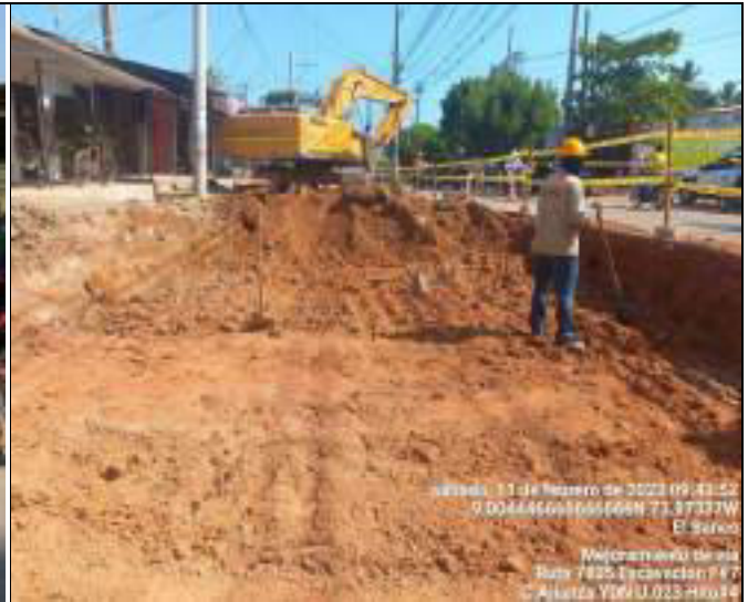
HITO 4 – RUTA 4313 PAVIMENTO RÍGIDO EL BANCO – Demolición, retiro y explanación
