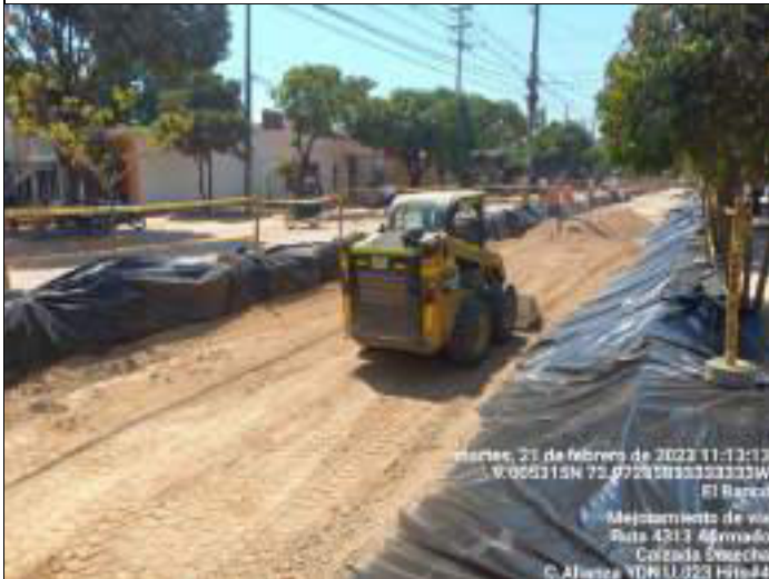
HITO 4 – RUTA 4313 PAVIMENTO RÍGIDO EL BANCO Estabilización con material granular (Afianzado)
