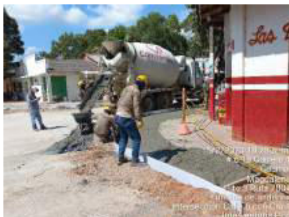
HITO 3 – RUTA 7804 PAVIMENTO RÍGIDO DE GUAMAL – FUNDIDA ANDENES INTERSECCIÓN CALLE 6 CON CRA 4
