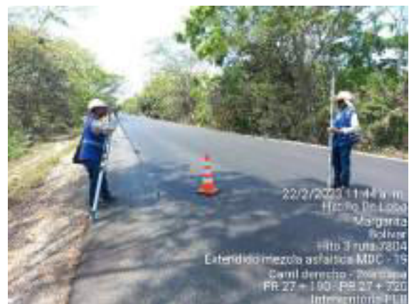
HITO 3 – RUTA 7804 EXTENDIDO DE MEZCLA ASFÁLTICA MDC – 19 SECTOR MARGARITA (2da CAPA)
