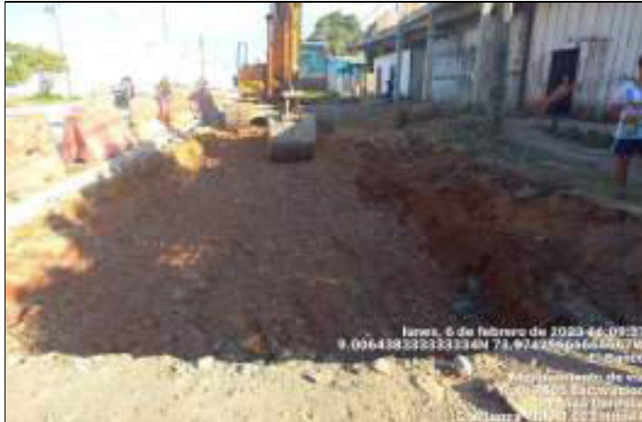
HITO 4 – RUTA 7805 PAVIMENTO RÍGIDO EL BANCO – Explanación y retiro de material
