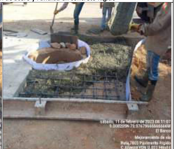
HITO 4 – RUTA 7805 PAVIMENTO RÍGIDO EL BANCO, Figuración de acero y Fundida en concreto Rígido
