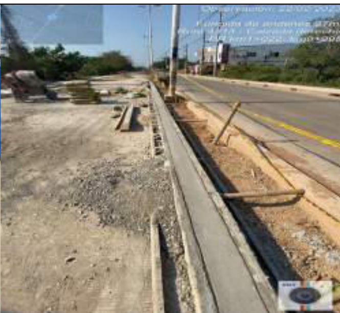
HITO 4 – RUTA 4313 PAVIMENTO RÍGIDO EL BANCO, Fundida de Andenes peatonales.
