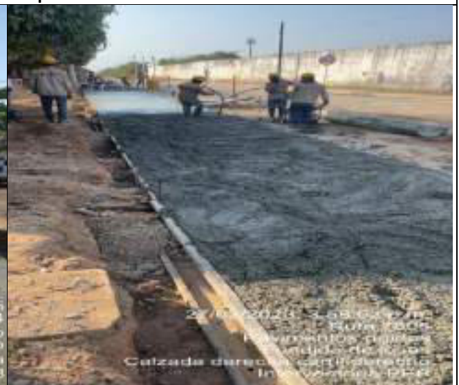
HITO 4 – RUTA 7805 PAVIMENTO RÍGIDO EL BANCO, Figuración de acero y Fundida en concreto Rígido
