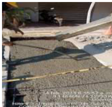
HITO 3 – RUTA 7804 PAVIMENTO RÍGIDO DE GUAMAL – REPARACIÓN DE LOSAS DE PAVIMENTO RIGIDO
