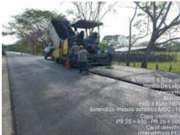
HITO 3 – RUTA 7804 EXTENDIDO DE MEZCLA ASFÁLTICA MDC – 19 SECTOR MARGARITA (2da CAPA)
