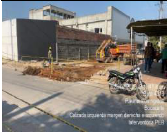
HITO 4 – RUTA 4313 PAVIMENTO RÍGIDO EL BANCO – Demolición, retiro y explanación
