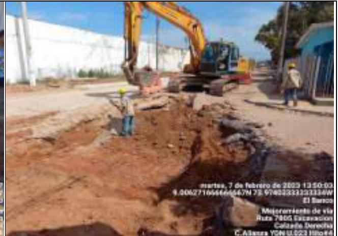
HITO 4 – RUTA 7805 PAVIMENTO RÍGIDO EL BANCO – Explanación y retiro de material
