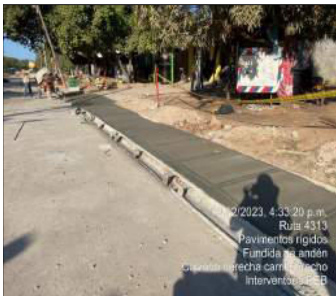
HITO 4 – RUTA 4313 PAVIMENTO RÍGIDO EL BANCO, Fundida de Andenes peatonales.
