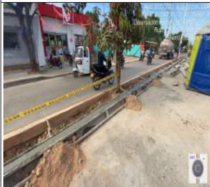
HITO 4 – RUTA 4313 PAVIMENTO RÍGIDO EL BANCO, Fundida de Bordillos
