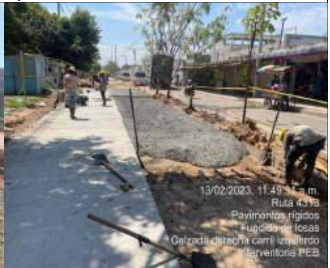
HITO 4 – RUTA 4313 PAVIMENTO RÍGIDO EL BANCO, Fundida de placas en concreto
