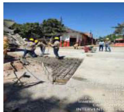
HITO 3 - RUTA 7804 PAVIMENTO RÍGIDO GUAMAL – FUNDIDA LOSAS DE PAVIMENTO RIGIDO INTERSECCIÓN CALLE CON CRA 4
