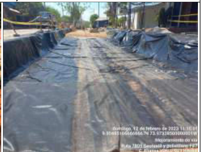
HITO 4 – RUTA 7805 PAVIMENTO RÍGIDO EL BANCO, Colocación de Geotextil y Polietileno
