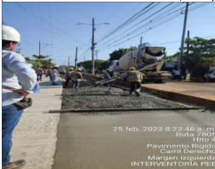
HITO 4 – RUTA 7805 PAVIMENTO RÍGIDO EL BANCO, Figuración de acero y Fundida en concreto Rígido
