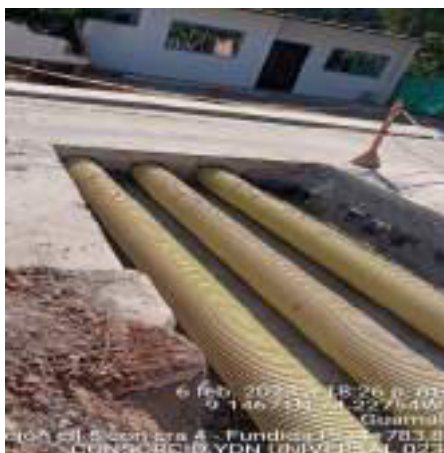
HITO 3 – RUTA 7804 PAVIMENTO RÍGIDO DE GUAMAL – INSTALACIÓN DE TUBERIA PVC 14” CARRIL IZQUIERDO DESAGUE AGUAS LLUVIAS
