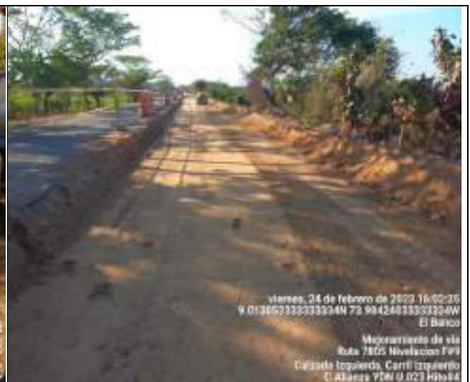
HITO 4 – RUTA 7805 PAVIMENTO RÍGIDO EL BANCO, Relleno y compactación con Suelo cemento
