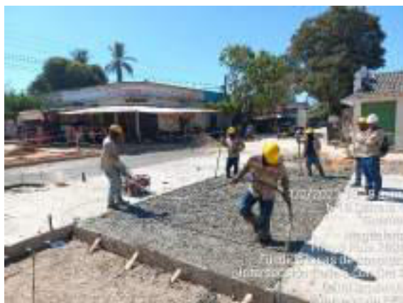
HITO 3 - RUTA 7804 PAVIMENTO RÍGIDO GUAMAL – FUNDIDA LOSAS DE PAVIMENTO RIGIDO INTERSECCIÓN CALLE CON CRA 4
