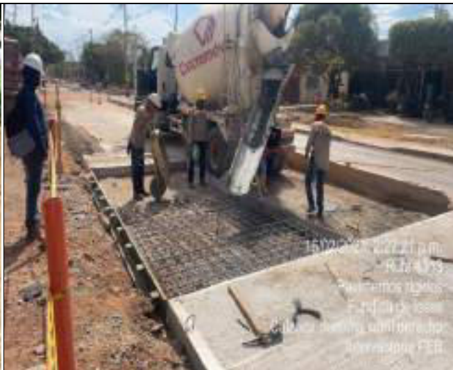
HITO 4 – RUTA 4313 PAVIMENTO RÍGIDO EL BANCO, Figuración de acero para parrillas dobles en losas irregulares.
