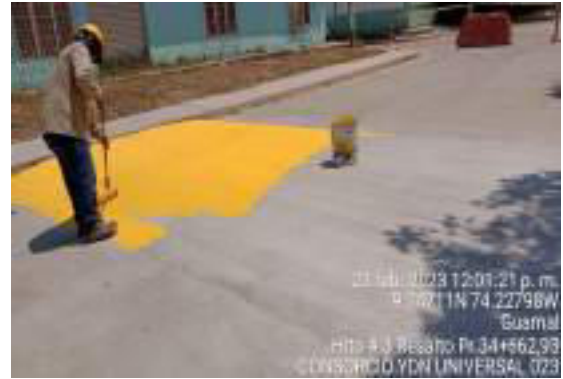
HITO 3 – RUTA 7804 INSTALACIÓN DE RESALTO EN CONCRETO TIPO INVIAS SECTOR GUAMAL
