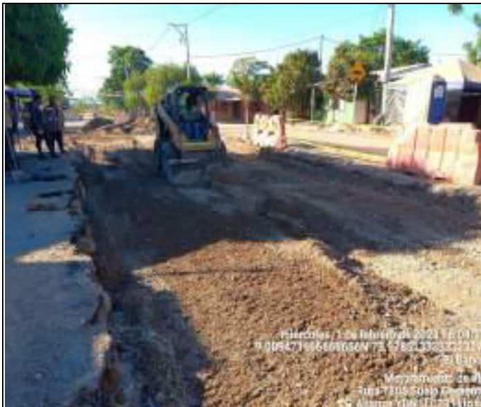
HITO 4 – RUTA 4313 PAVIMENTO RÍGIDO EL BANCO, Relleno y Compactación con Suelo cemento
