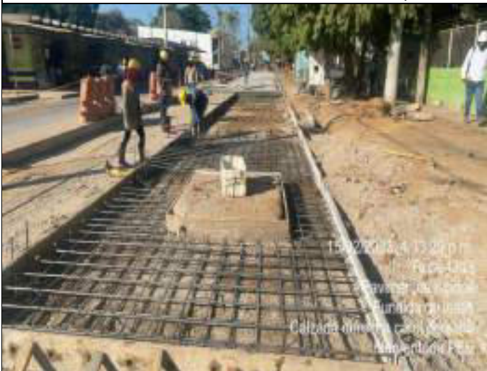
HITO 4 – RUTA 4313 PAVIMENTO RÍGIDO EL BANCO, Figuración de acero para parrillas dobles en losas irregulares.
