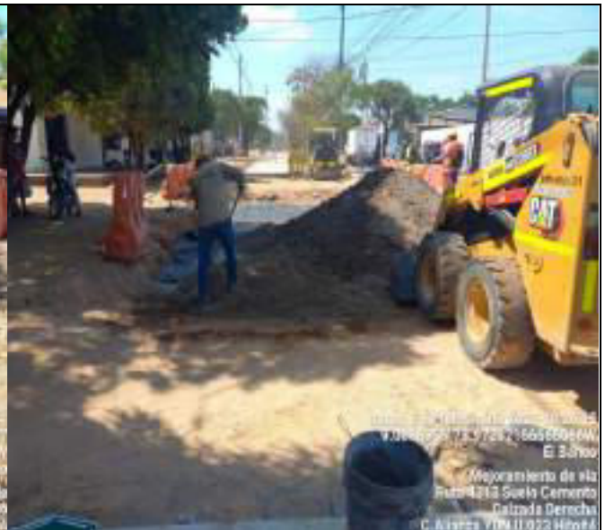
HITO 4 – RUTA 4313 PAVIMENTO RÍGIDO EL BANCO, Relleno y Compactación con Suelo cemento
