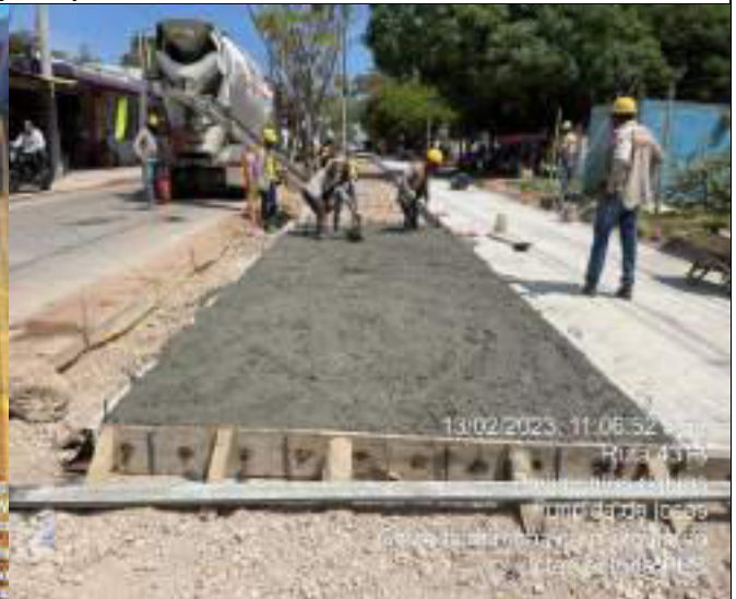
HITO 4 – RUTA 4313 PAVIMENTO RÍGIDO EL BANCO, Fundida de placas en concreto
