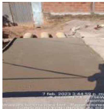
HITO 3 – RUTA 7804 PAVIMENTO RÍGIDO DE GUAMAL – INSTALACIÓN DE TUBERIA PVC 14” CARRIL IZQUIERDO DESAGUE AGUAS LLUVIAS
