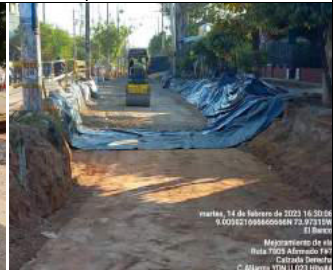
HITO 4 – RUTA 7805 PAVIMENTO RÍGIDO EL BANCO Estabilización con material Granular (Afirmado)
