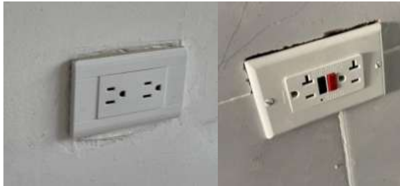
imagen 36. instalación de tomacorrientes de 110V y tomacorrientes 110V GFCI.
