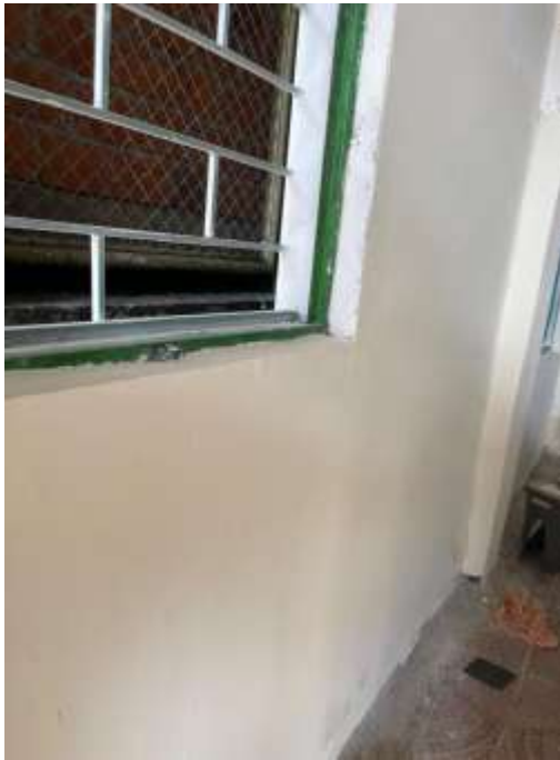
imagen 12. Instalación de estuco y pintura tipo 1.
