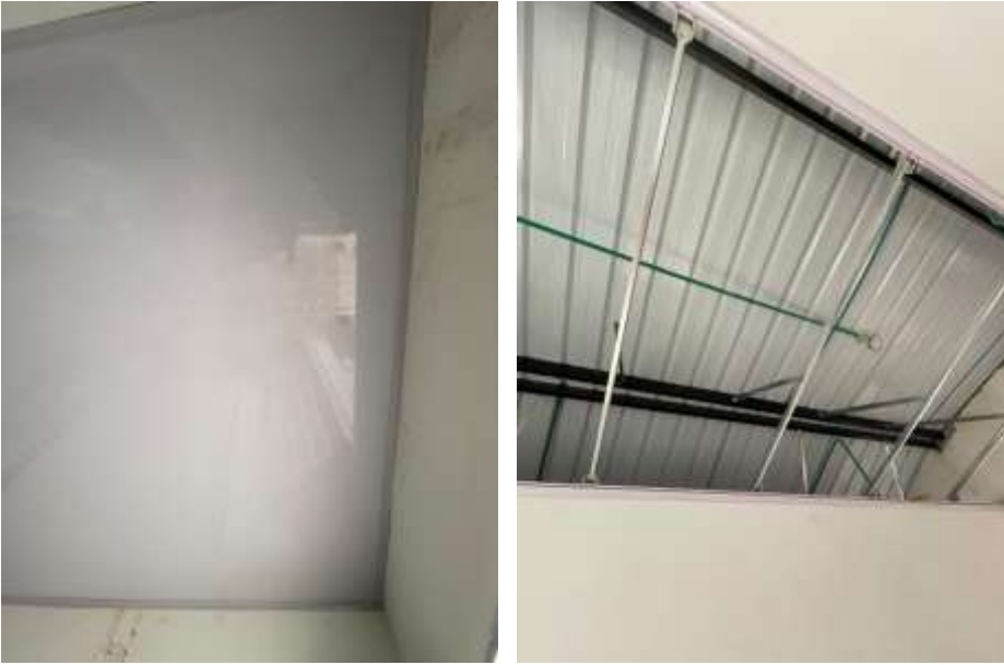
imagen 24. Instalación de cielo raso.
