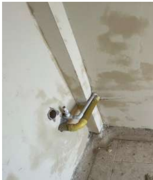
imagen 23. Instalación de punto de desagüe sanitario.
