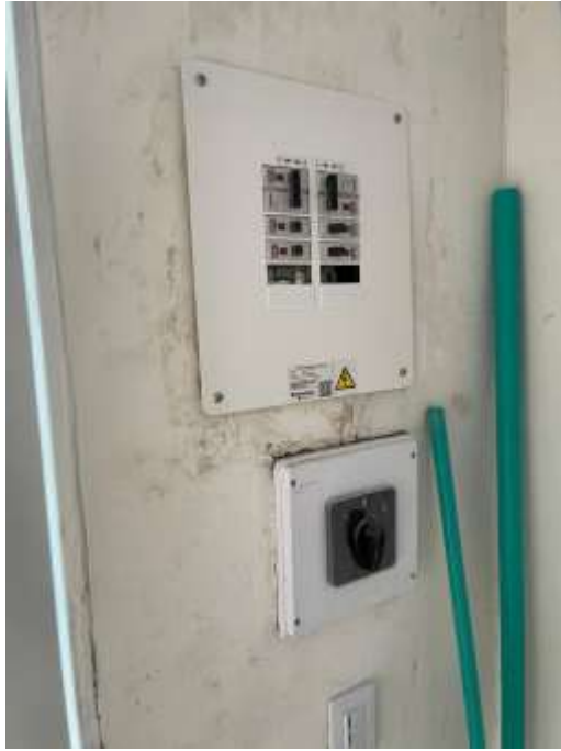
imagen 28. instalación de tablero de control y transferencia manual.
