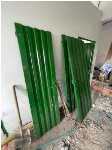
imagen 18. Mantenimiento de puertas y ventanas.
