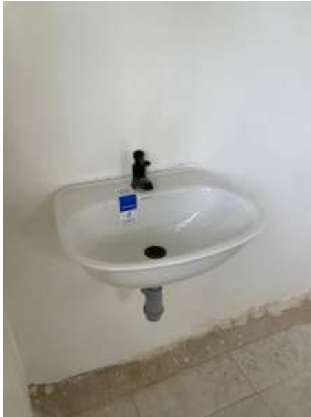
imagen 20. Instalación de lavamanos de colgar.
