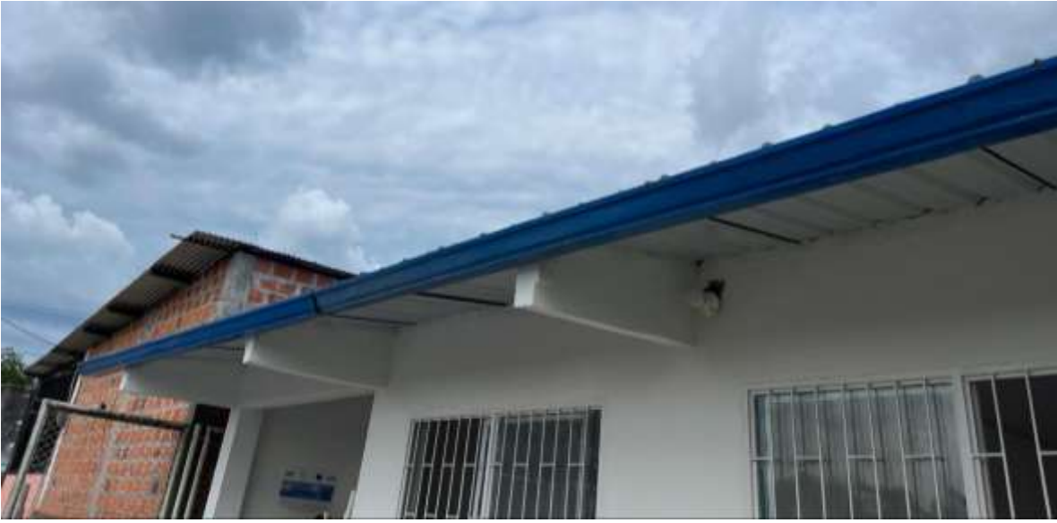
imagen 26. instalación de canal recolector de aguas lluvias.
