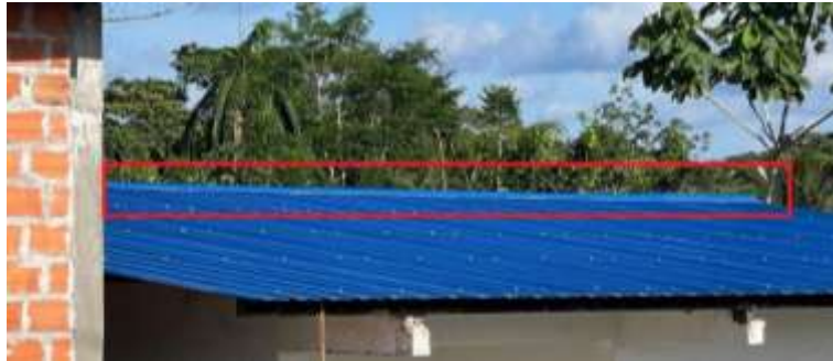
imagen 10. instalación de Caballete metálico.
