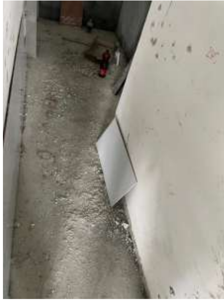
imagen 3. Demolición de piso cerámico.
