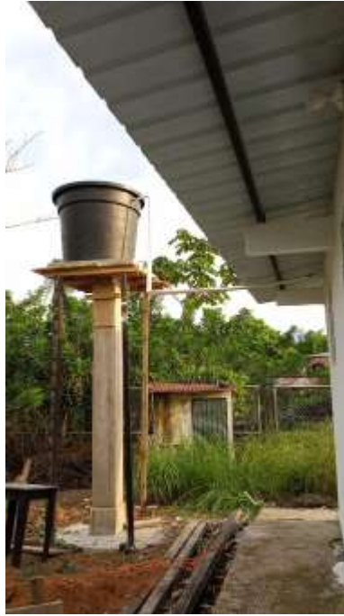
imagen 34. instalación de tanque para distribución de agua.
