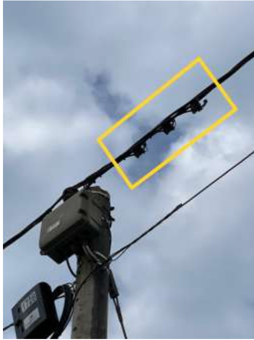
imagen 30. Instalación de lonchera de conexión a red de distribución.
