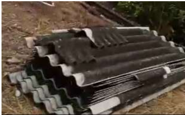
imagen 2. Desmonte y retiro de cubierta existente.
