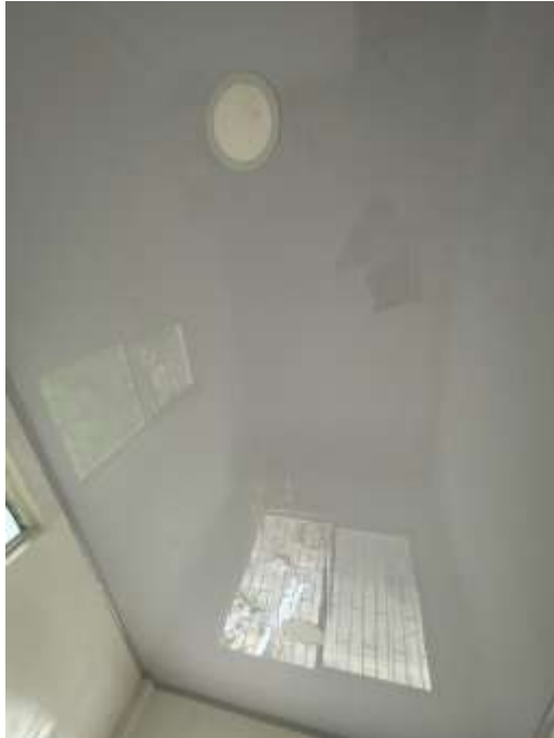
imagen 29. instalación de lámparas luminarias tipo LED.
