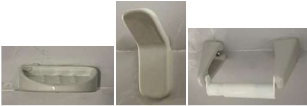
imagen 21. Instalación de accesorios de baño.
