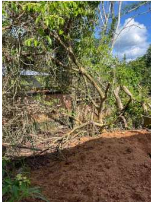
imagen 4. Limpieza de Material vegetal.
