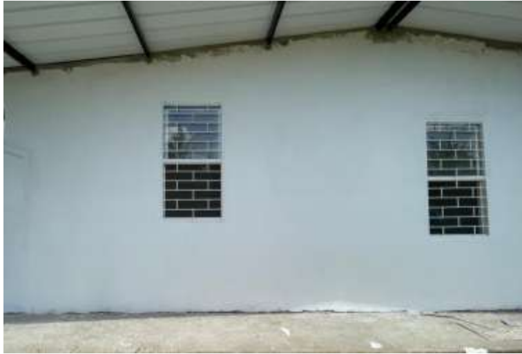
imagen 13. Estuco y pintura para muros exteriores.
