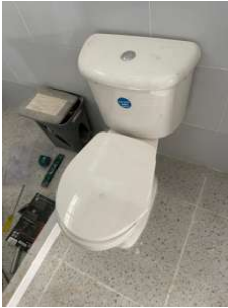
imagen 19. Instalación de sanitarios.
