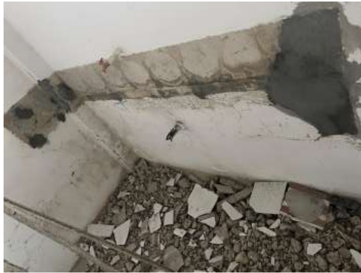
imagen 6. Demolición de mesones en concreto.
