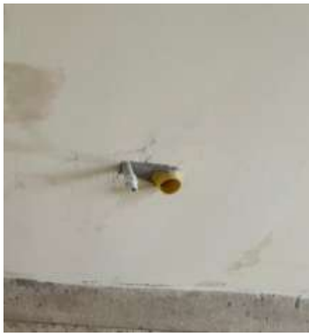
imagen 22. Instalación de punto hidráulico.
