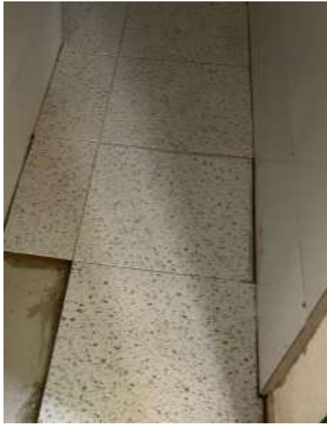
imagen 16. Instalación de cerámica en piso de baños.
