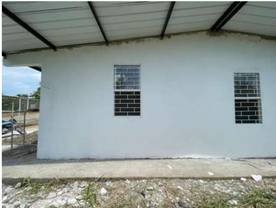
imagen 25. Aplicación de estuco y pintura.
