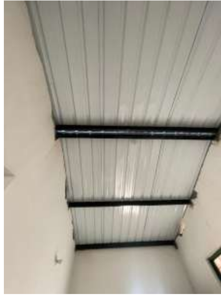
imagen 9. instalación de cubierta metálica.
