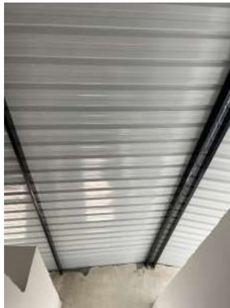
imagen 8. Instalación de estructura metálica para cubierta.
