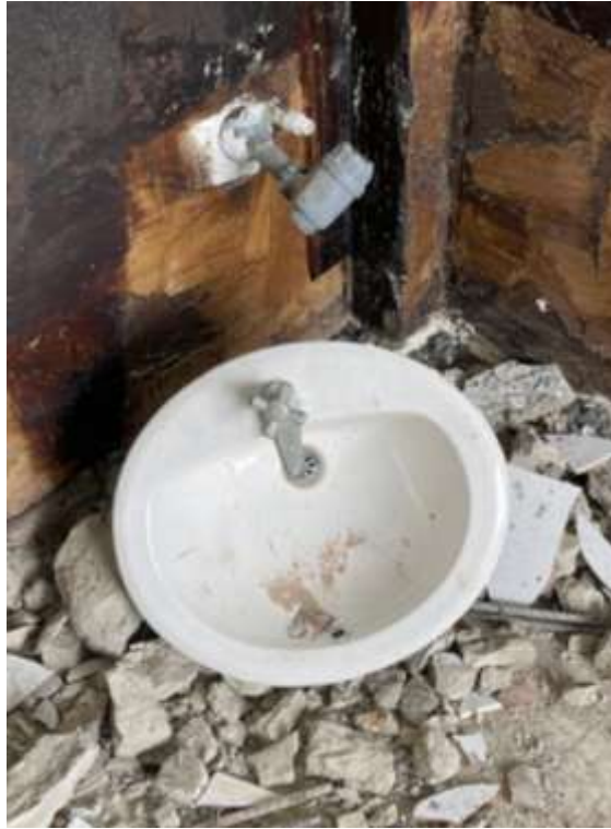
imagen 1. Desmonte de aparatos sanitarios.
