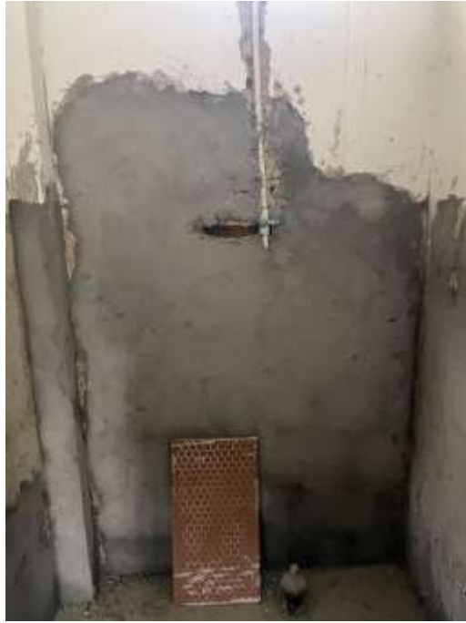
imagen 5. Demolición y retiro de enchape de muros.
