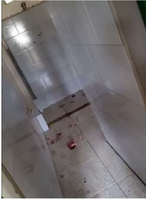
imagen 11. Instalación de enchape de muros en baños.
