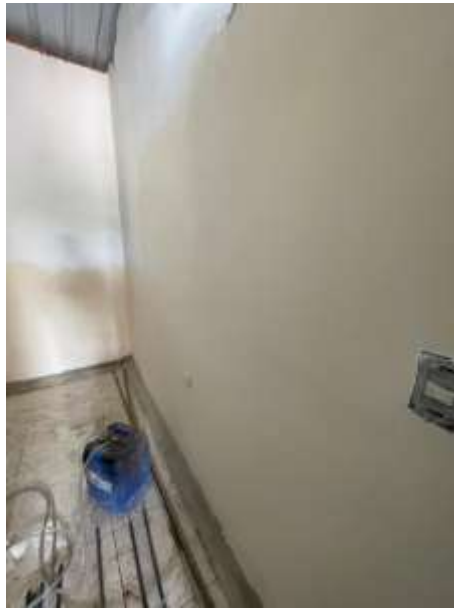
imagen 14. Aplicación de estuco y pintura de alta asepsia.
