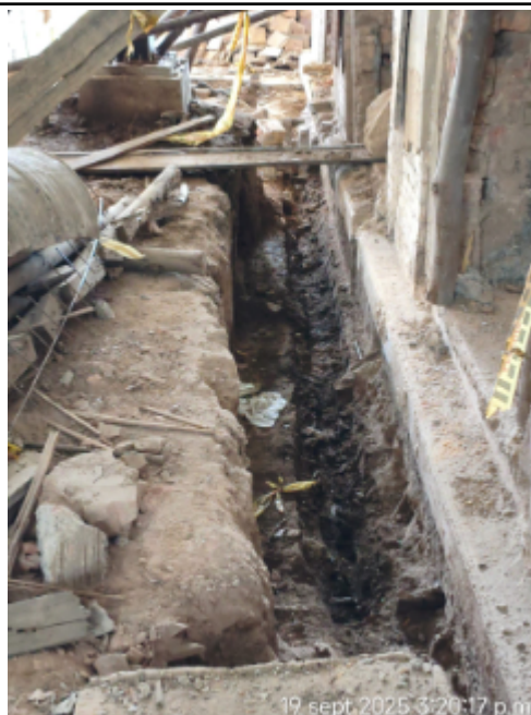
Ilustración AQU 2. Desmante de la cañuela en el espacio 130.
