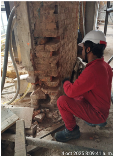
Ilustración TEC 3. Restitución de muros
