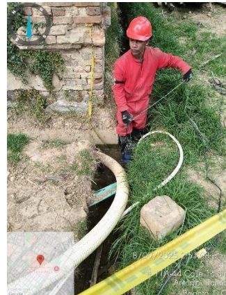
Ilustración AMB 43. Actividades de bombeo
