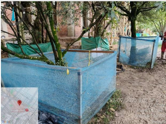
Ilustración AMB 51. Verificación de protección arbórea
