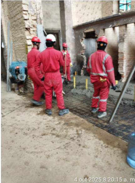
Ilustración TEC 1. Fundición placa baños costado occidental
