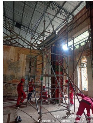
Ilustración SST 08. Inspección Sistemas de acceso
