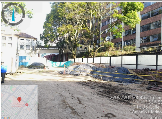
Ilustración AMB 7. Señalización y protección de material
