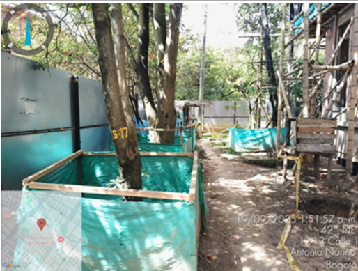
Ilustración AMB 50. Verificación de protección arbórea
