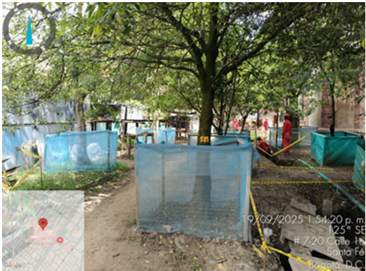
Ilustración AMB 49. Verificación de protección arbórea
