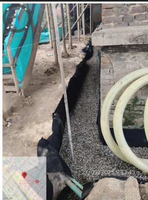
Ilustración AMB 3. Llenos con grava reutilizada.
