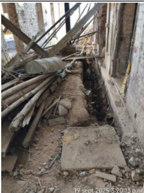
Ilustración AQU 1. Desmante de cañuela en el espacio 130.
