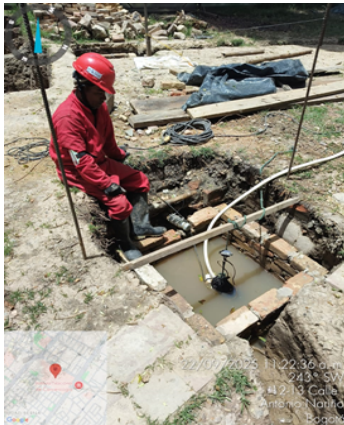
Ilustración AMB 42. Actividades de bombeo
