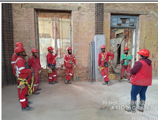
Ilustración SST 13. Inspección EPCC
