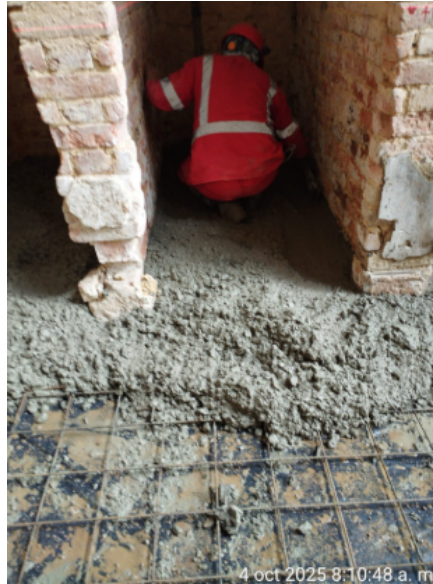
Ilustración TEC 2. Fundición placa baños costado occidental
