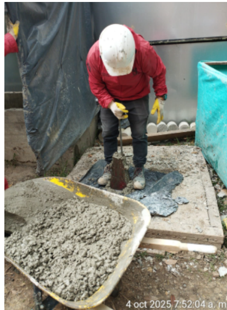
Ilustración TEC 4. Pruebas de slump para concreto de placas de piso
