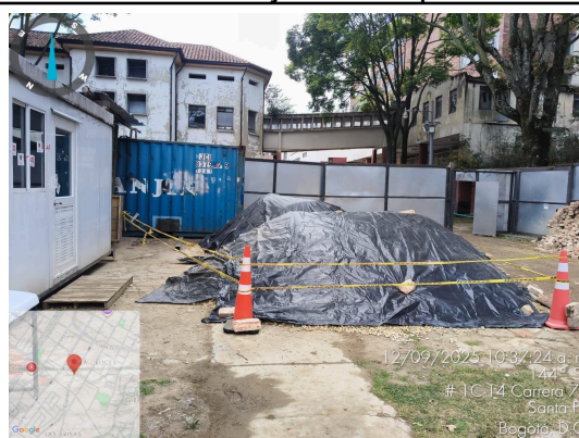
Ilustración AMB 8. Señalización y protección de material
