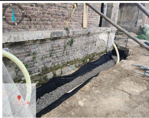
Ilustración AMB 4. Llenos con grava reutilizada.
