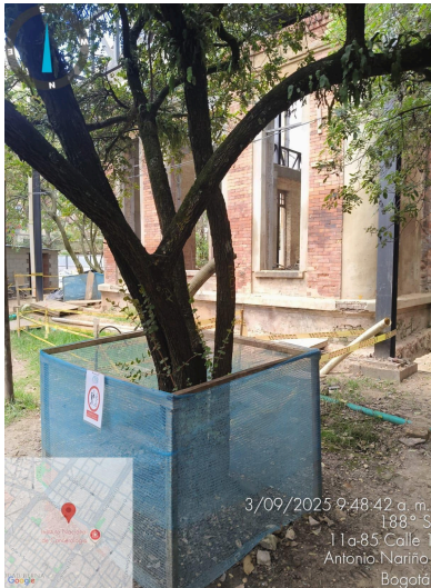
Ilustración AMB 48. Verificación de protección arbórea
