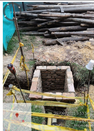
Ilustración AMB 6. Reutilización de ladrillos en cajas de inspección
