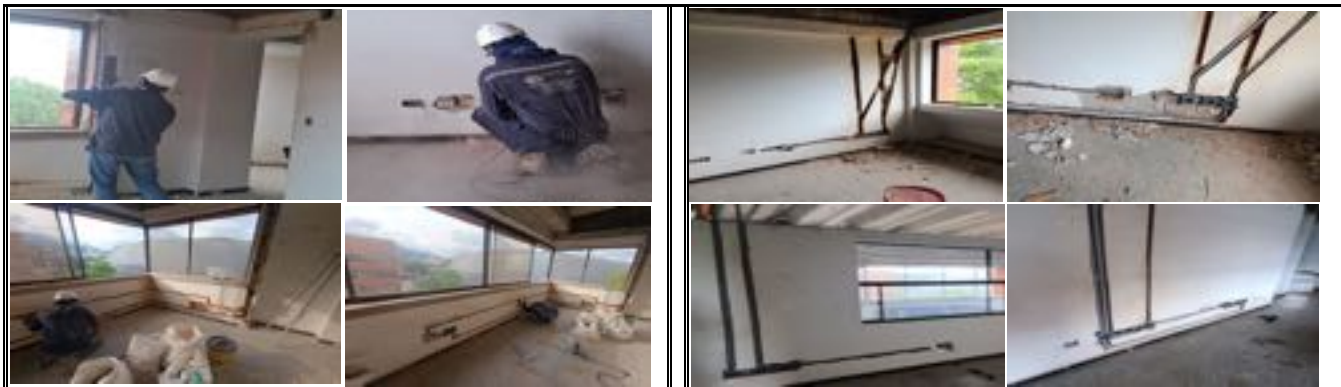
REGATAS EN MUROS OFICINAS 501-507 PARA INSTALACION DE TUBERIA SHC Y CAJAS ELECTRICAS PISO 5 TORRE B - SE HACE LA INSTALACION DE LAS CAJAS EN LOS PUNTOS SOLICITADOS POR EL AREA DE SISTEMAS DEL P JV DE ACUERDO AL REQUERIMIENTO DE PERSONAL EN LAS OFICINAS QUE SE ESTÁN ADECUANDO
