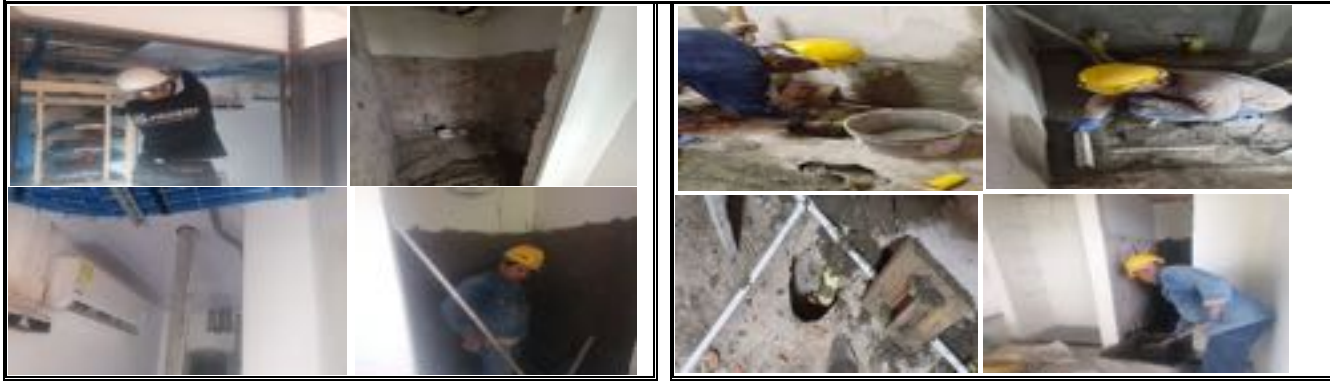
INSTALACION DE CIELO RASO PVC BLANCO EN ZONA DE RACK COMUNICACIONES / INSTALACION DE TUBERIA SUMINISTRO Y FUNDIDA SOBRE PISO PISO BAÑOS MAGISTRADOS ALA B TORRE B PISO 5
