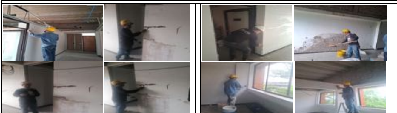
REPARACION DE MUROS (CORRECCION DE FISURAS, LLENADO CON IMPERMUR, PAÑETE Y ESTUCCO) OFICINAS 501 A 508 B TORRE B PISO 5
