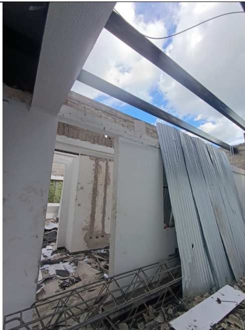
DESMONTE DE TEJA EN ASBESTO CEMENTO
