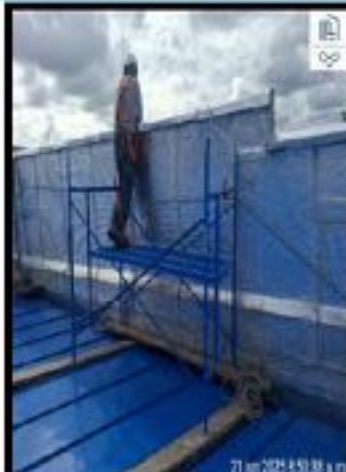
Inspección actividad izaje de teja, protección de línea de vida, andamio anclado y con todos los accesorios
