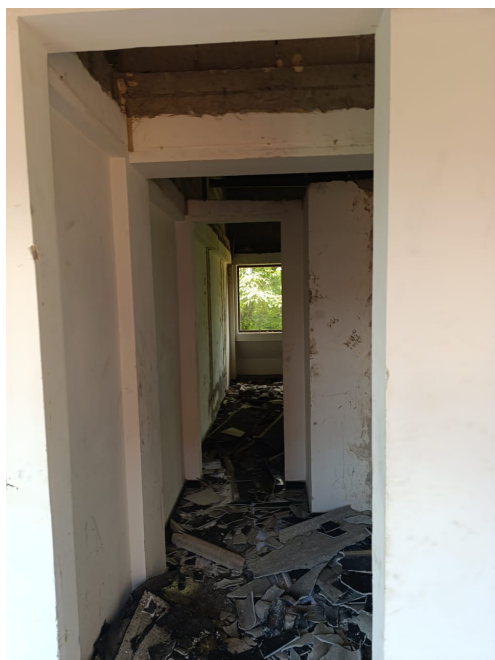
DESMONTE DE TEJA EN ASBESTO CEMENTO
