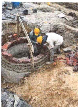
Foto 7: Mampostería con ladrillo tolete macizo (6x12x25) cm, pañete interior con mortero 1:3
