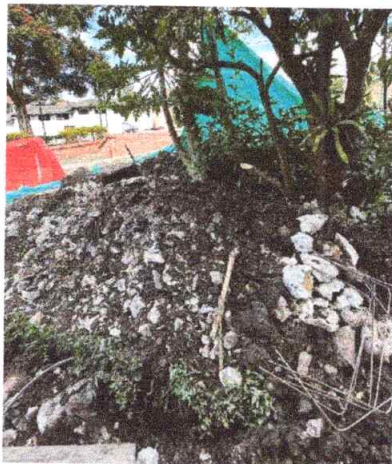
Foto 5. Cargue y retiro de material tipo escombros a sitio de disposición
