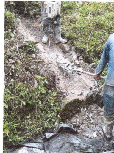
Foto 6: Demolición de estructuras varias en concreto
