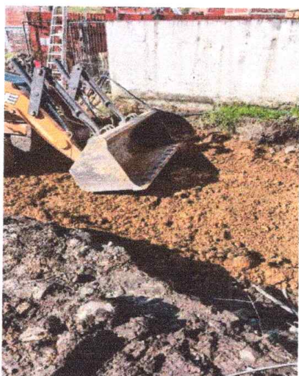
Foto 3: Relleno compactado en material de recebo
