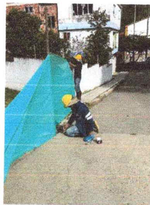
Foto 2. Cerramiento en tela verde H: 2,00 m
