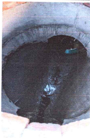
Foto 3. Concreto impermeabilizado 28 Mpa (4000 psi) para cañuelas
