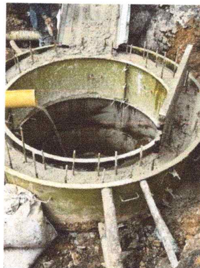
Foto 4: Concreto impermeabilizado f_c : 28 Mpa (4000 psi) para construcción de pozos de inspección
