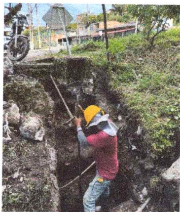
Foto 5: Excavación manual para estructuras
