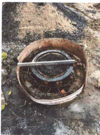
Foto 5. Tapa para pozo de inspección D(0.65 – 0.75) M en hierro fundido (incluye núcleo en concreto de 3500 psi)
