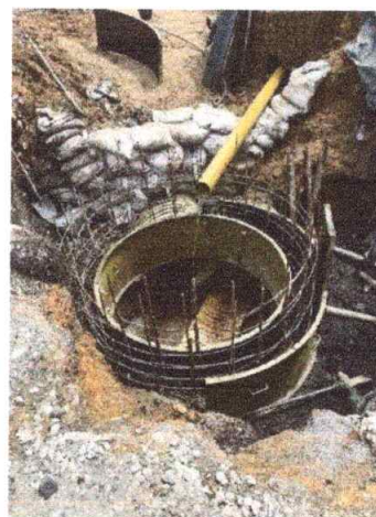
Foto 6: Acero de refuerzo F_y=60000 psi (420 Mpa) ASTM A-706
