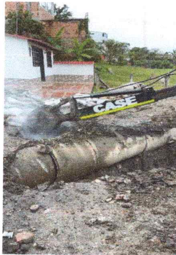
Foto 3. Extracción de tubería existente
