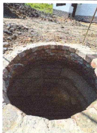
Foto 6: Peldaños en varilla de acero 60 D=3/4" L=1.30 m con recubrimiento anticorrosivo @0.25 m
