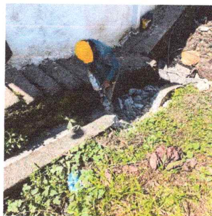
Foto 2. Demolición de andenes e = (0.15 - 0.20)m
