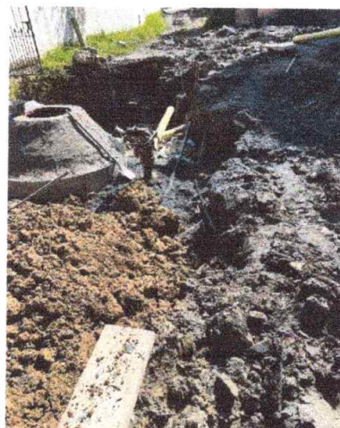
Foto 2: Relleno compactado en material proveniente de excavación
