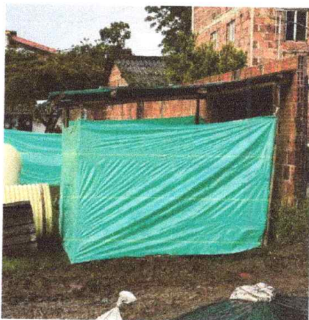
Foto 3. Campamento provisional en Tela Verde y teja de zinc (15m2)
