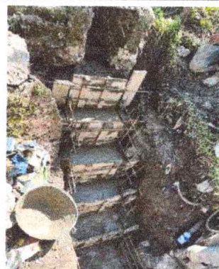
Foto 2. Construcción de escalera disipadora en concreto para entrega al pozo de inspección (reemplazo de canal existente)
