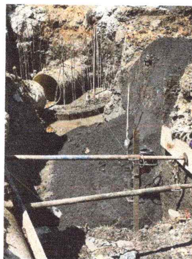
Foto 4: Entibado en madera para zanja H>1.5 m
