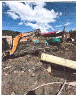
Foto 1: Suministro e instalación de tubería de D=36" - 900 mm para alcantarillado pluvial y descole
