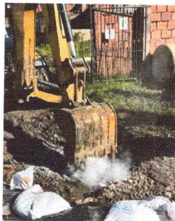
Foto 1: Demolición de estructuras h > 0.8 (pozos de inspección)
