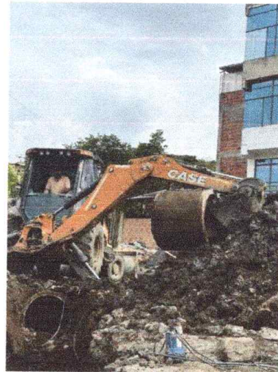
Foto 4: cargue y retiro de tubería existente
