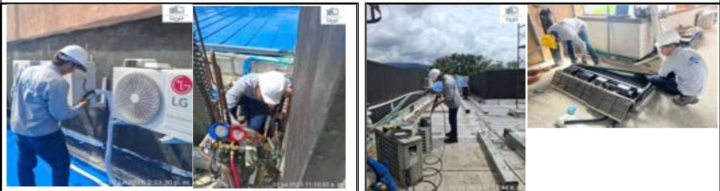
INSTALACION DE TUBERIA PARA AIRES ACONDICIONADOS / MANTENIMIENTO AIRES ACONDICIONADOS - SE ADELANTA LA ACTIVIDAD DE MANTENIMIENTO Y LIMPIEZA DE LOS EQUIPOS DE AIRE ACONDICIONADO (MINI SPLIT) QUE SE HAN DESMONTADO DE LAS OFICINAS 501 Y SE ICONTINUA CON EL PROCESO DE LAVADO Y LIMPIEZA DE LOS MISMOS PARA SU CORRECO FUNCIONAMIENTO. ASÍ COMO SE ADELANTA LA INSTALACIÓN DE LA TUBERÍA DE COBRE CORRESPONDIENTE PARA CADA UNO DE LOS EQUIPOS QUE SE VAN A INSTALAR POSTERIORMENTE, POR PARTE DE LOS TECNICOS DE AIRE ACONDICIONADO.
