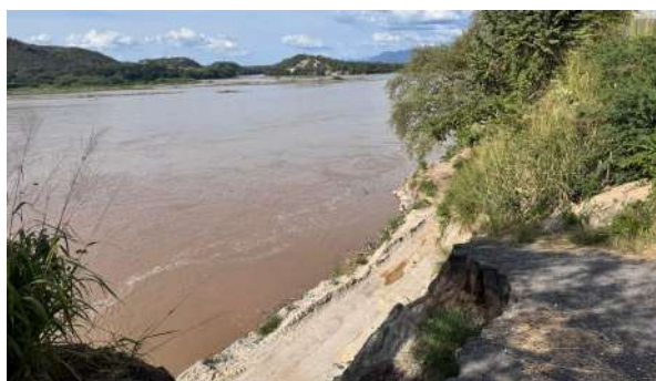
UF3 - PR 66+700 - Construcción de Enrocado.
