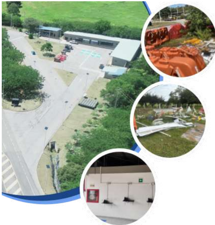
Figura 22. Hallazgos evidenciados en el Área de Servicios Cambao.
