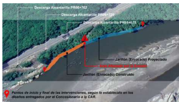
UF3 - PR 66+700 - Área afectada por la erosión.
