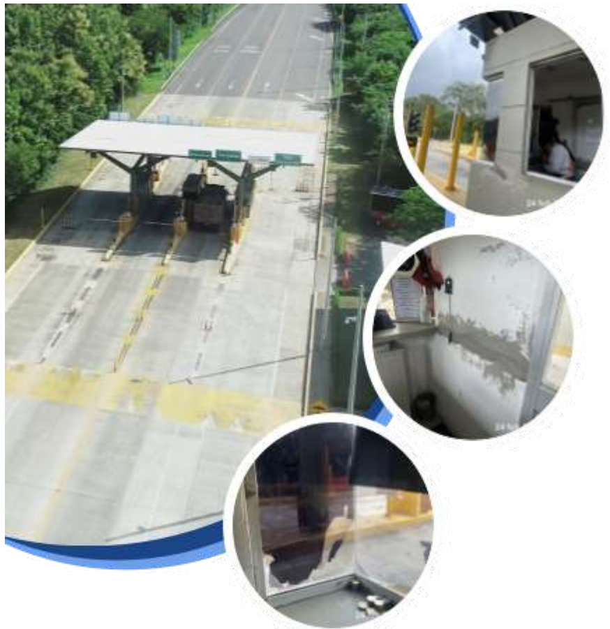
Figura 24. Hallazgos evidenciados Peaje Cambao
