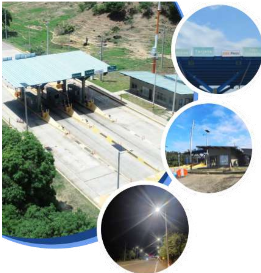
Figura 21. Hallazgos evidenciados Peaje Guataquí.
