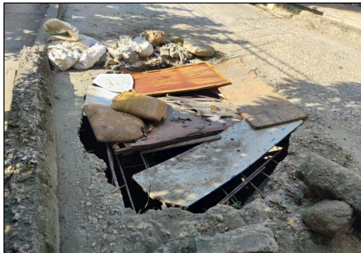
Verificación estado actual Box Culvert
