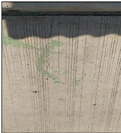
Verificación de fisuras en pavimento
