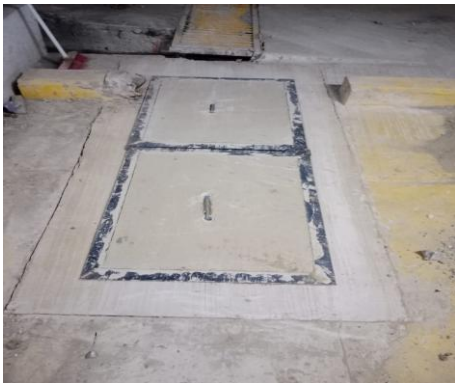
Tapas de concreto Desarenador
