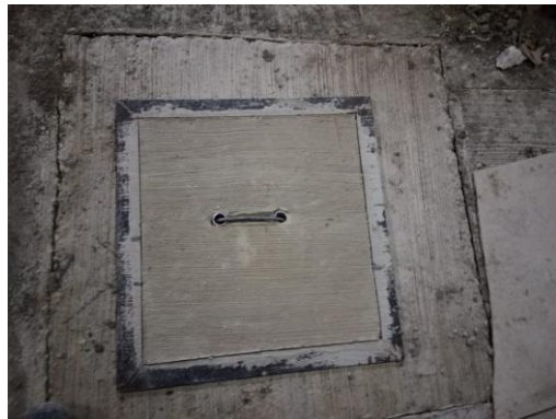
Tapas Registro de Inspección
