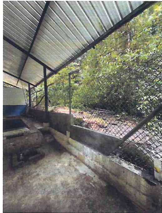
DESPUES: CERRAMIENTO MURO EN LADRILLO, COLUMNAS EN CONCRETO BOCATOMA CRISTALINA
