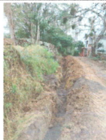
Relleno de zanja con material granular fino y/o Recebo
