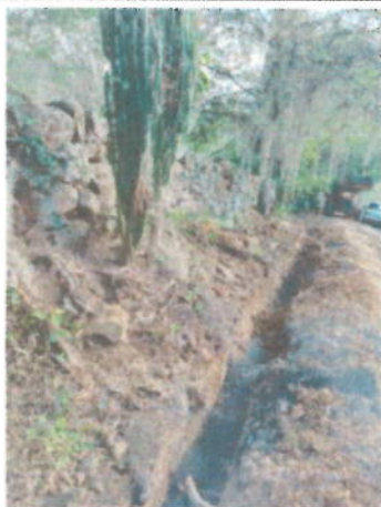
Relleno de zanja con material granular fino y/o Recebo
