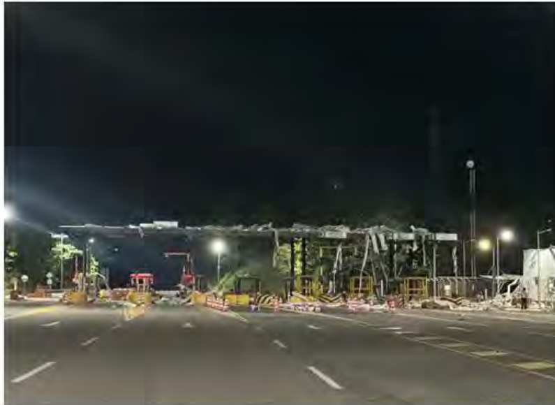
Presuntos guerrilleros del Eln, que adelantan un 'paro armado', destruyeron el peaje La Lizama situado en la vía entre Bucaramanga y Barrancabermeja. FOTO: Tomada de redes sociales.
