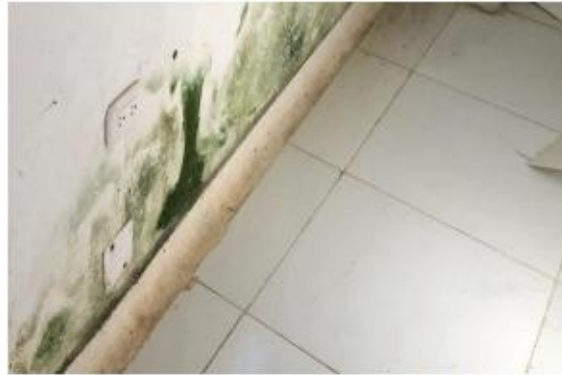
Los interruptores y tomacorrientes muestran signos de deterioro evidentes, partes sueltas y la presencia de humedad en las cercanías
