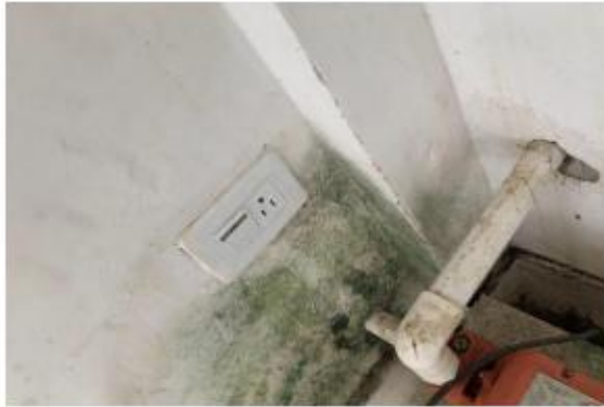
Los interruptores y tomacorrientes muestran signos de deterioro evidentes, partes sueltas y la presencia de humedad en las cercanías
