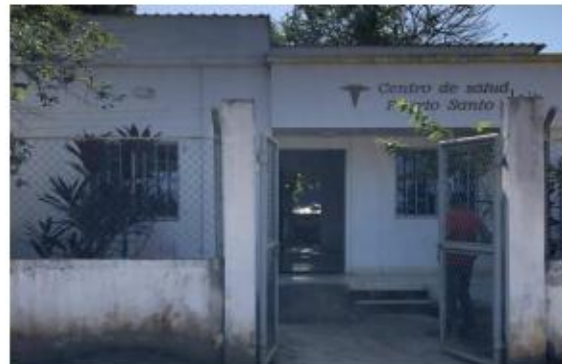
La fachada está en condiciones deplorables, con una notable acumulación de moho y grietas en prácticamente todas sus áreas, además de una pintura en mal estado y desprendimientos evidentes.
