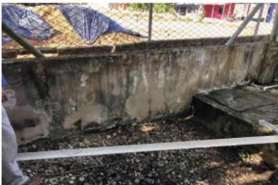
La fachada está en condiciones deplorables, con una notable acumulación de moho y grietas en prácticamente todas sus áreas, además de una pintura en mal estado y desprendimientos evidentes.
