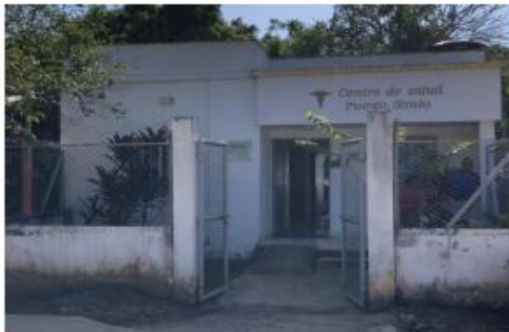
La fachada está en condiciones deplorables, con una notable acumulación de moho y grietas en prácticamente todas sus áreas, además de una pintura en mal estado y desprendimientos evidentes.
