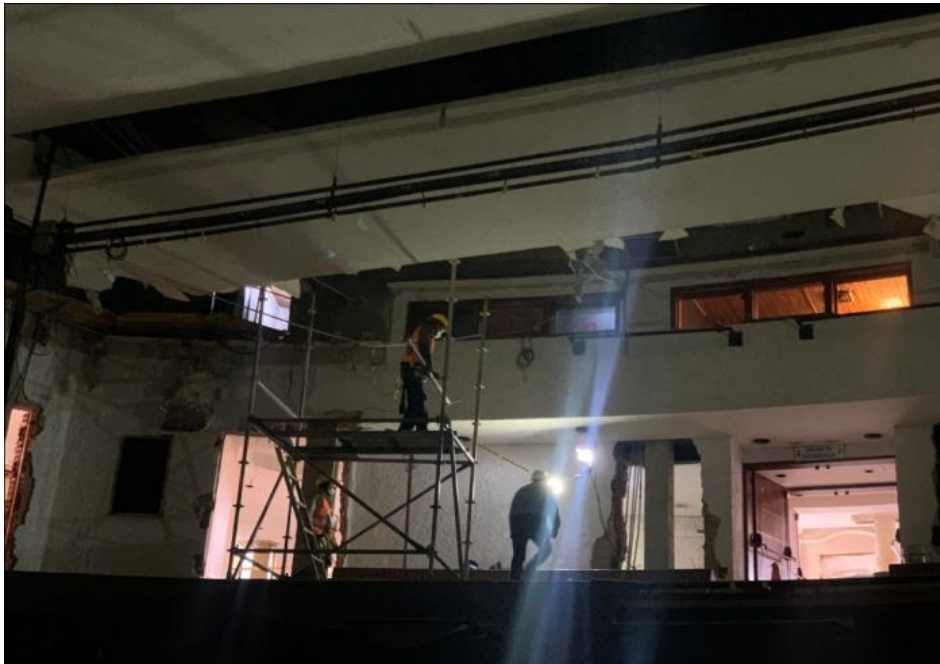
Fotografía No. 14 Demolicion cielo raso
