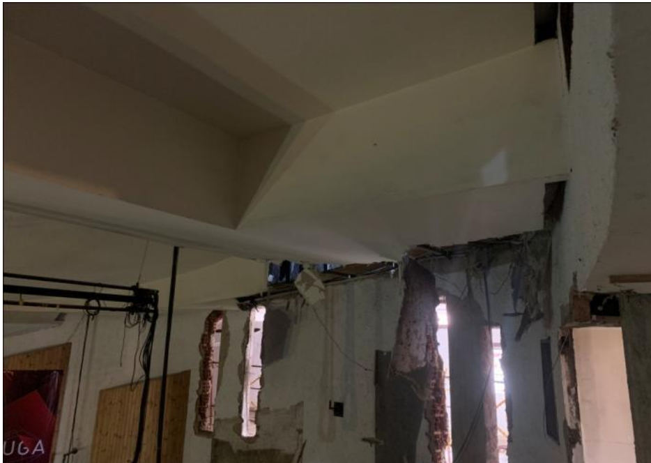
Fotografía No. 13 Inicio demolición cielo raso
