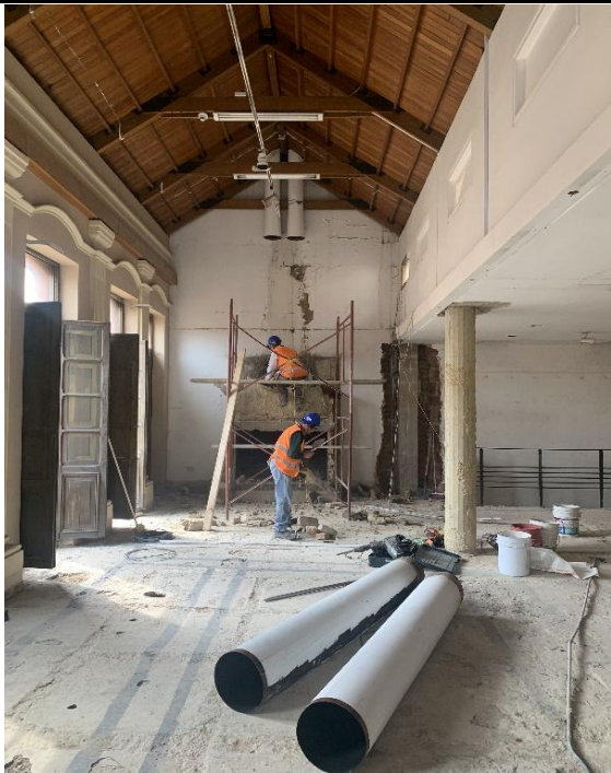
Fotografía No. 8 Desmonte ductos chimenea
