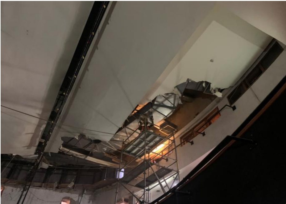
Fotografía No. 15 Demolición cielo raso
