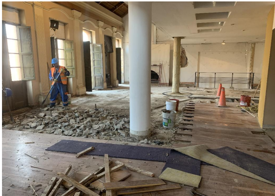
Fotografía No. 7 Demolición entrepiso en concreto
