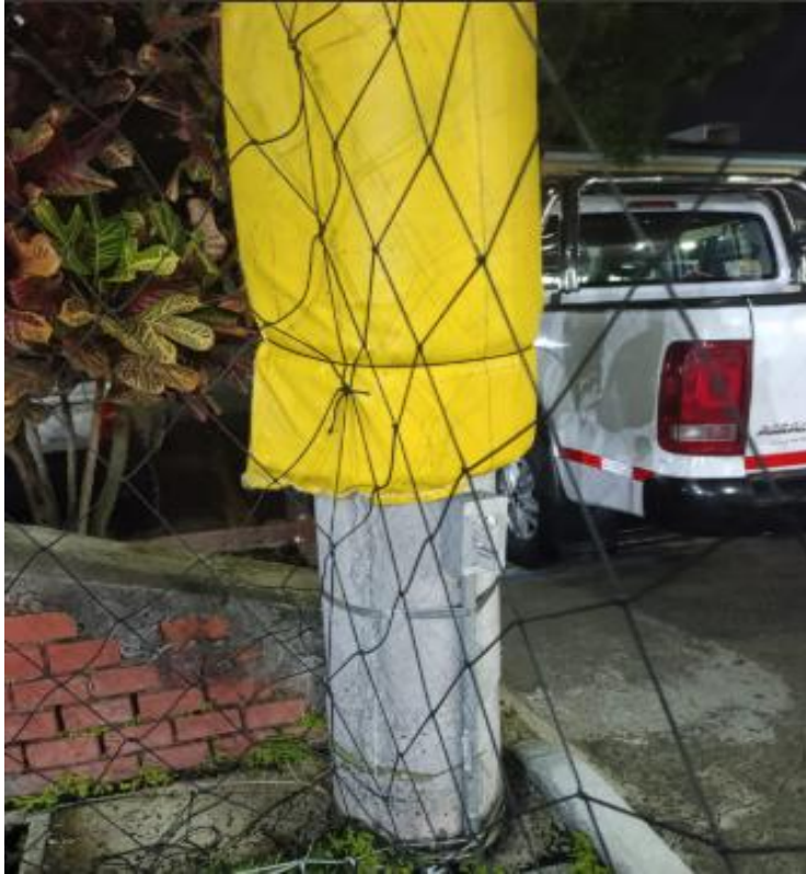
Foto: Evidencia instalación protectores de poste en espuma
