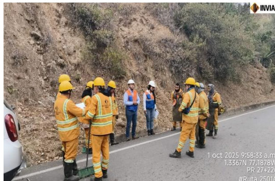
Foto No. 2. 01/10/2025. Control de actividades y visita cooperativa La Gran Vía. PR27+0220 Ruta2501A.
