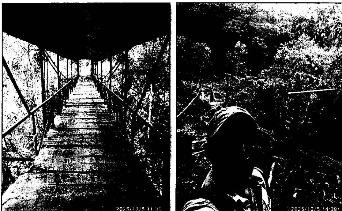
Fotografía 11 y 12. Actividad realizada en el mes de diciembre del 2025, apoye a la secretaria de infraestructura realizando visita técnica a los puentes peatonales de la vereda Cajones.
