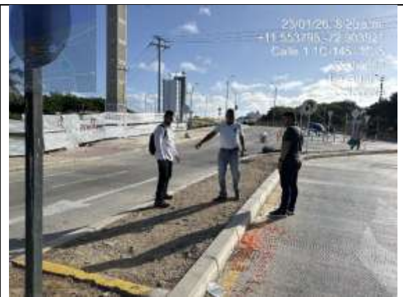
Foto 2: Acompañamiento e inspección coordinador de Alumbrado público.
