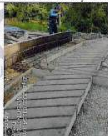
Instalación de acero en cunetas y vigas
