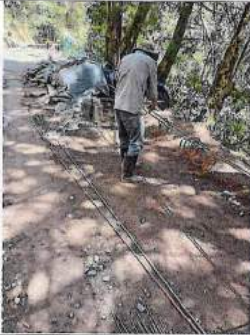
Figurado de acero de refuerzo
