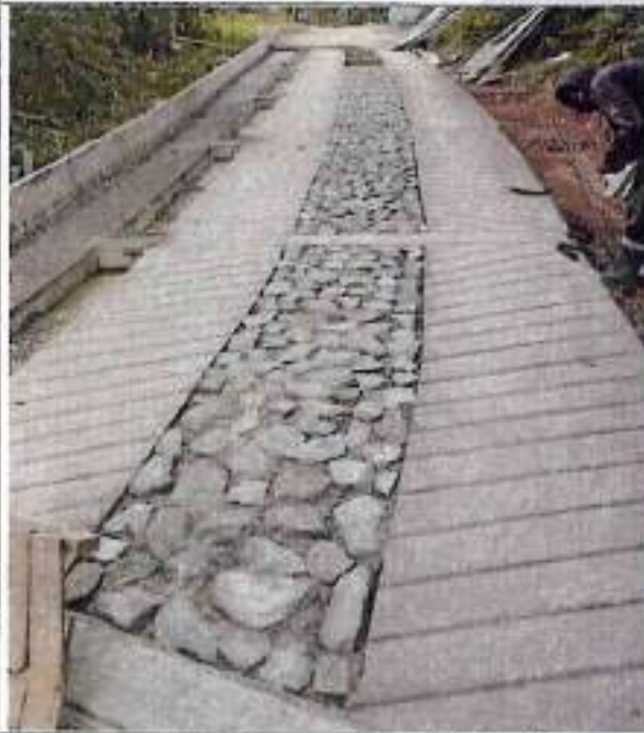
Vaciado concreto tipo ciclopeo
