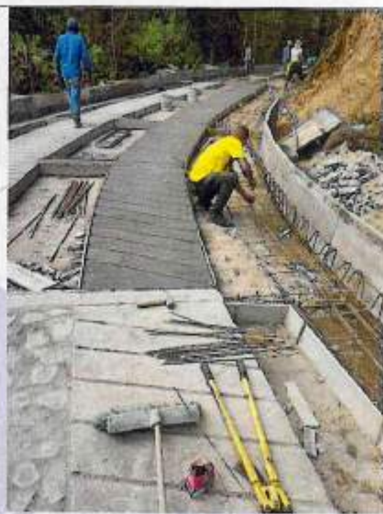
Instalación de acero en cunetas y vigas
