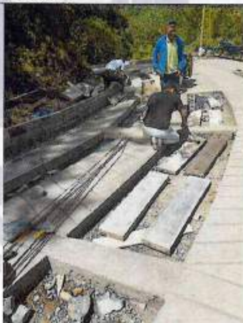
Instalación de acero y formaleta
