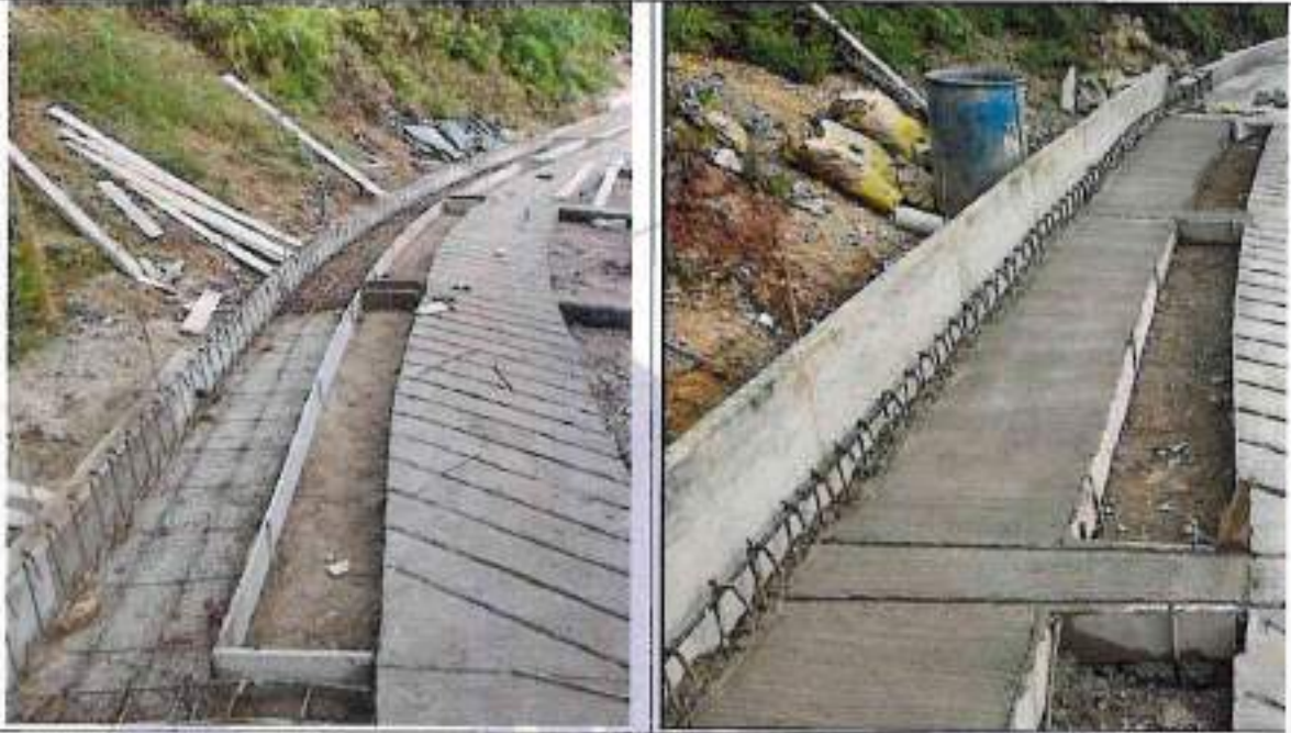
Instalación de acero en cunetas y vigas
