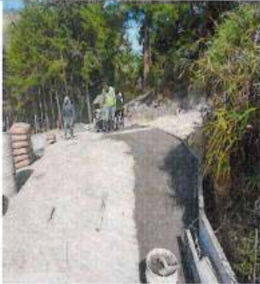
Construcción de cunetas
