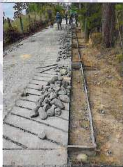
Vaciado concreto ciclopeo
