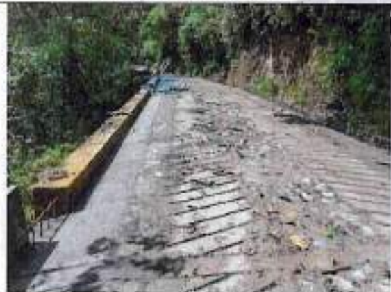
Vaciado concreto tipo ciclópeo
