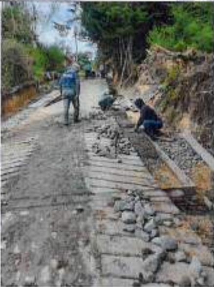
Vaciado concreto ciclopeo
