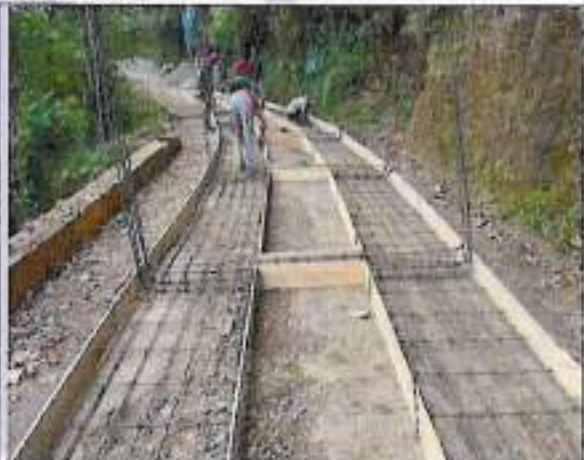
Instalación de acero y formaleta
