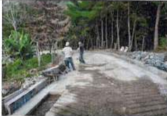
Vaciado concreto ciclópeo
