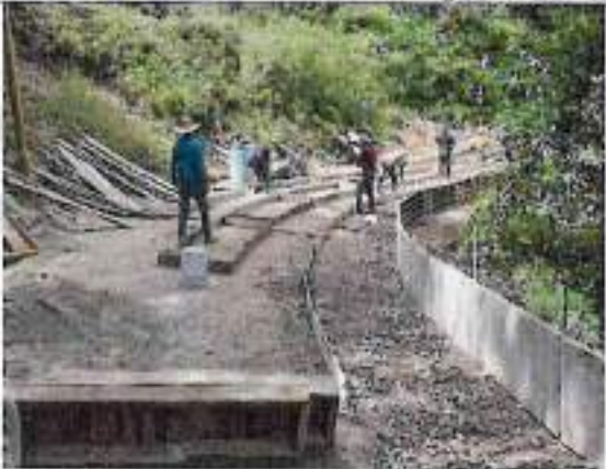
Instalación de acero y formaleta
