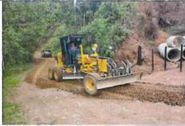
Instalación y compactación de base granular
