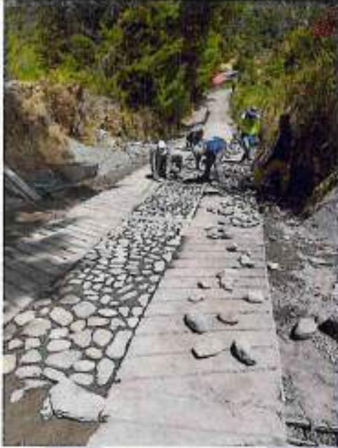
Vaciado concreto ciclopeo
