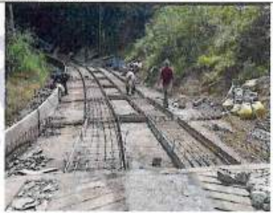
Instalación de acero y formaleta
