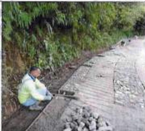
Construcción de cunetas
