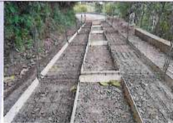
Instalación de acero y formaleta
