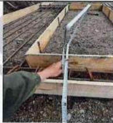
Instalación de formaleta y acero de refuerzo
