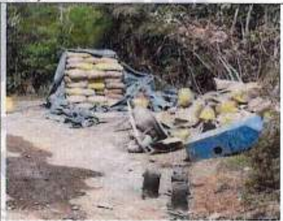
Acopio de material
