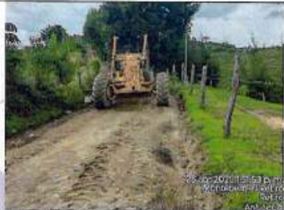
Instalación y compactación Subbase Granular
