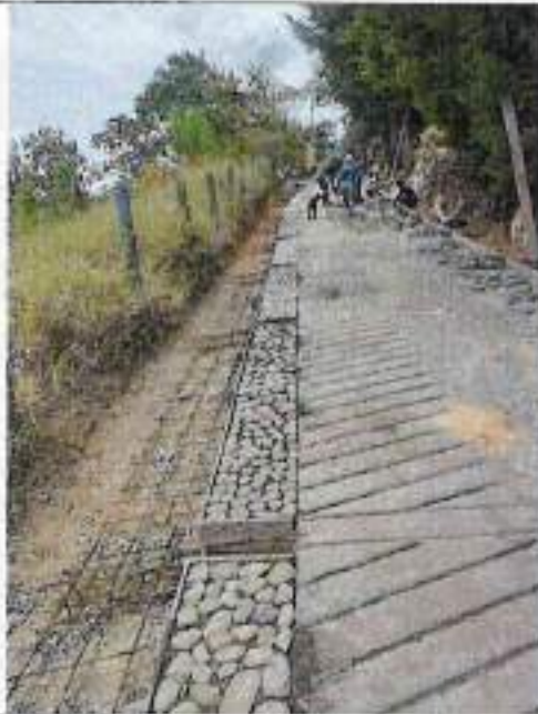
Vaciado concreto ciclopeo
