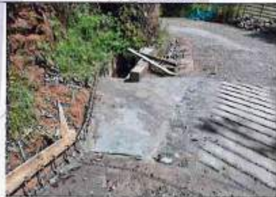
Vaciado de cunetas
