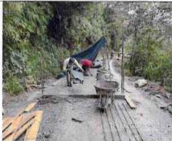
Construcción de Rieles
