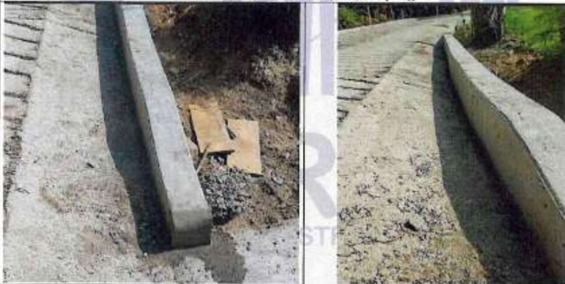
Vaciado de cunetas
