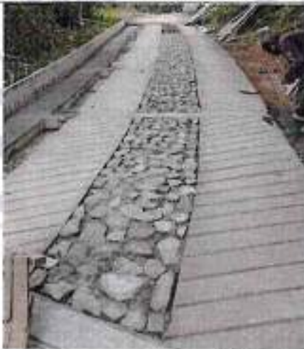
Vaciado concreto tipo ciclópeo
