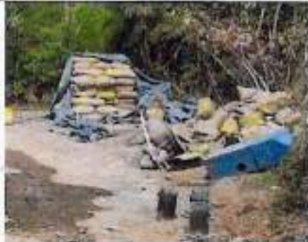
Acopio de material
