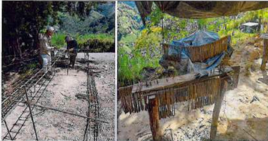
Figurado de acero de refuerzo
