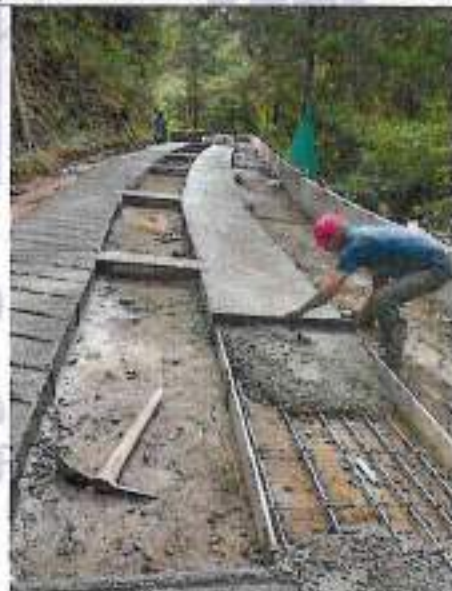
Instalación de acero y formaleta
