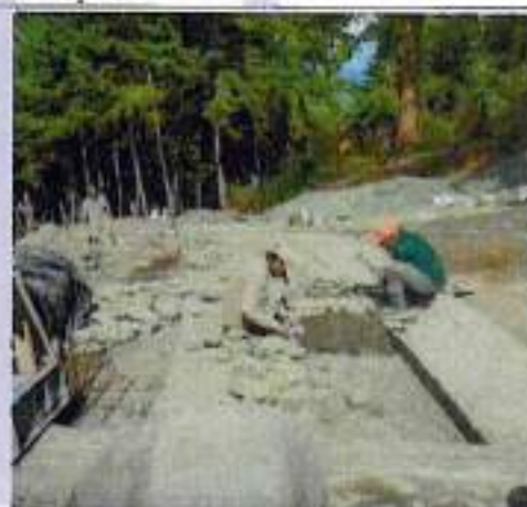
Vaciado concreto ciclópeo
