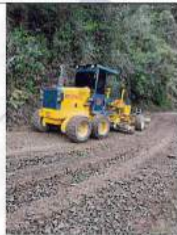
Instalación y compactación de base granular
