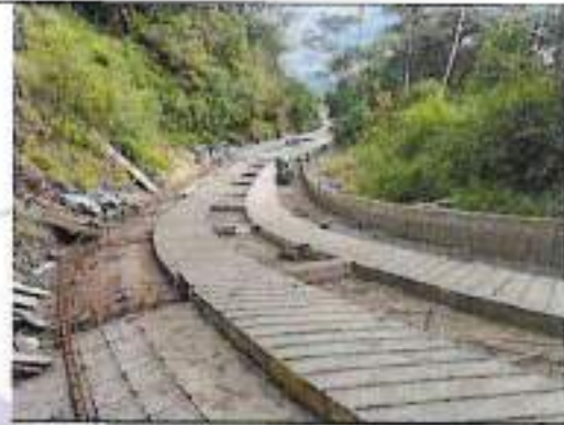
Instalación de acero y formaleta
