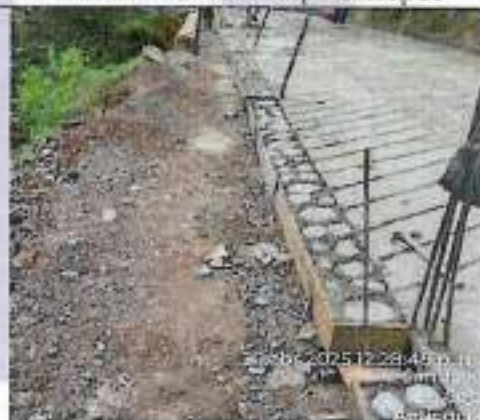
Vaciado concreto tipo ciclópeo
