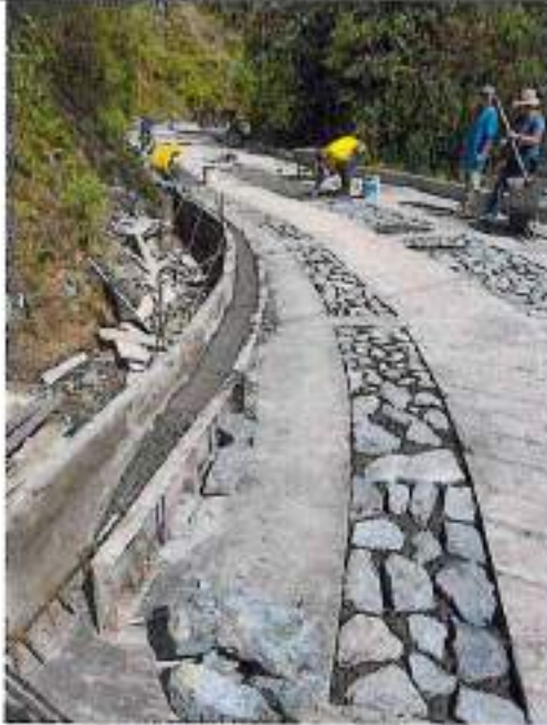
Vaciado concreto tipo ciclopeo
