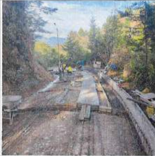
Viga Riostras y cordonería LOS MEDIOS
