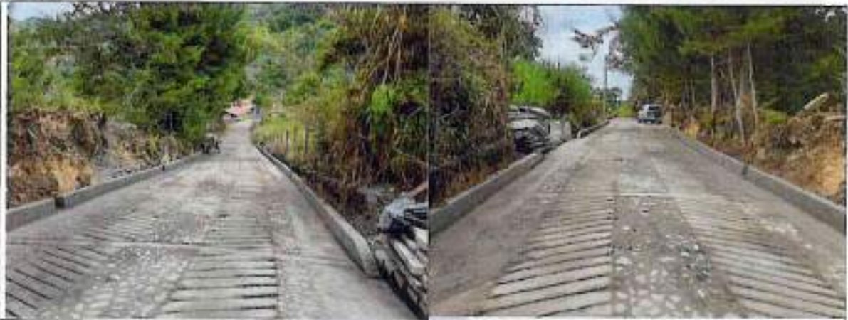
Construcción de Rieles
