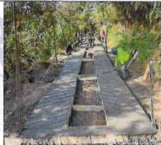
Construcción de Rieles
