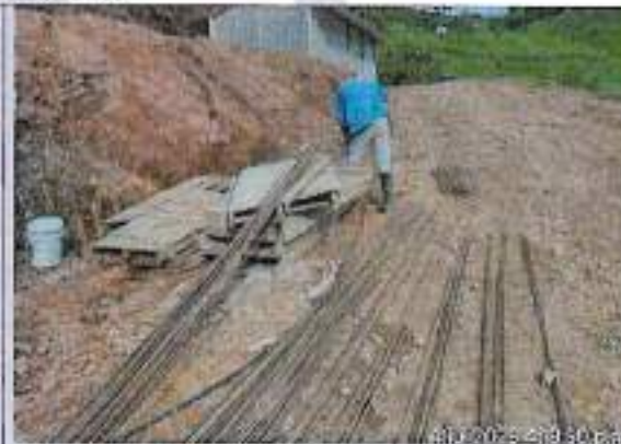
Figurado de acero de refuerzo
