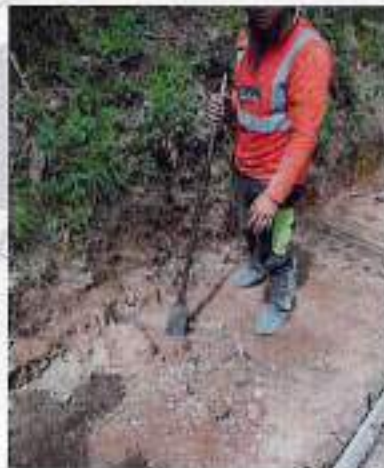
Imagen 2. Conformación Cunetas y Vigas
