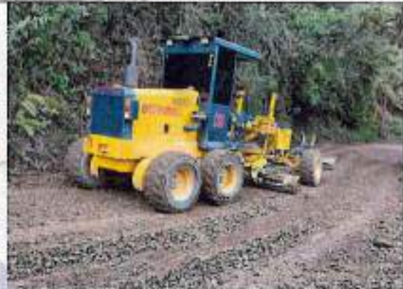
Instalación y compactación de base granular
