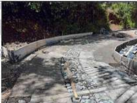
Vaciado concreto tipo ciclópeo
