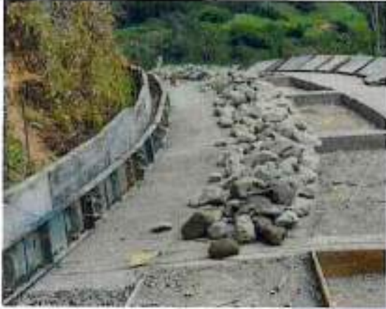
Construcción de cunetas
