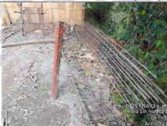
Figurado de acero de refuerzo
