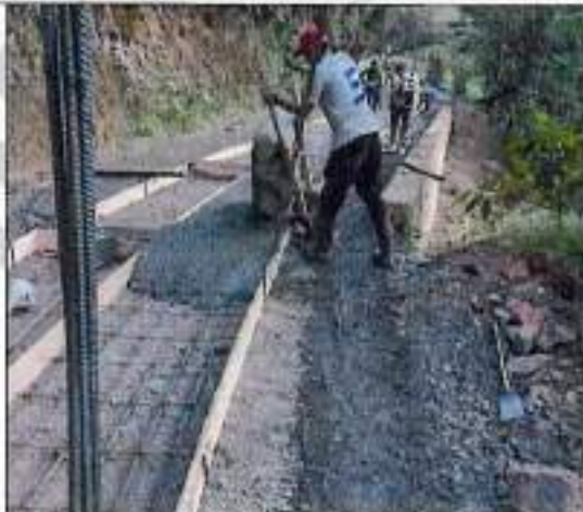
Instalación de acero y formaleta
