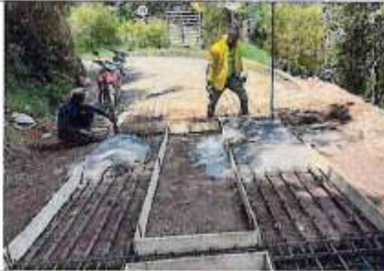
Instalación de acero y formaleta
