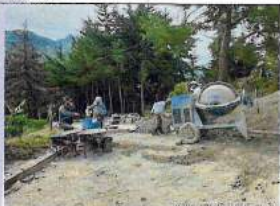
Conformación de vía e instalación de subbase
