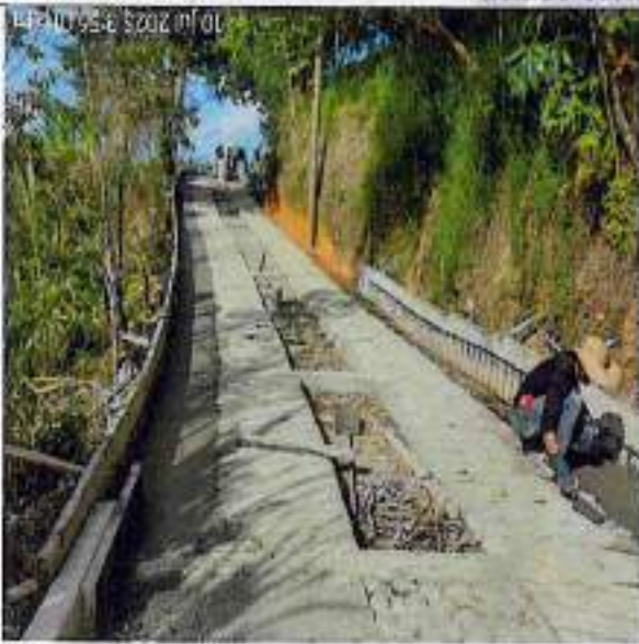
CONSTRUCCIÓN DE CUNETAS
