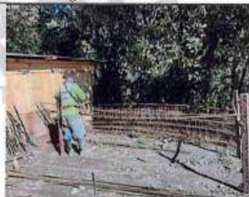
Figurado de acero de refuerzo
