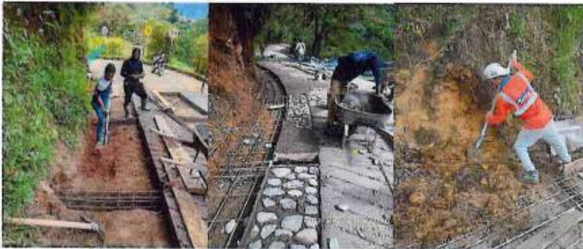
Imagen 3. Conformación Cunetas y Vigas
