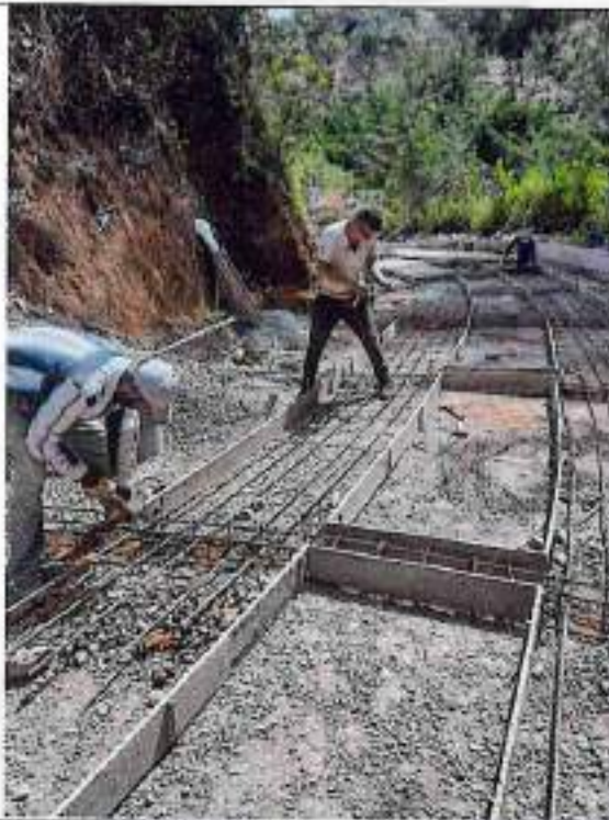
Instalación de acero en cunetas y vigas
