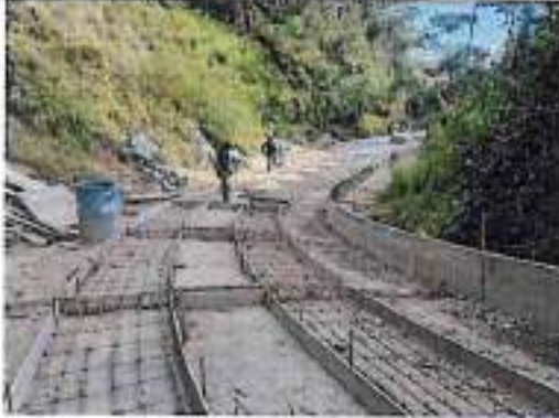
Instalación de acero y formaleta
