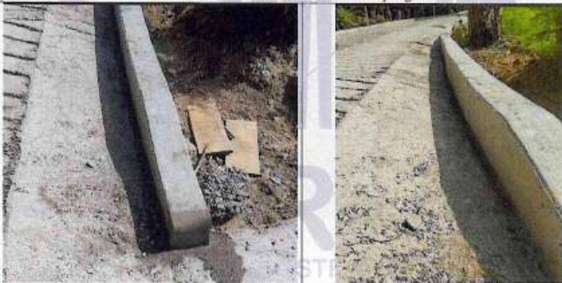
Vaciado de cunetas
