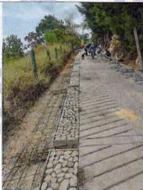
Vaciado concreto ciclopeo
