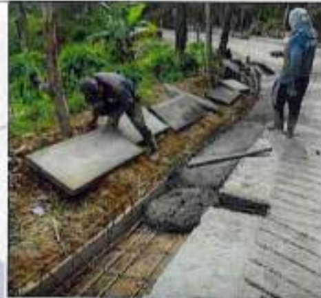
Construcción de cunetas
