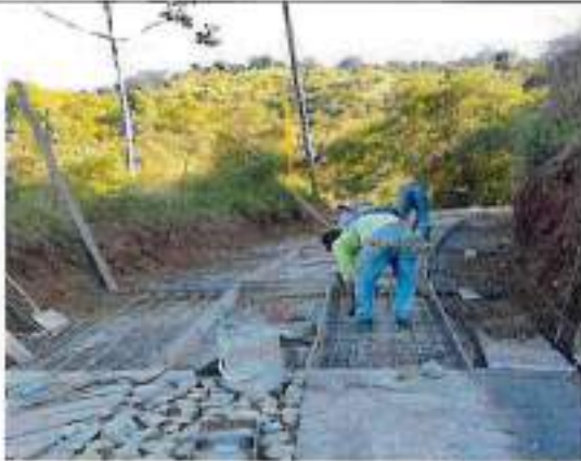
Instalación de acero y formaleta
