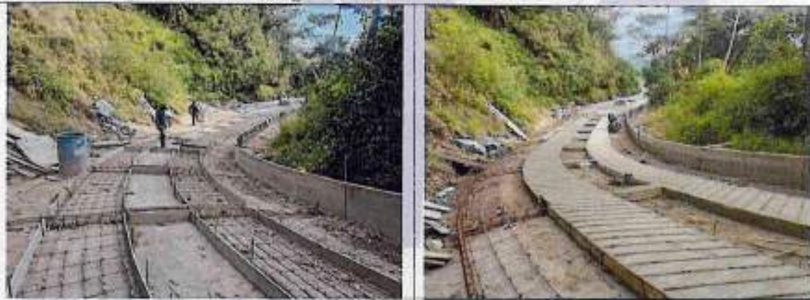
Instalación de acero y formaleta
