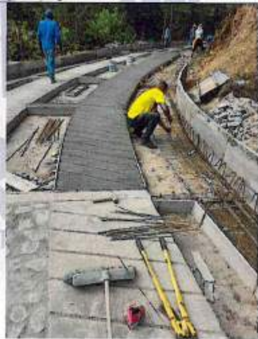
Instalación de acero en cunetas y vigas
