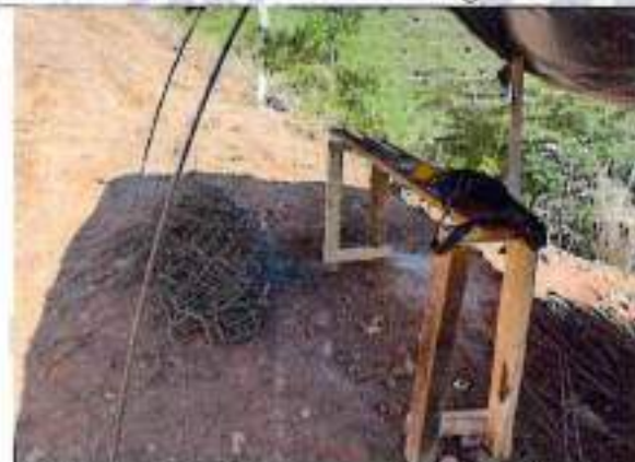
Figurado de acero de refuerzo
