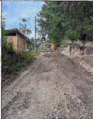
Conformación de vía e instalación de subbase
