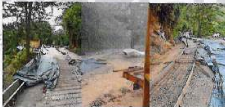
Imagen 4. Zonas Interventidas protegidas
