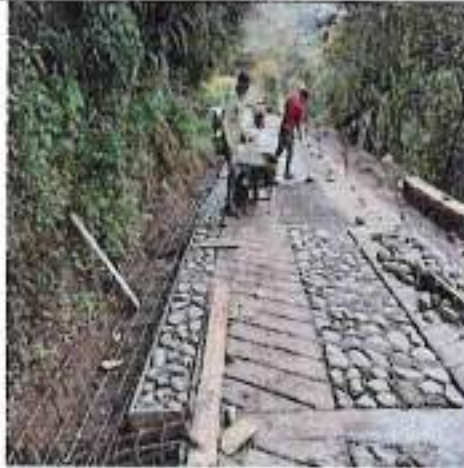
Vaciado concreto tipo ciclópeo
