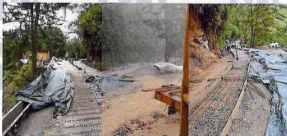
Imagen 3. Zonas Interventidas protegidas
