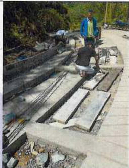
Instalación de acero y formaleta
