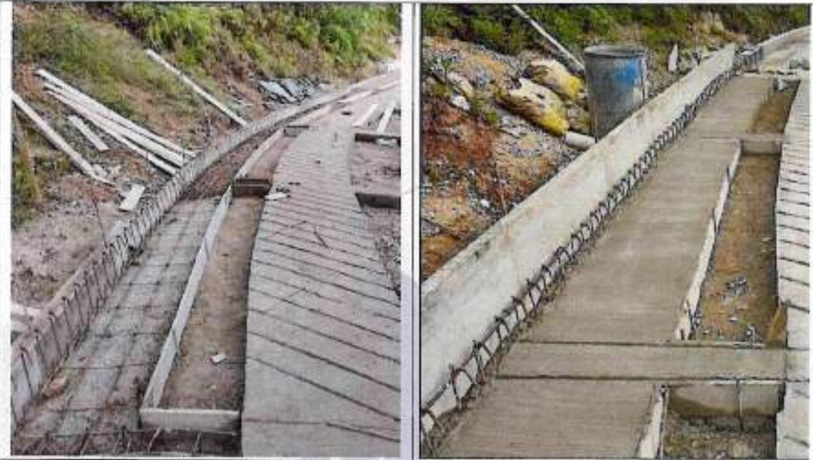
Instalación de acero en cunetas y vigas
