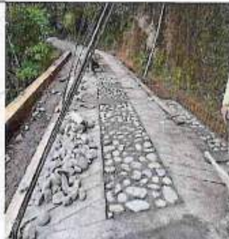
Vaciado concreto tipo ciclópeo
