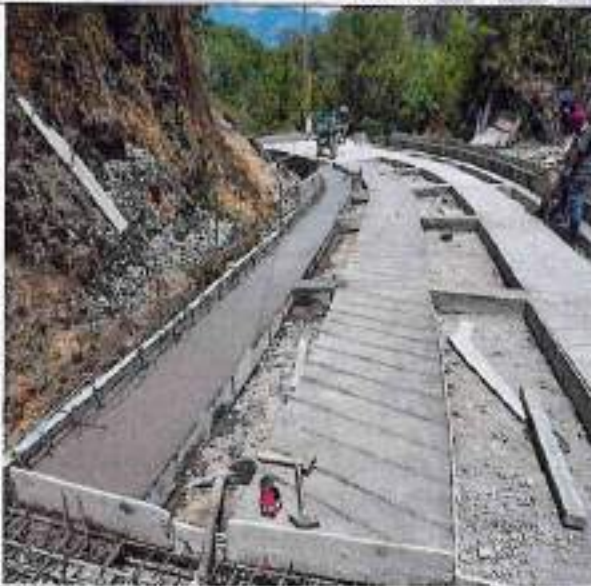
Vaciado de cunetas
