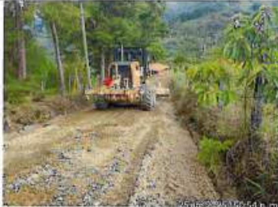
Instalación y compactación Subbase Granular
