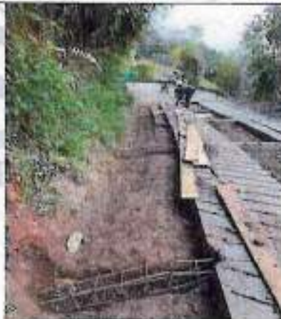
Conformación de cunetas
