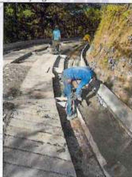
Instalación de acero en cunetas y vigas
