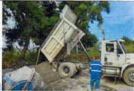
Acopio de material
