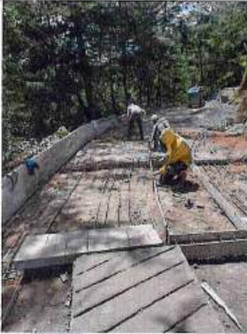
Instalación de acero y formaleta
