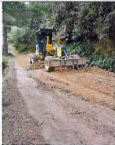
Instalación y compactación de base granular
