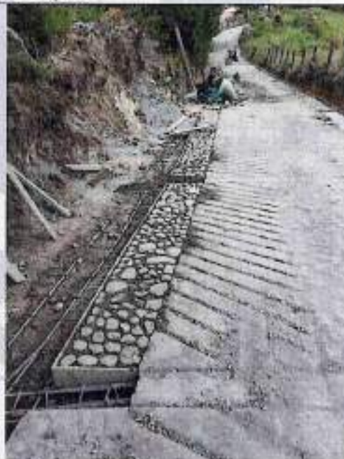
Vaciado concreto ciclopeo
