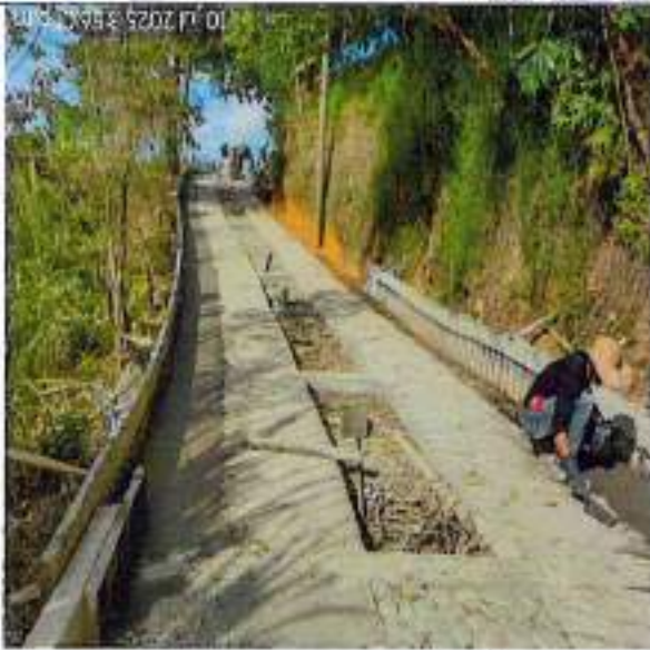
Construcción de cunetas
