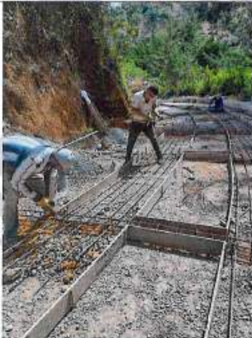
Instalación de acero en cunetas y vigas
