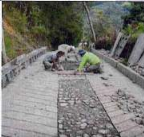
Vaciado concreto ciclópeo
