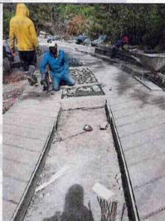
Vaciado concreto tipo ciclopo
