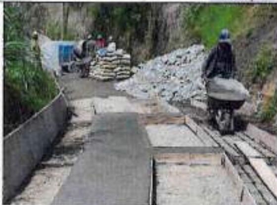
Conformación de vía e instalación de subbase
