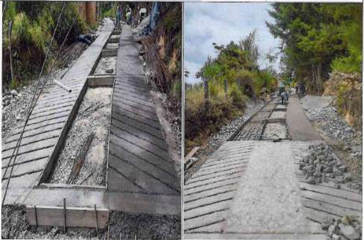
Construcción de Rieles
