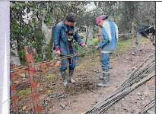
Figurado de acero de refuerzo
