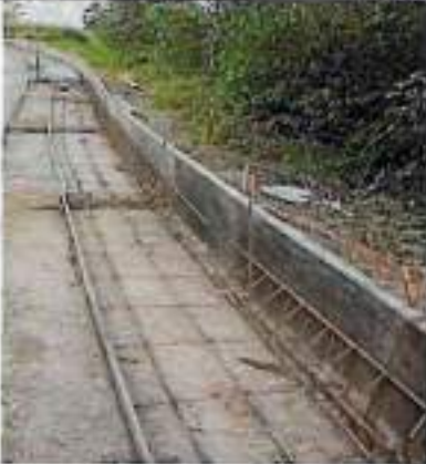
Instalación de acero
