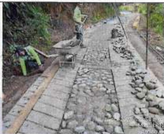
Vaciado concreto tipo ciclópeo
