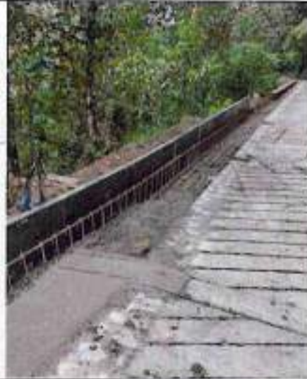
Vaciado de cunetas
