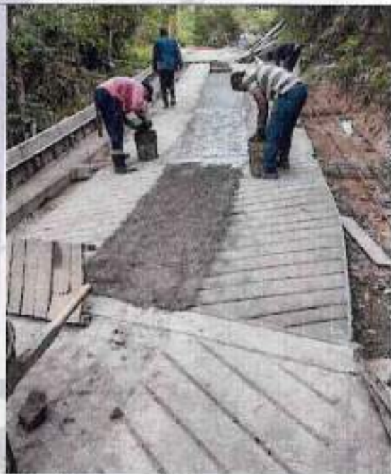
Vaciado concreto tipo ciclopeo
