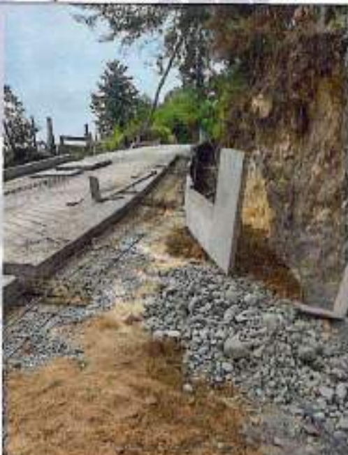
Construcción de cunetas
