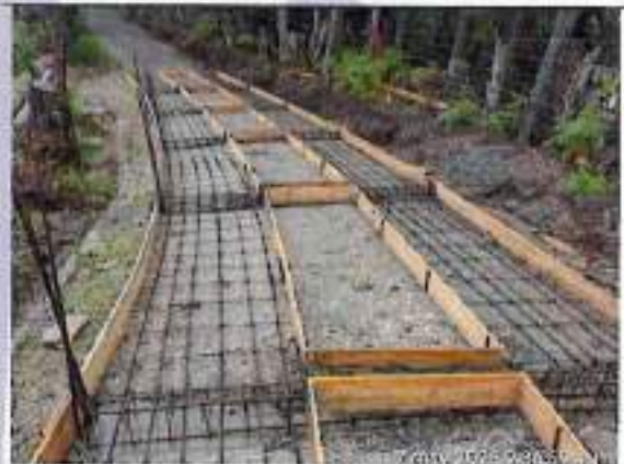
Instalación de formaleta y acero de refuerzo
