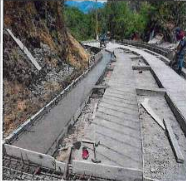
Vaciado de cunetas
