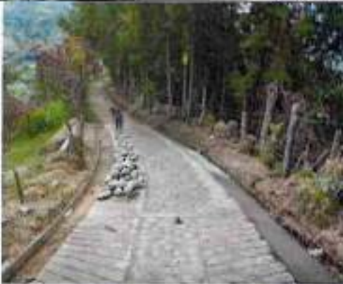
Construcción de cunetas
