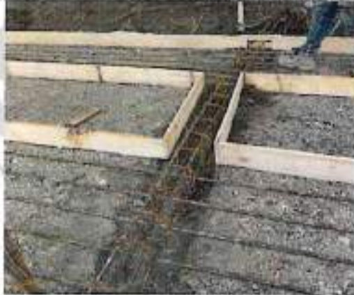
Instalación de formaleta y acero de refuerzo
