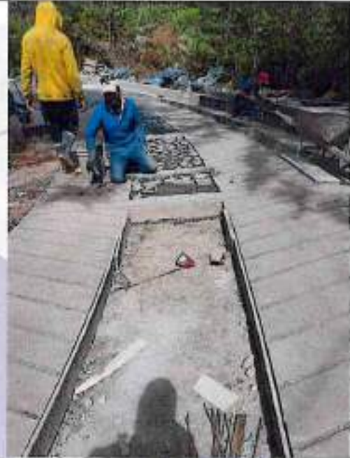
Vaciado concreto tipo ciclopeo
