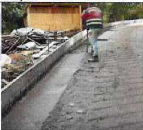
Construcción de cunetas
