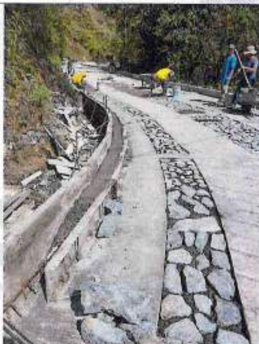
Vaciado concreto tipo ciclopo
