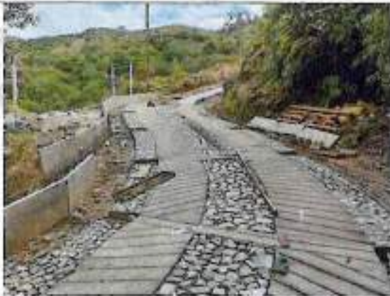
Vaciado concreto tipo ciclópeo
