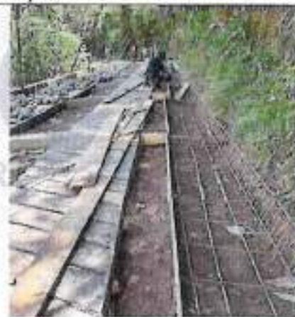
Instalación de acero
