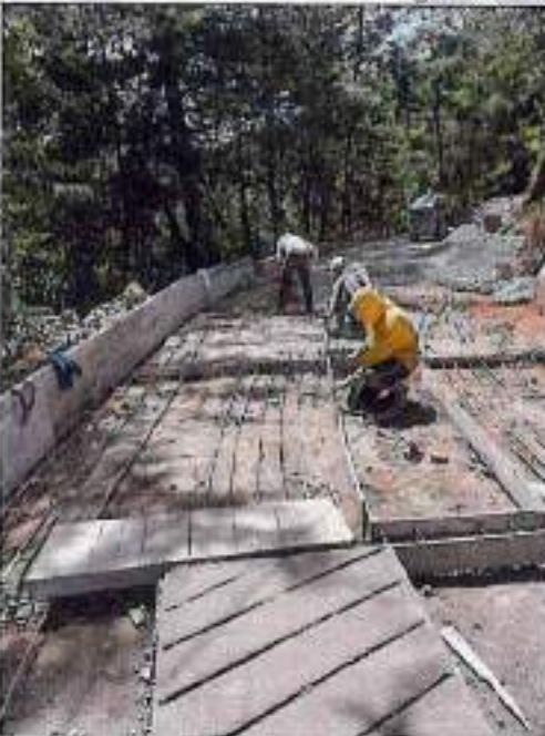
Instalación de acero y formaleta
