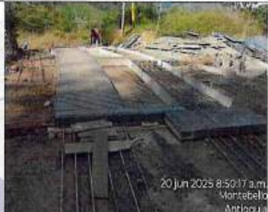
Instalación de acero y formaleta
