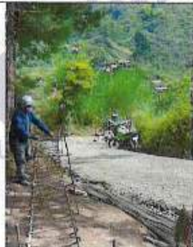
Conformación de vía e instalación de subbase
