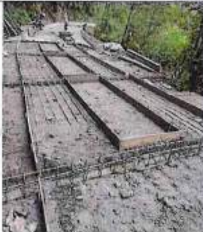
Instalación de acero y formaleta
