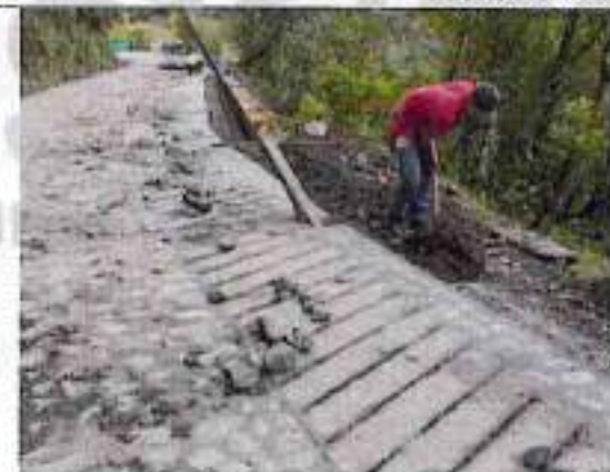
Conformación de cunetas
