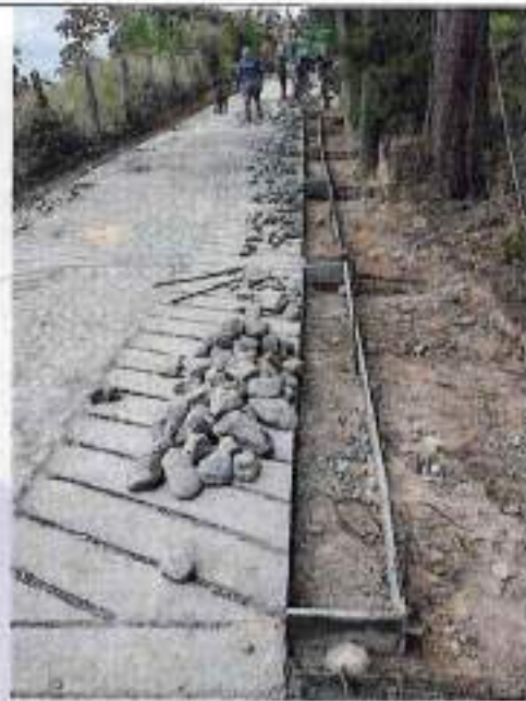
Vaciado concreto ciclopeo
