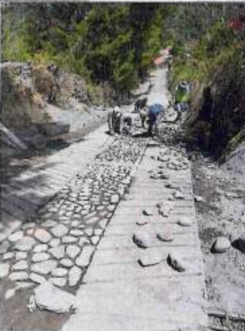
Vaciado concreto ciclopeo
