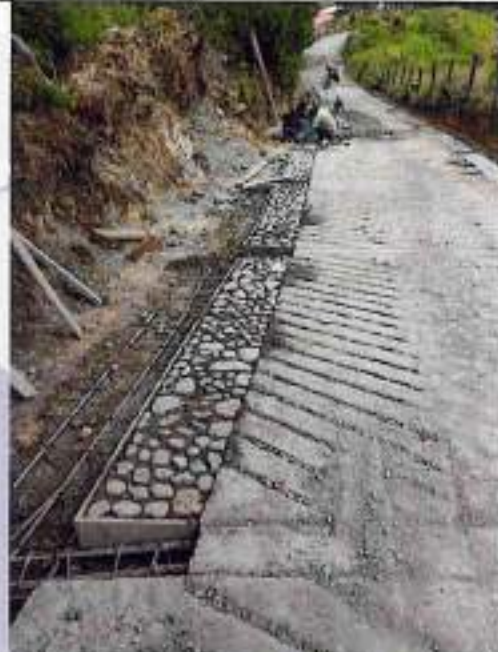
Vaciado concreto ciclopeo
