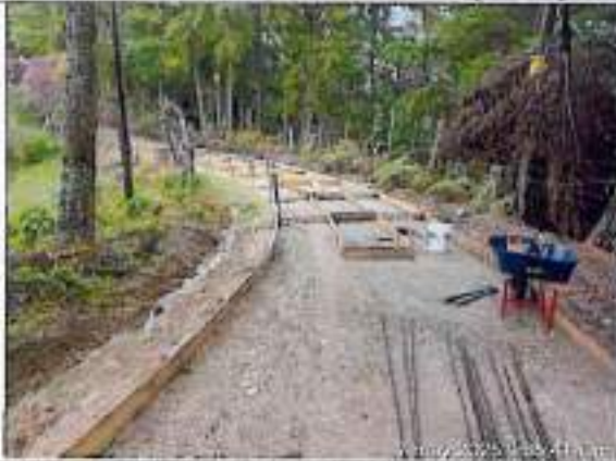
Instalación de formaleta y acero de refuerzo
