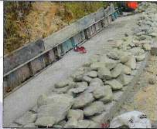
Construcción de cunetas
