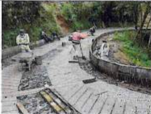
Vaciado concreto ciclópeo
